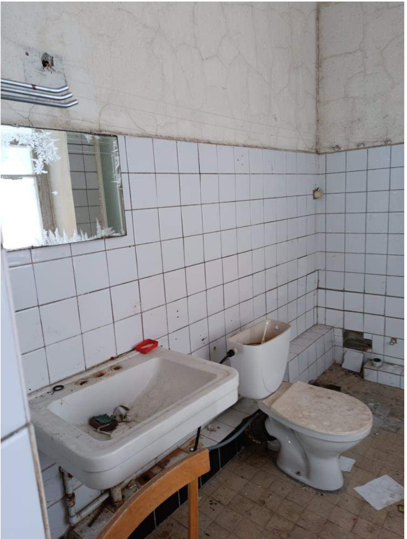
Фото 4.11 Состояние санитарно-технического узла. Демонтаж. Административный корпус
