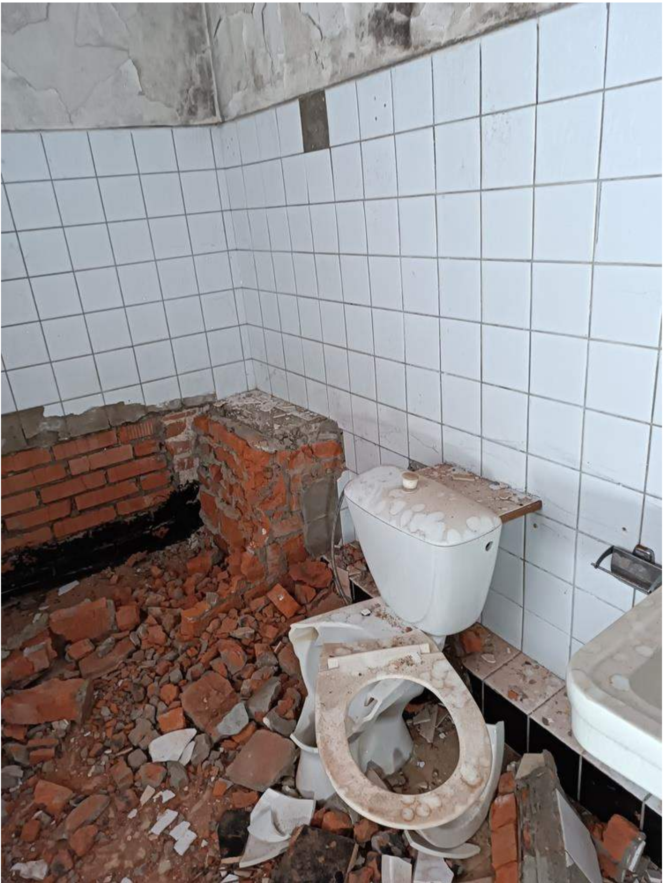
Фото 4.10 Состояние санитарно-технического узла. Демонтаж. Административный корпус
