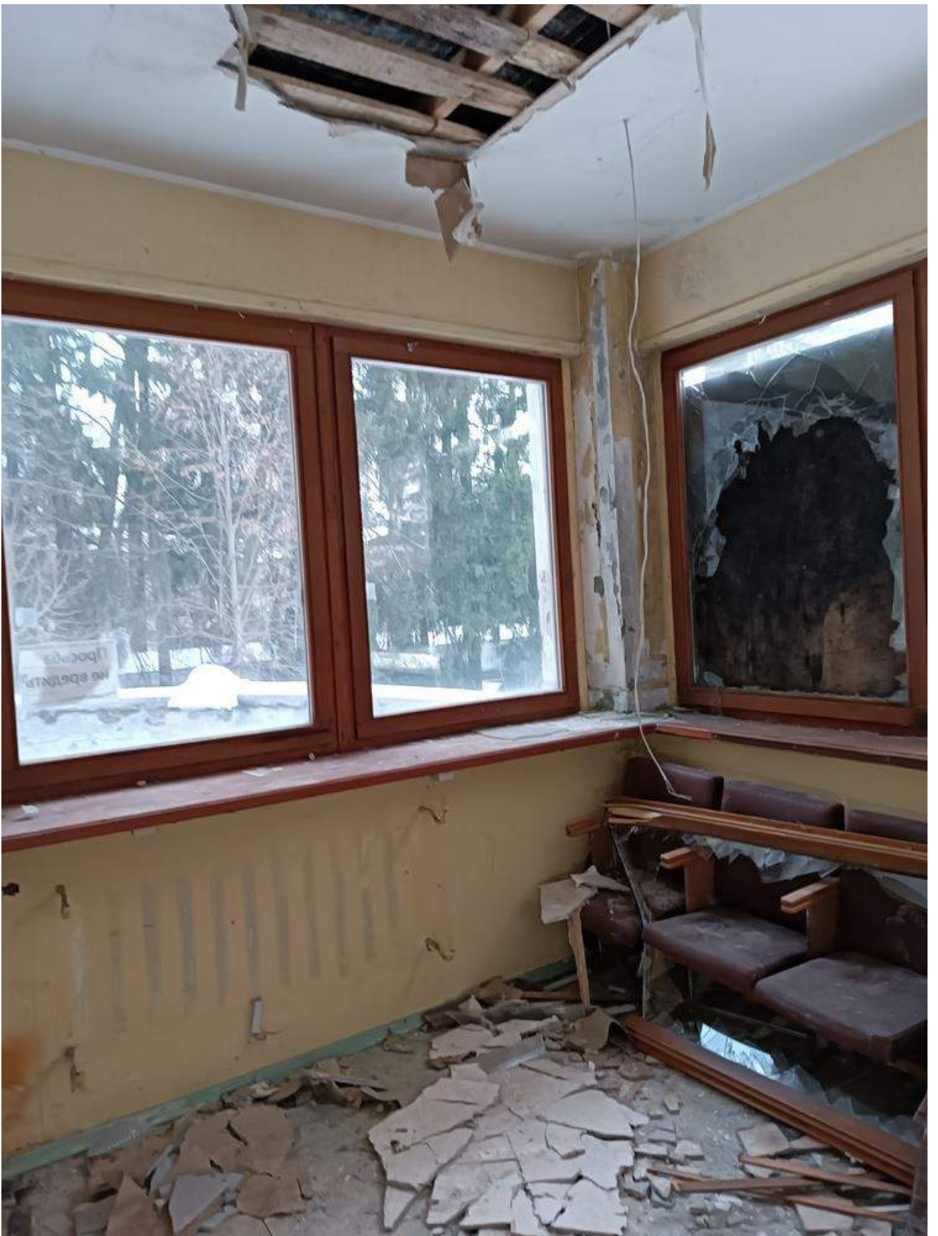
Фото 1.66 Внутренняя часть здания. Основное здание
