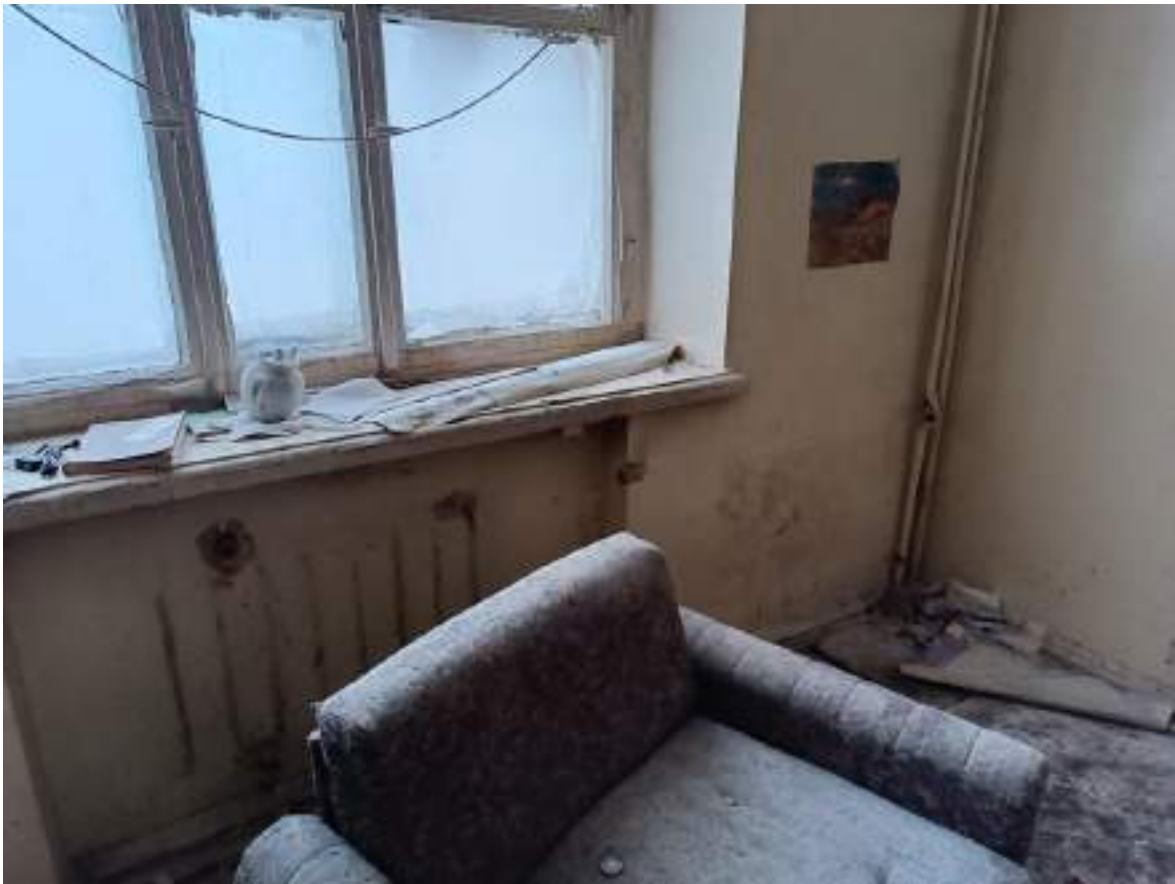
Фото 3.7 Состояние системы отопления. Демонтаж. Административный корпус
