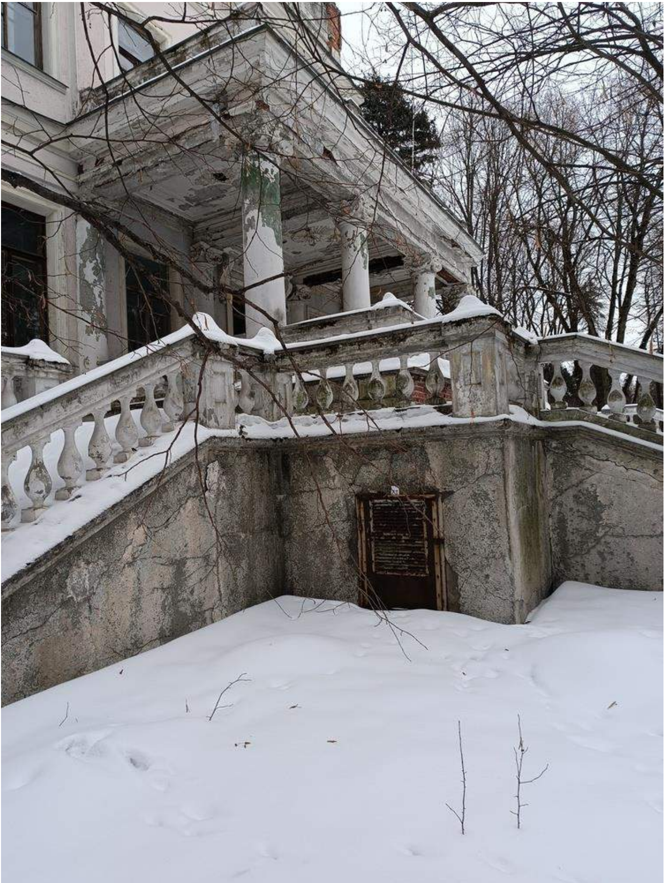
Фото 1.48 Общий вид. Основное здание
