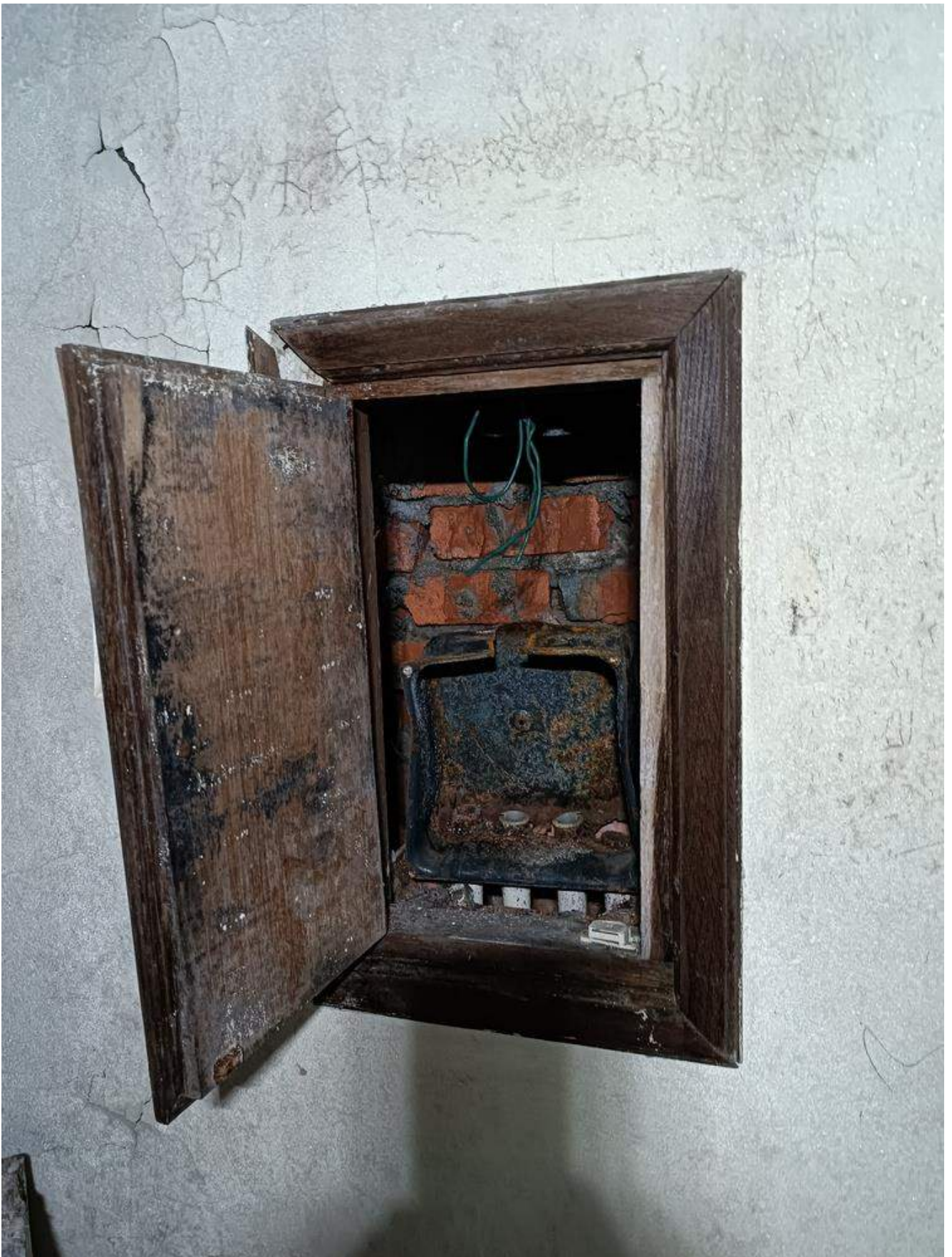
Фото 2.9 Щит управления внутренних электрических сетей. Демонтаж. Административный корпус
