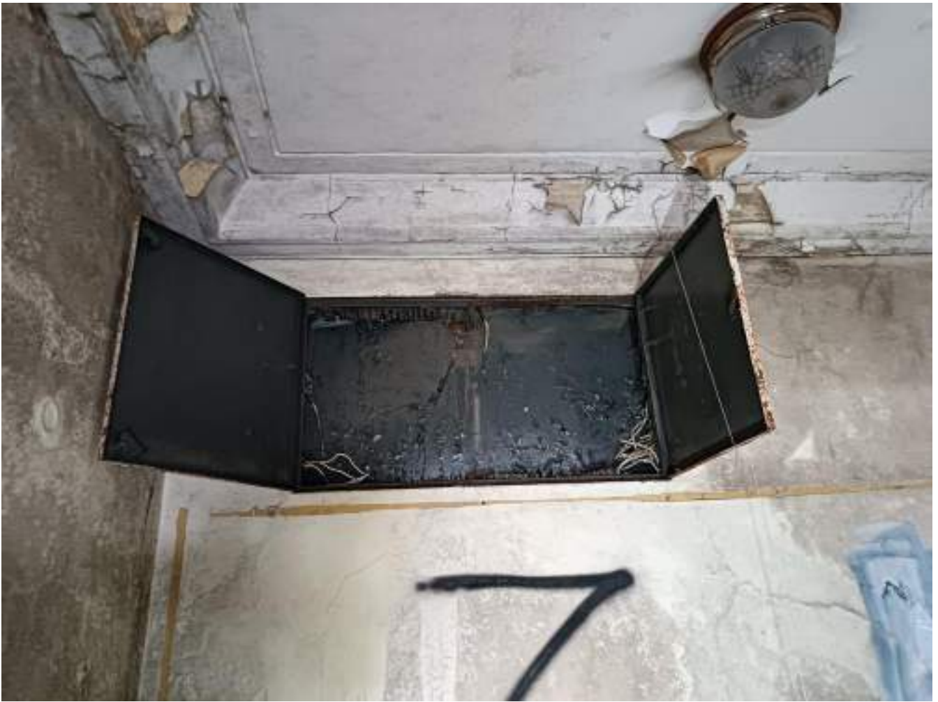
Фото 2.19 Щит управления внутренних электрических сетей и освещение. Демонтаж. Основное здание
