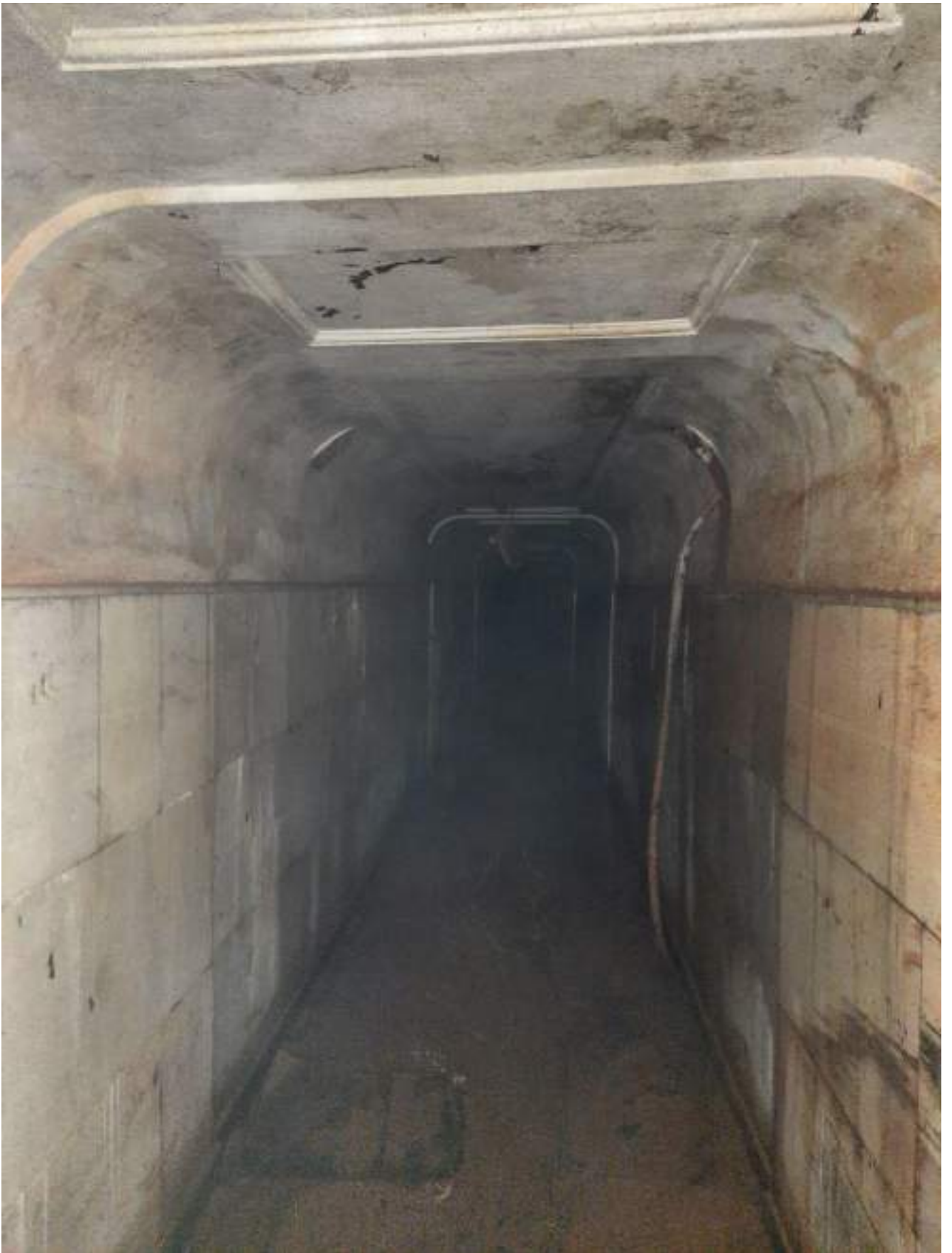
Фото 1.92 Внутренняя часть здания. Бомбоубежище
