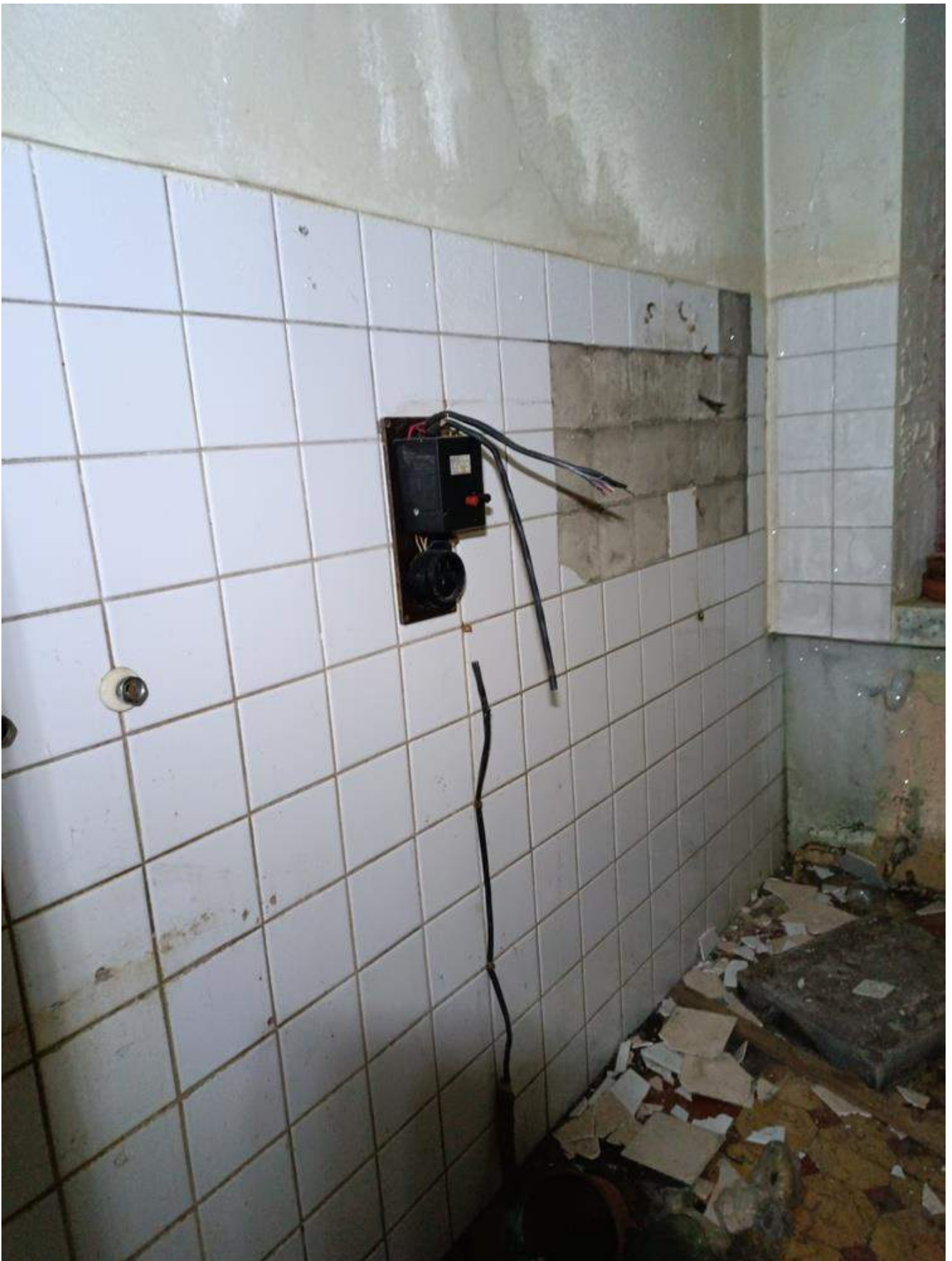
Фото 2.7 Состояние внутренних электрических сетей. Административный корпус
