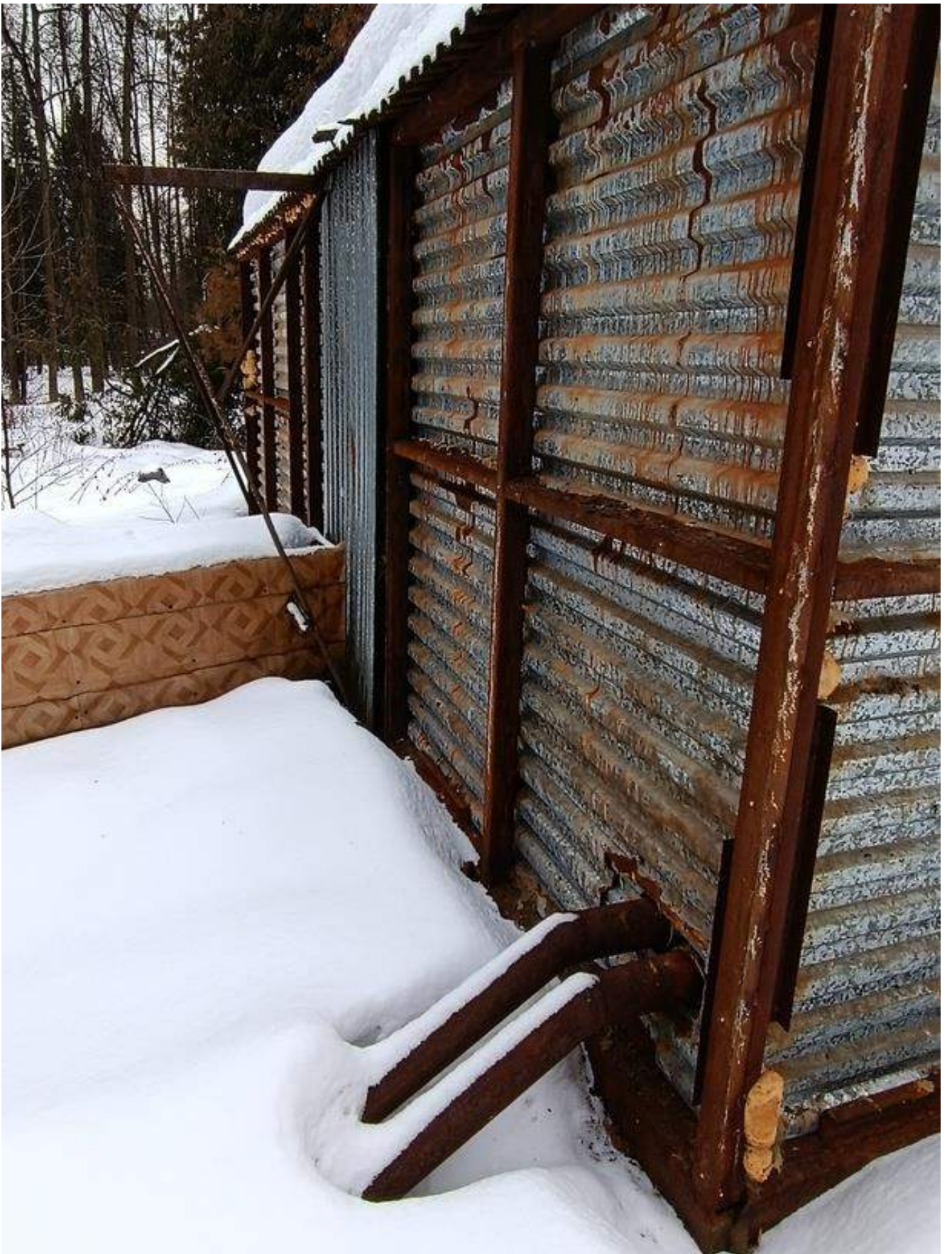
Фото 3.3 Автономный теплоисточник. Котельная. Тепловые сети
