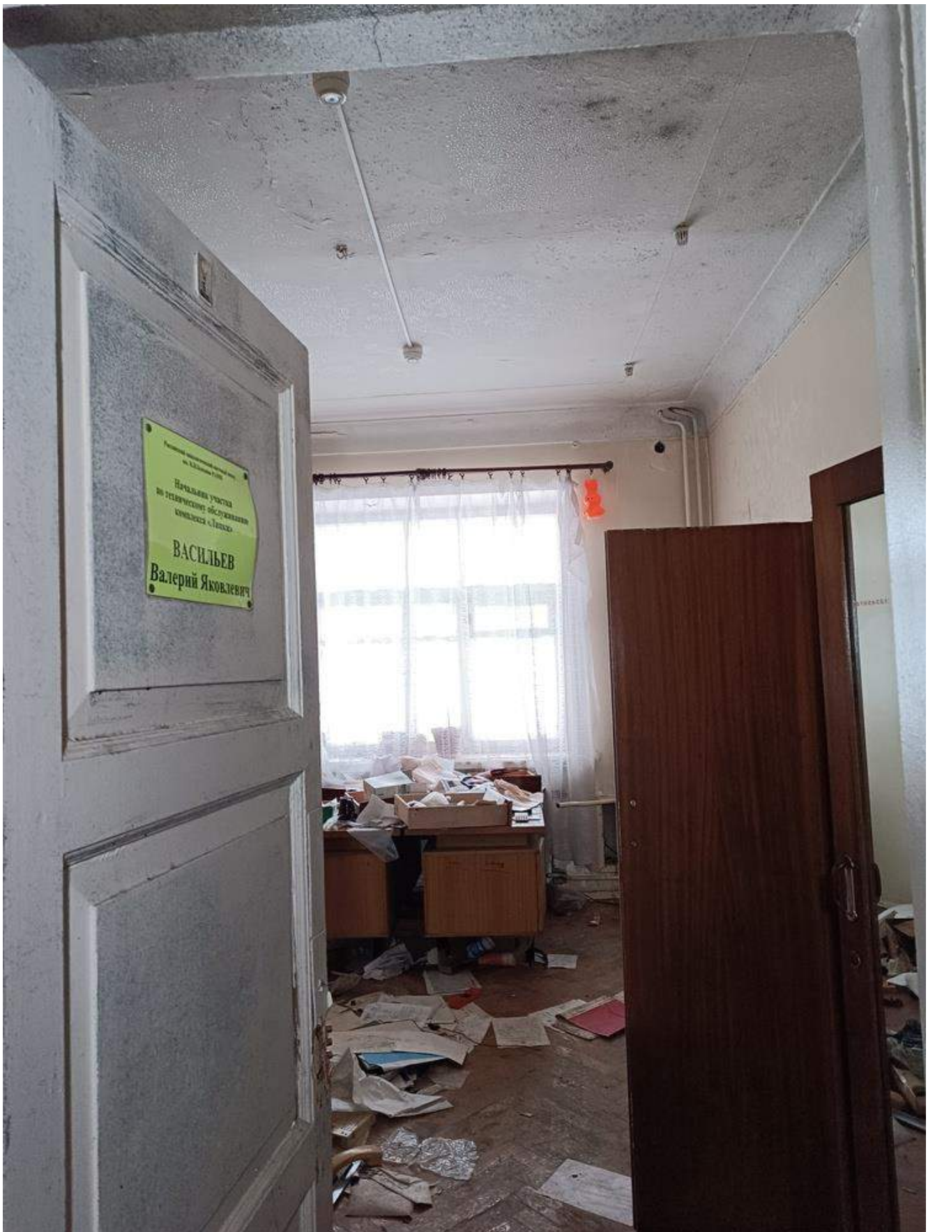
Фото 1.26 Внутренняя часть здания. Административный корпус
