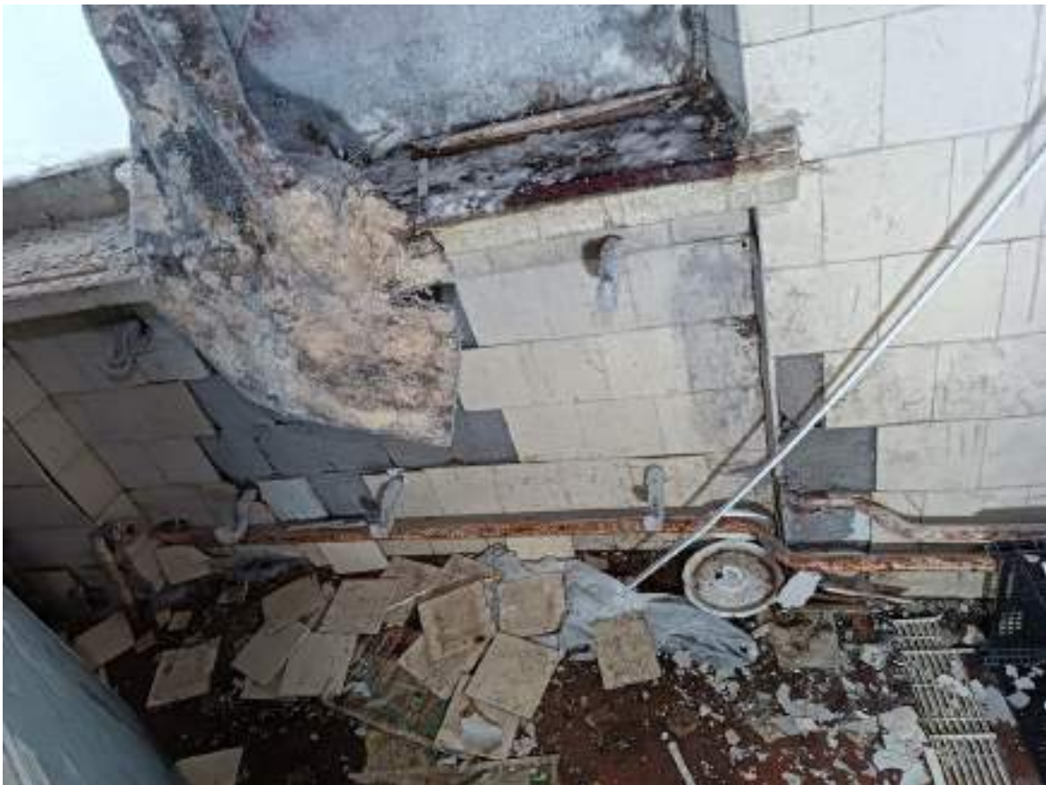
Фото 3.14 Демонтаж радиаторов отопления. Административный корпус
