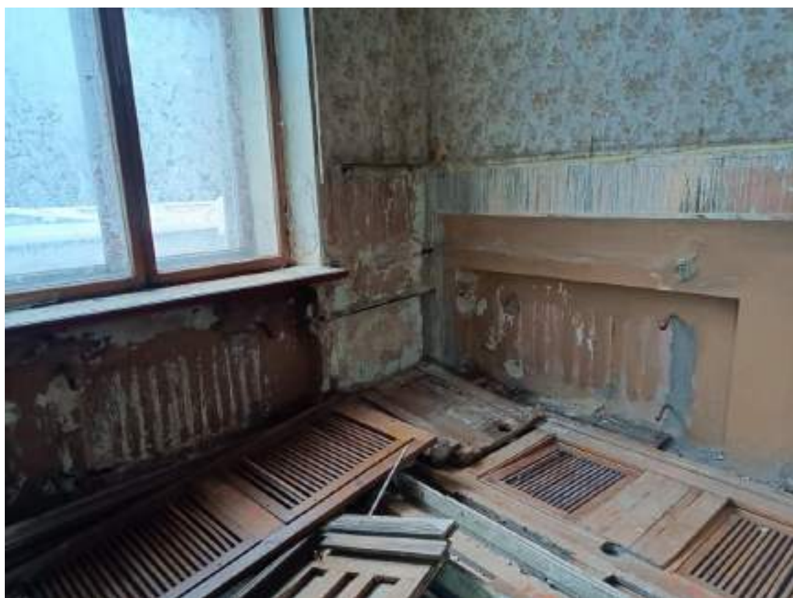
Фото 3.29 Состояние системы отопления. Демонтаж. Основное здание
