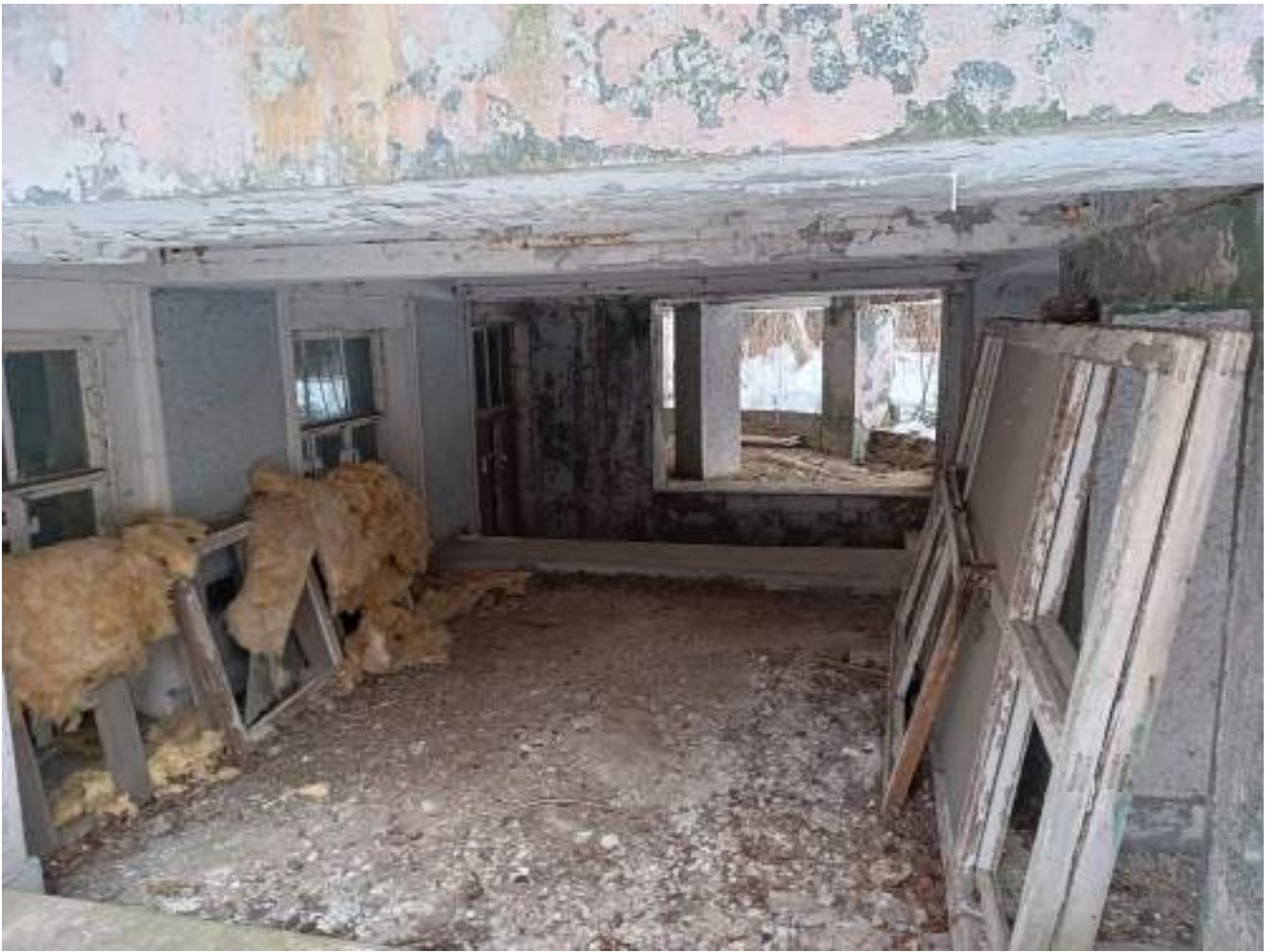
Фото 1.73 Внутренняя часть здания. Основное здание
