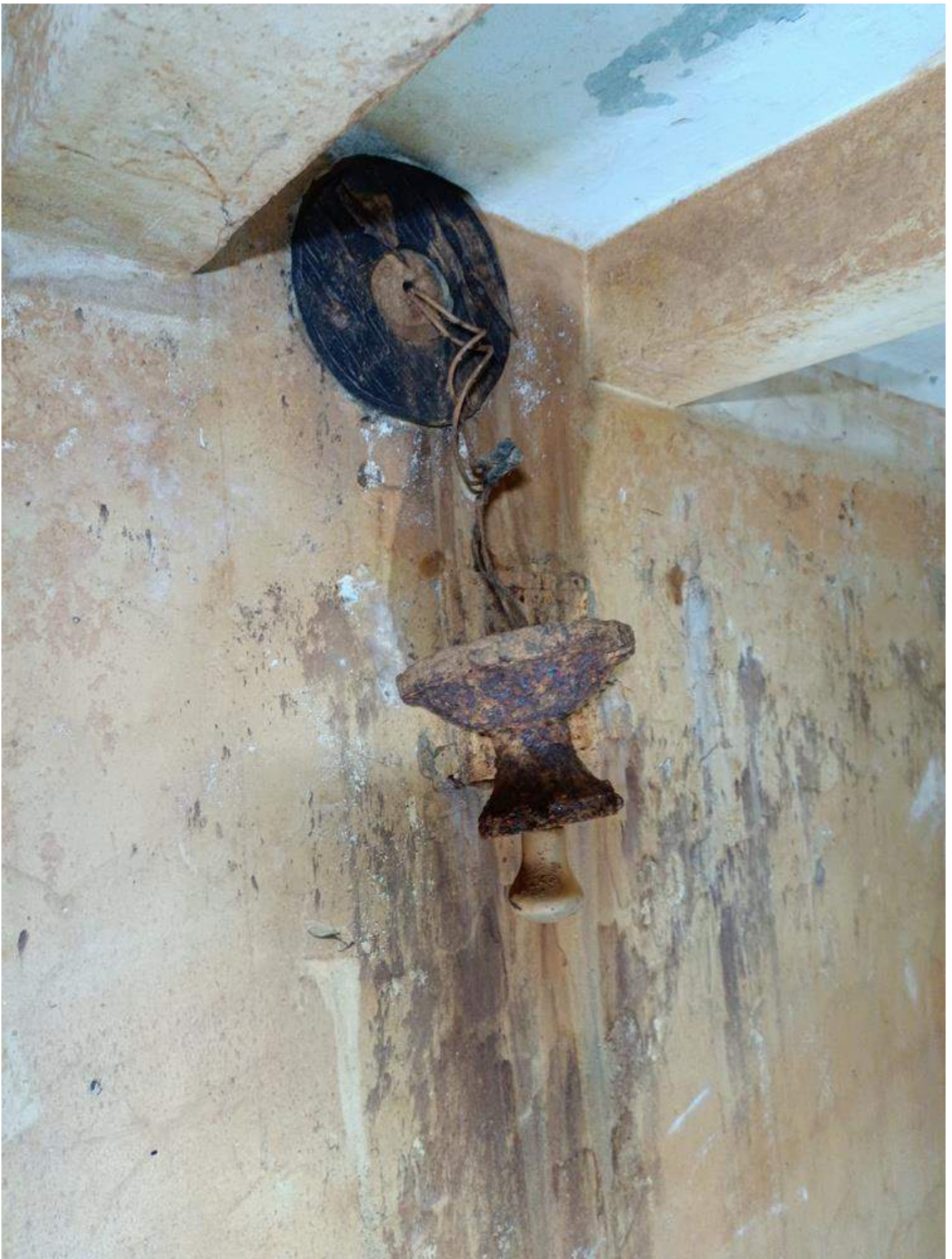
Фото 2.27 Состояние внутренних электрических сетей и освещения. Демонтаж. Бомбоубежище
