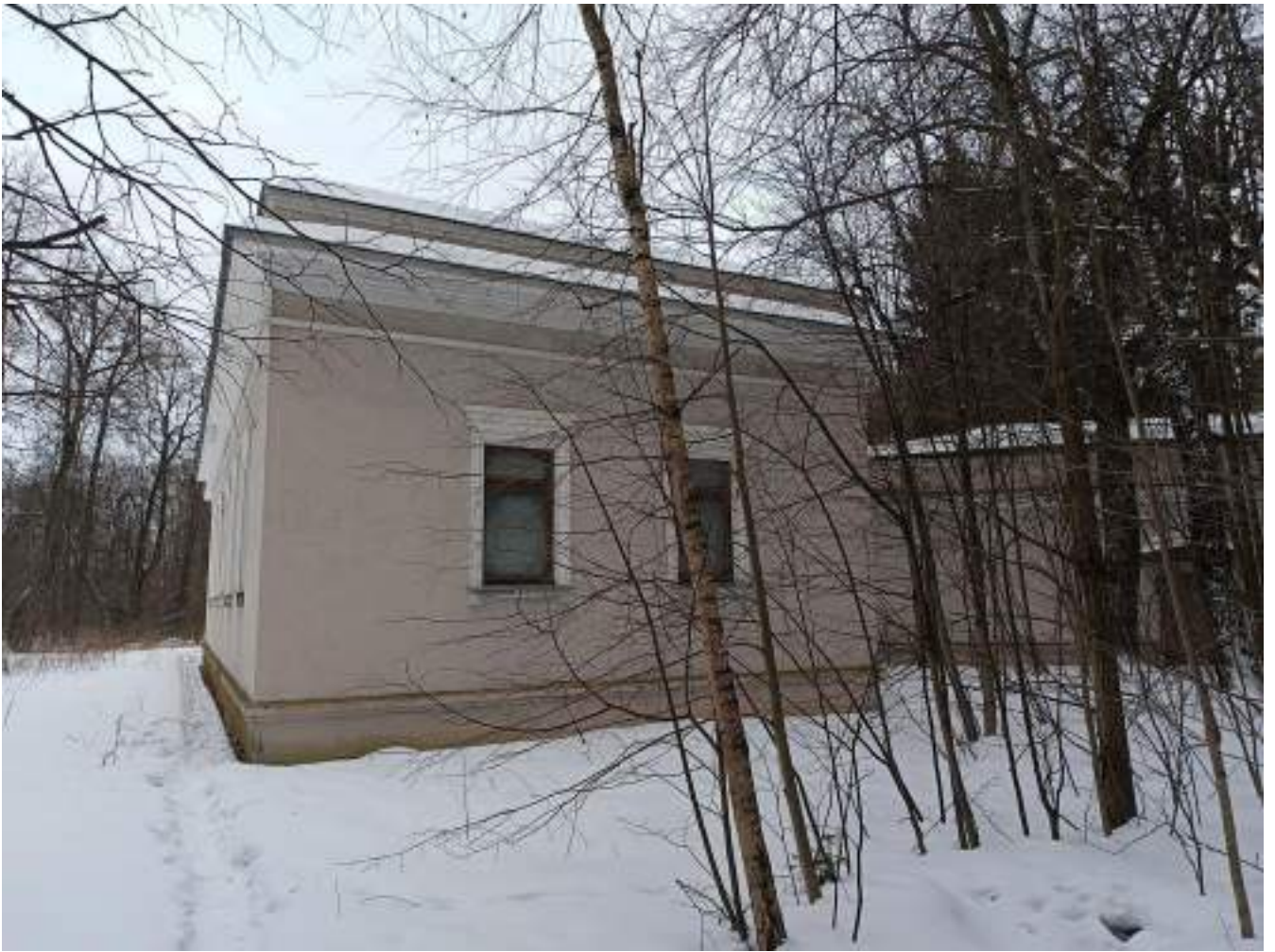
Фото 1.23 Общий вид. Административный корпус
