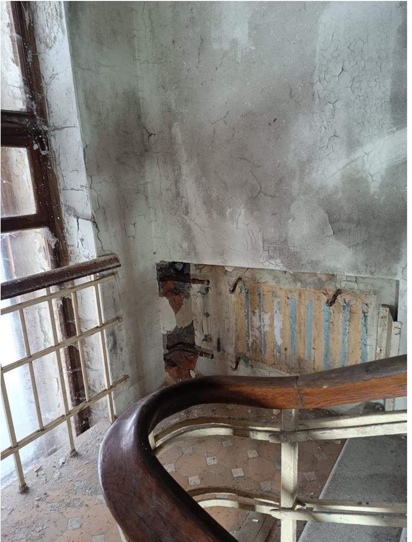
Фото 3.27 Демонтаж радиаторов отопления. Основное здание
