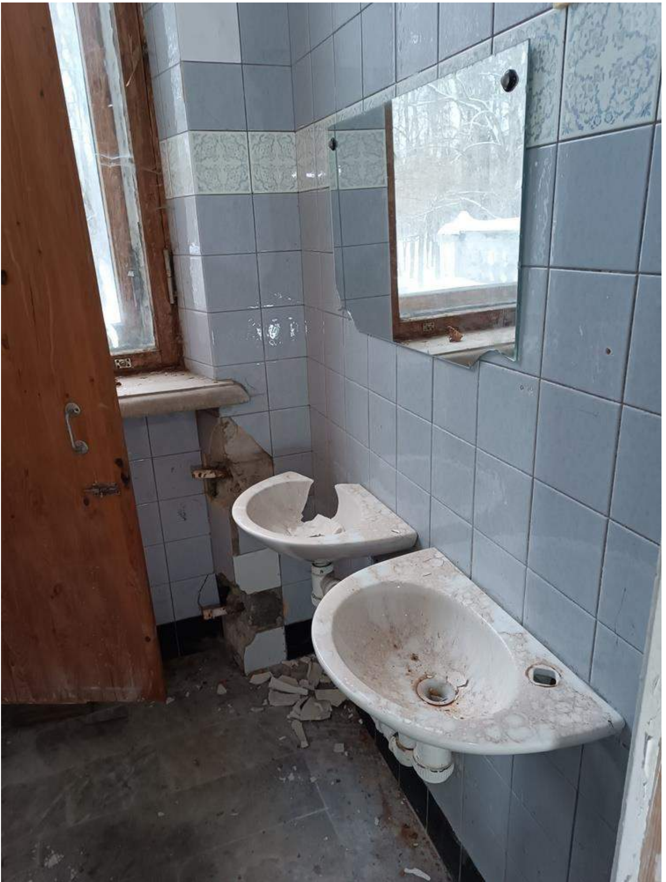
Фото 4.18 Состояние санитарно-технического узла. Демонтаж оборудования. Основное здание
