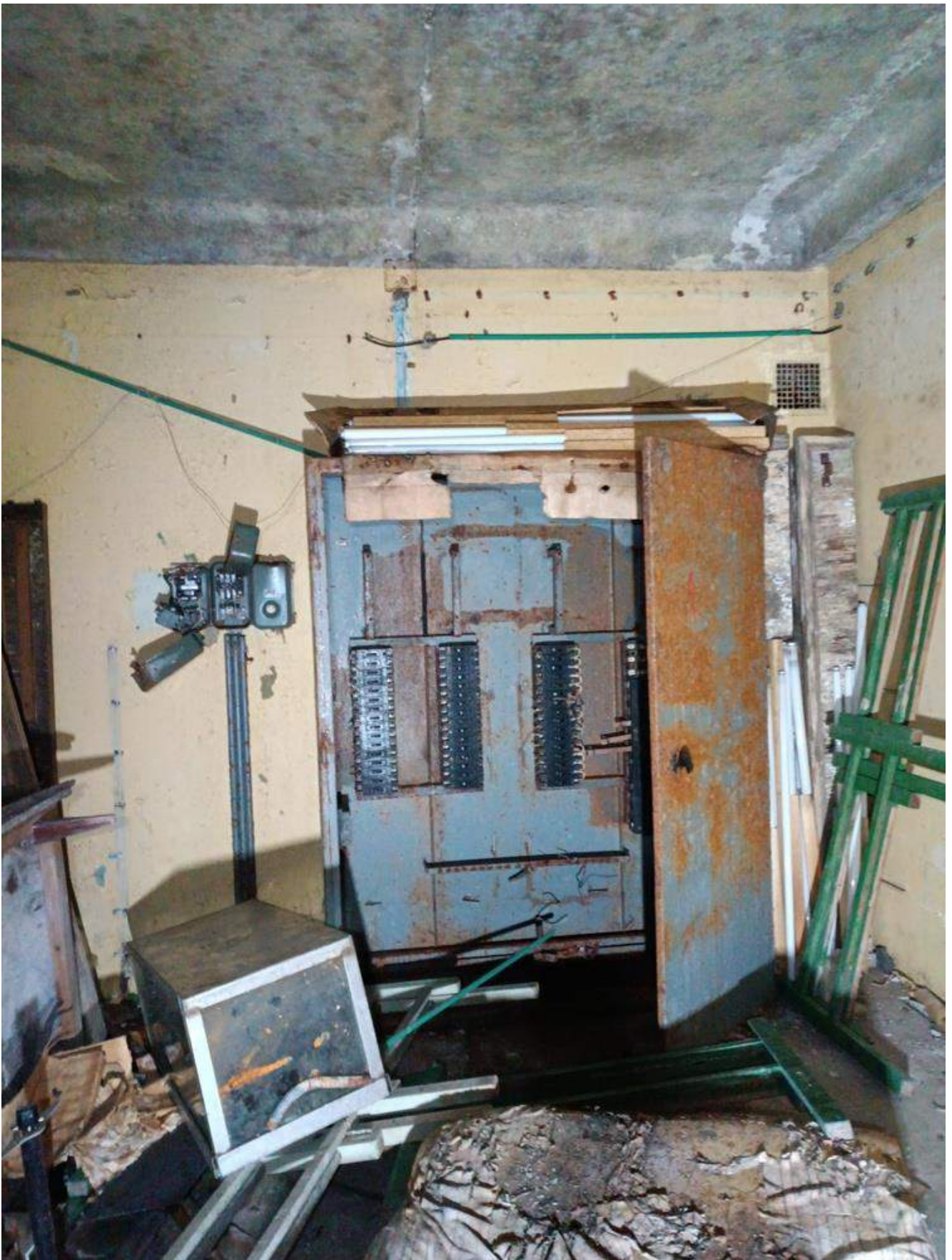
Фото 2.15 Щит управления внутренних электрических сетей, пусковые устройства. Демонтаж. Основное здание
