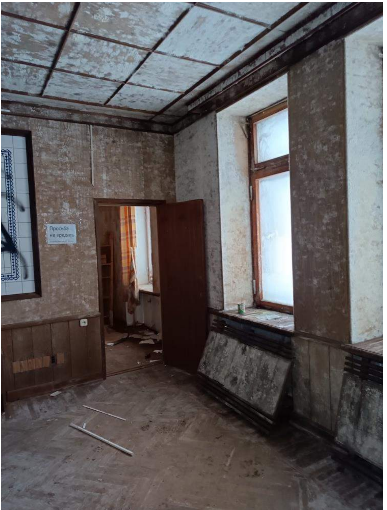
Фото 1.34 Внутренняя часть здания. Административный корпус
