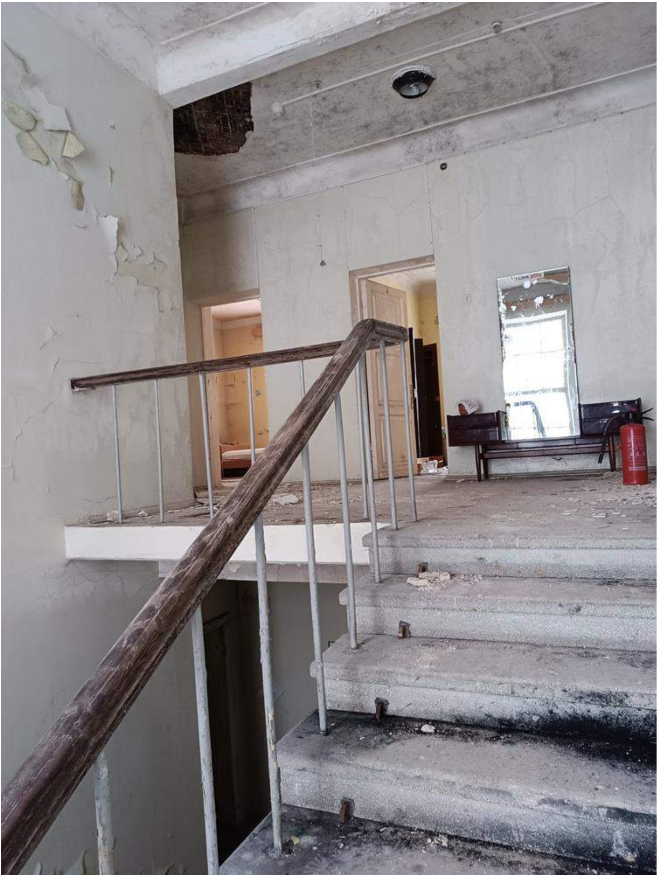
Фото 1.39 Внутренняя часть здания. Административный корпус
