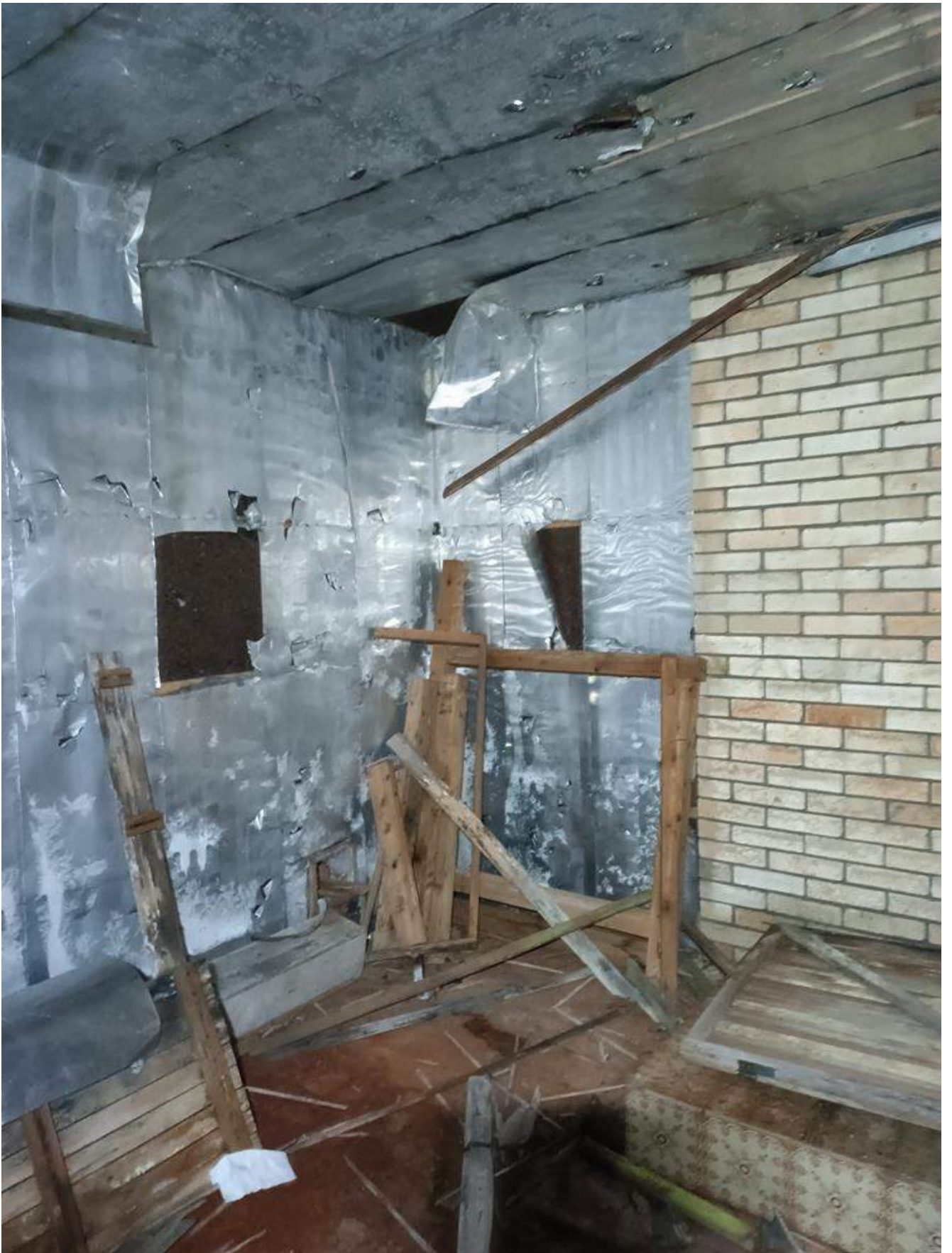
Фото 1.75 Внутренняя часть здания. Бассейн
