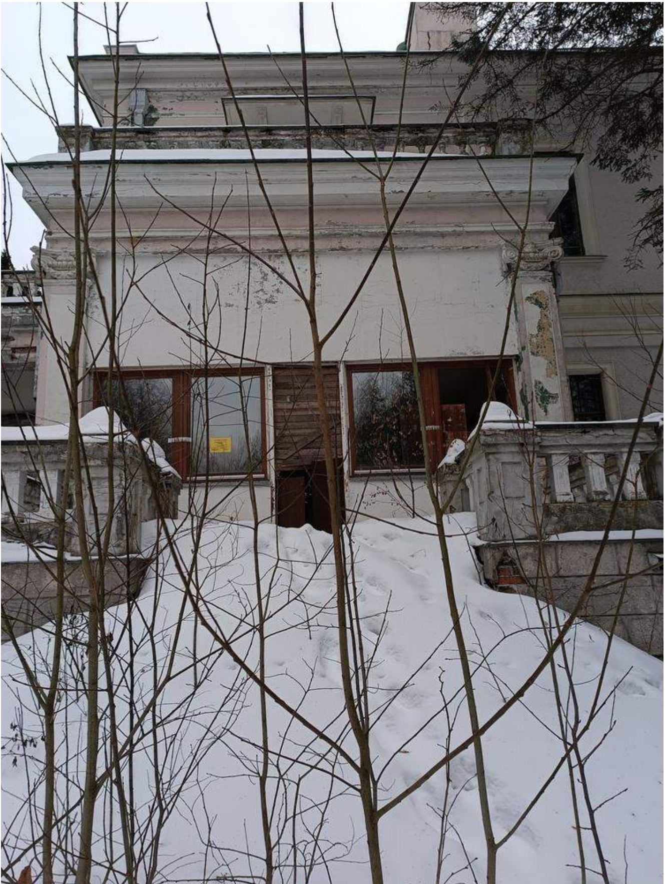
Фото 1.46 Общий вид. Основное здание
