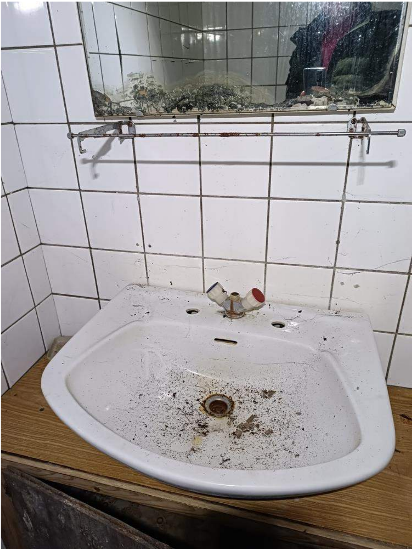
Фото 4.24 Состояние санитарно-технического узла. Бассейн
