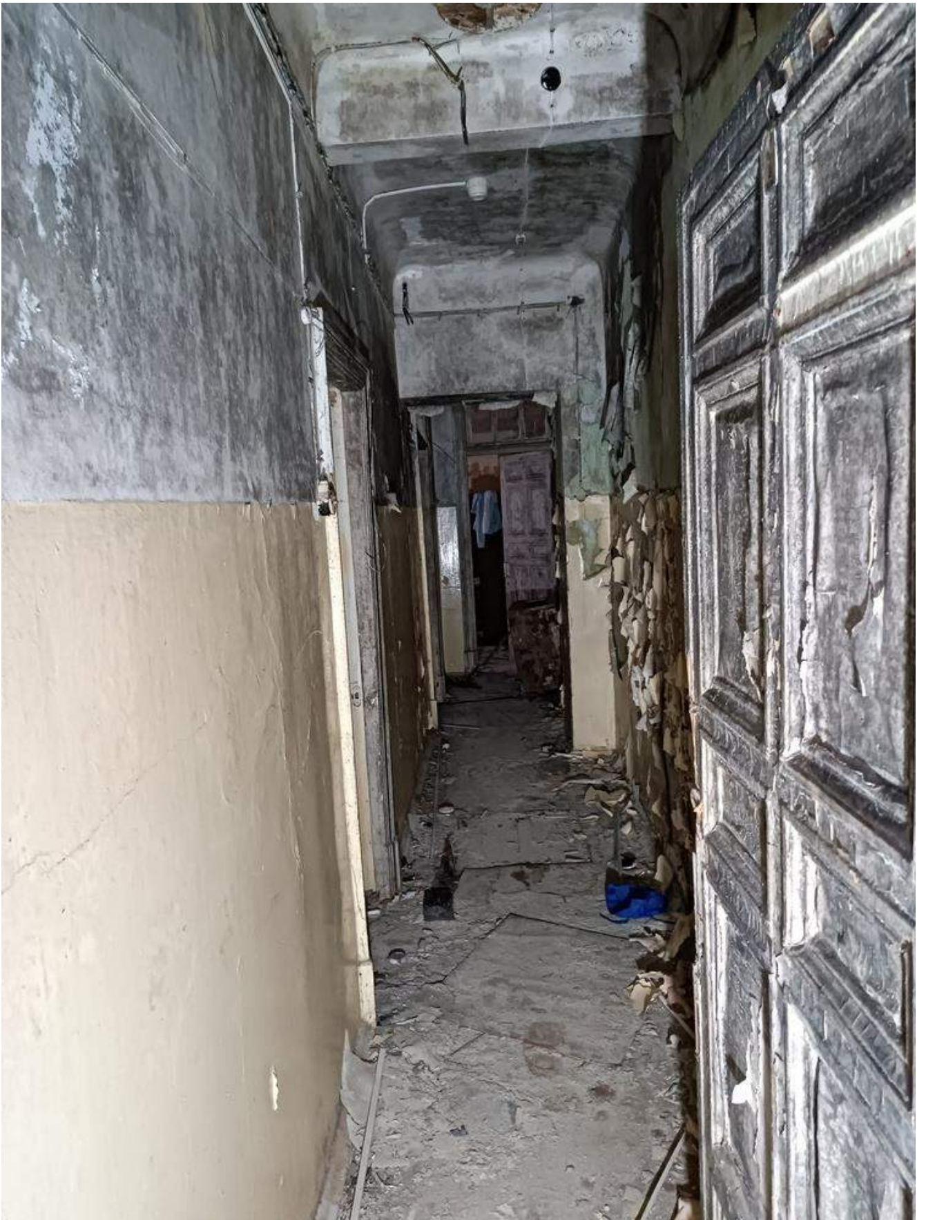
Фото 1.54 Внутренняя часть здания. Основное здание
