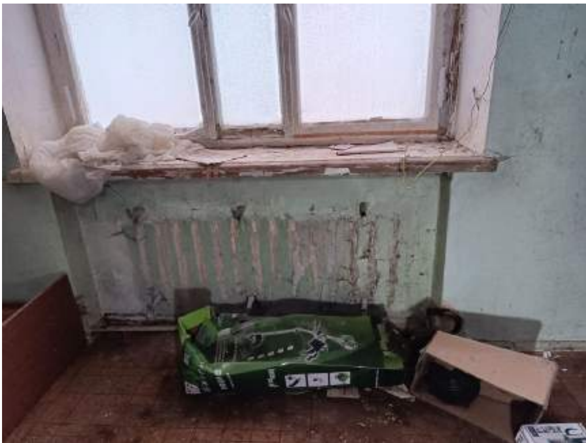
Фото 3.15 Состояние системы отопления. Демонтаж. Административный корпус
