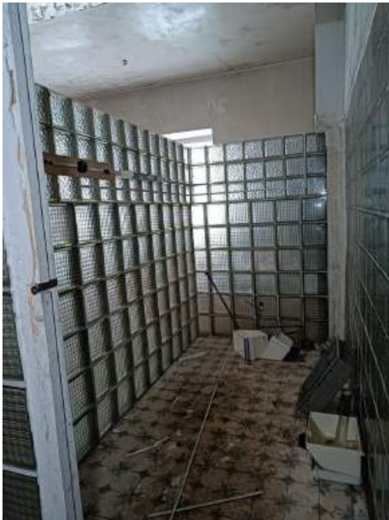
Фото 4.2 Состояние санитарно-технического узла. Демонтаж. Административный корпус
