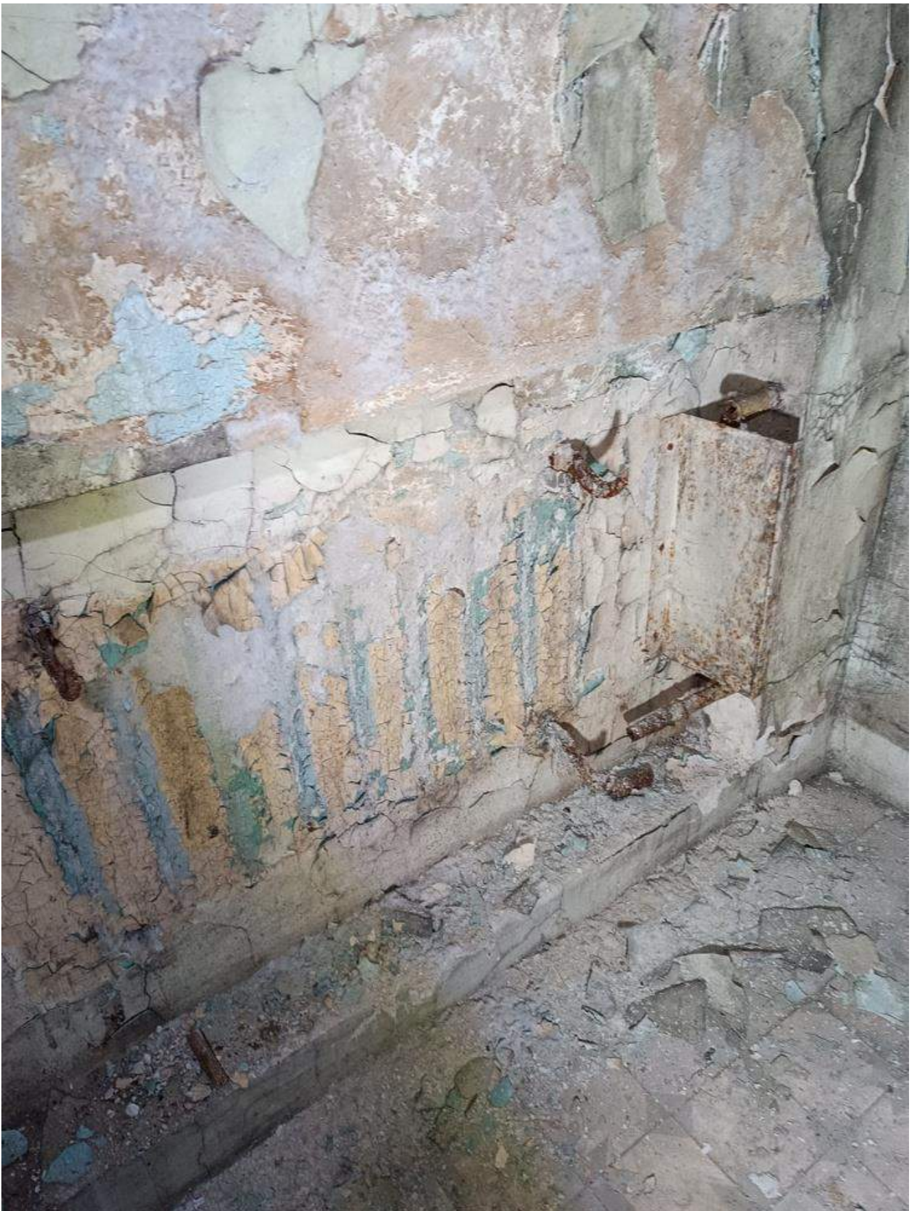
Фото 3.22 Демонтаж радиаторов отопления. Основное здание
