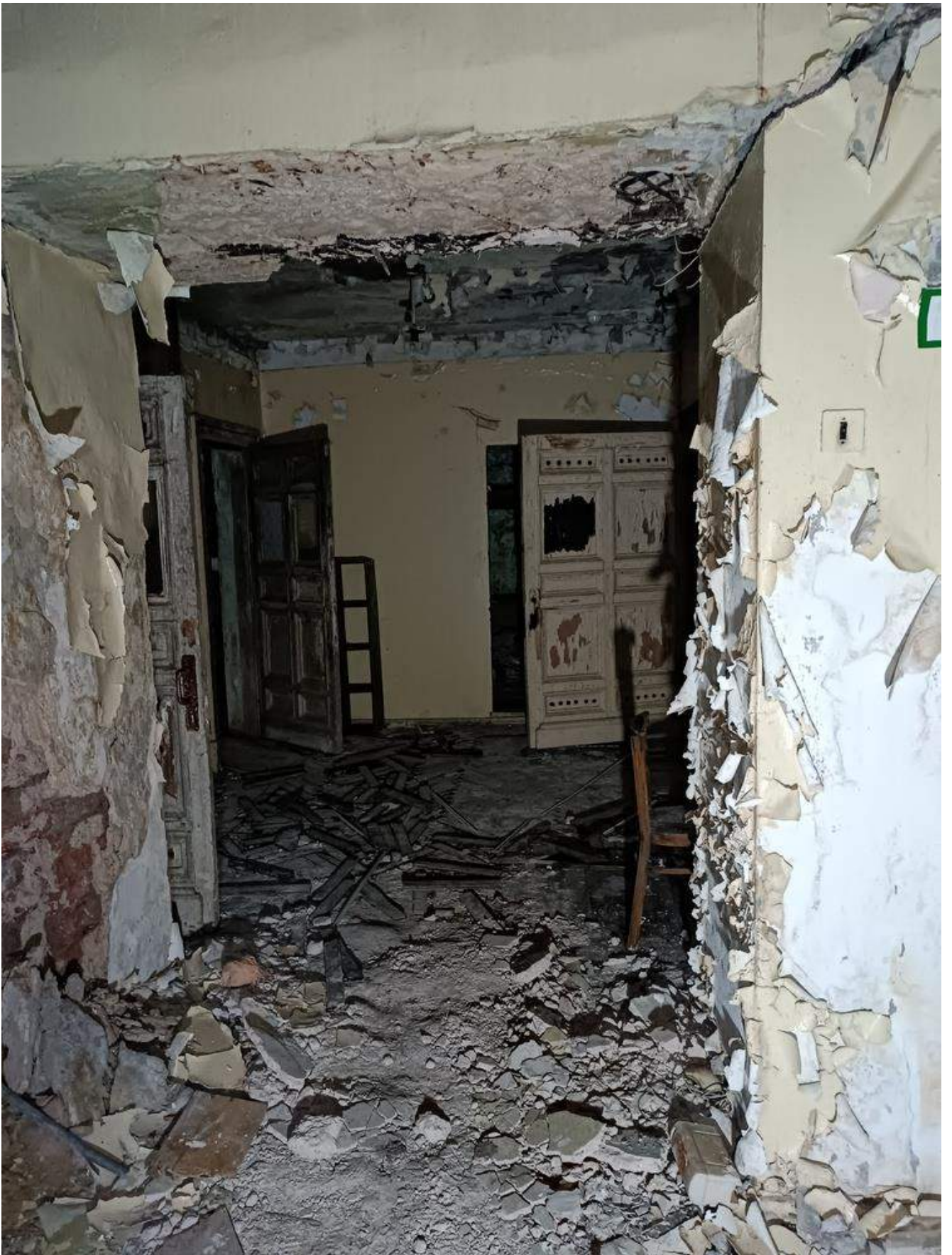
Фото 1.57 Внутренняя часть здания. Основное здание
