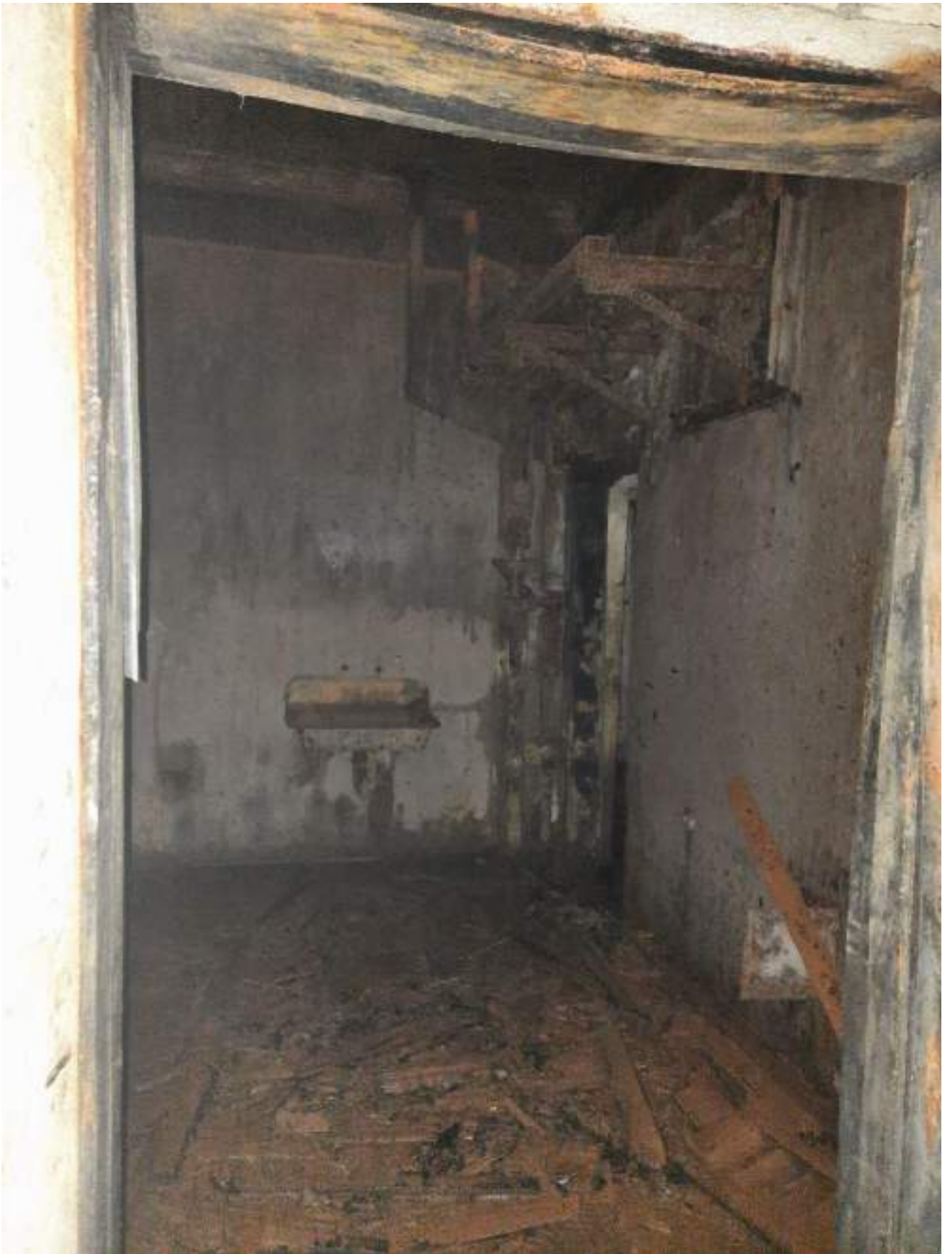
Фото 1.97 Внутренняя часть здания. Бомбоубежище
