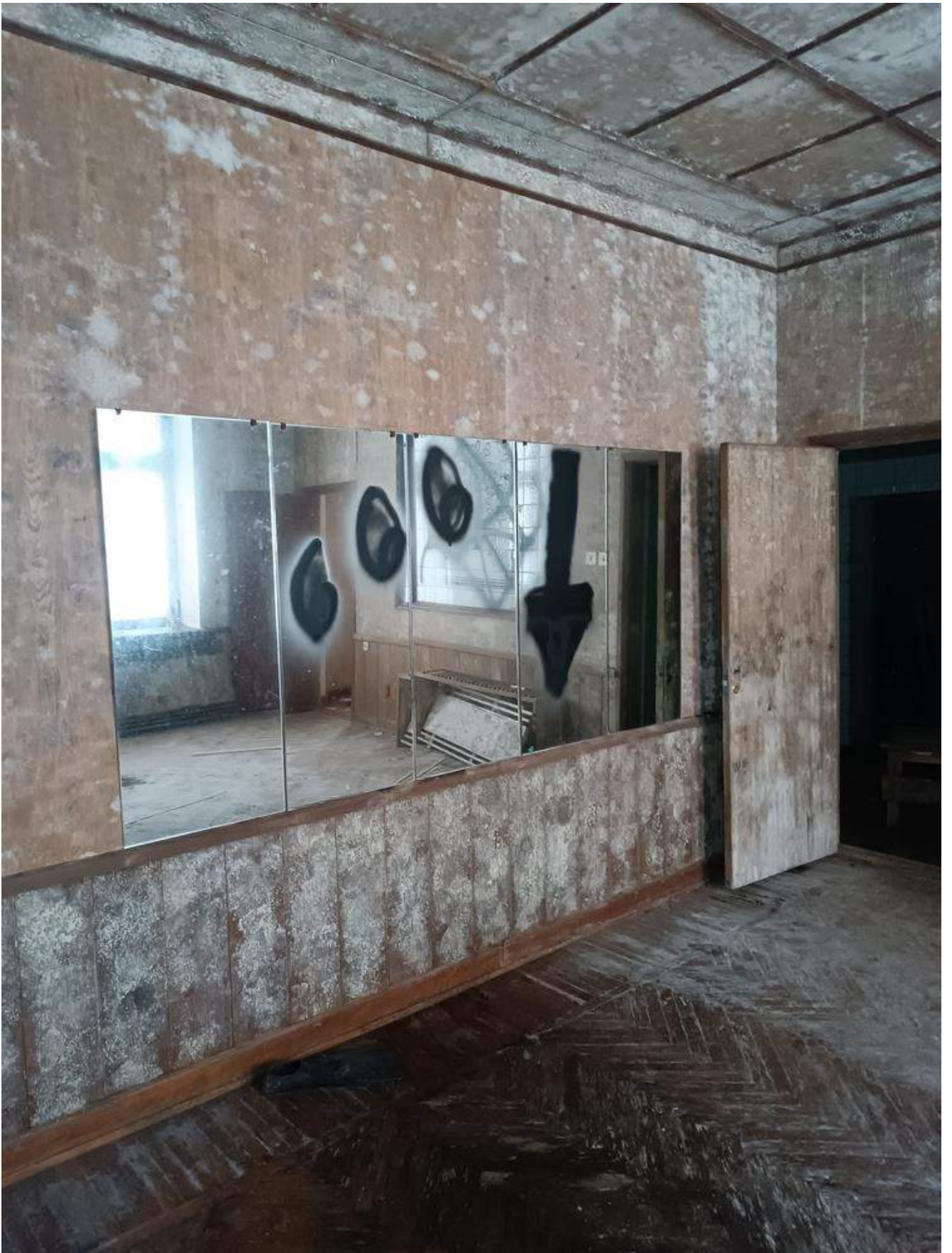
Фото 1.33 Внутренняя часть здания. Административный корпус
