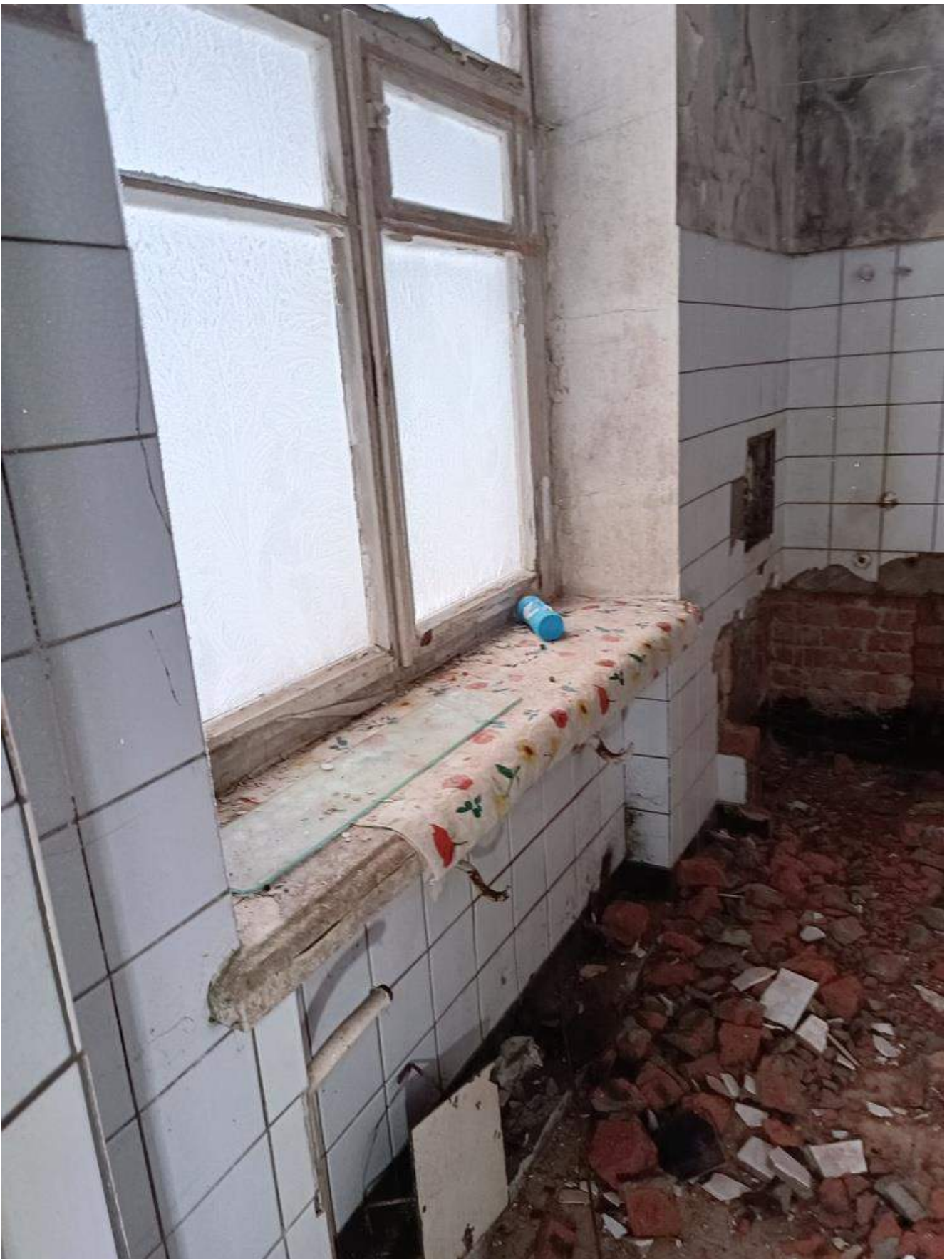
Фото 3.17 Состояние системы отопления. Демонтаж. Административный корпус
