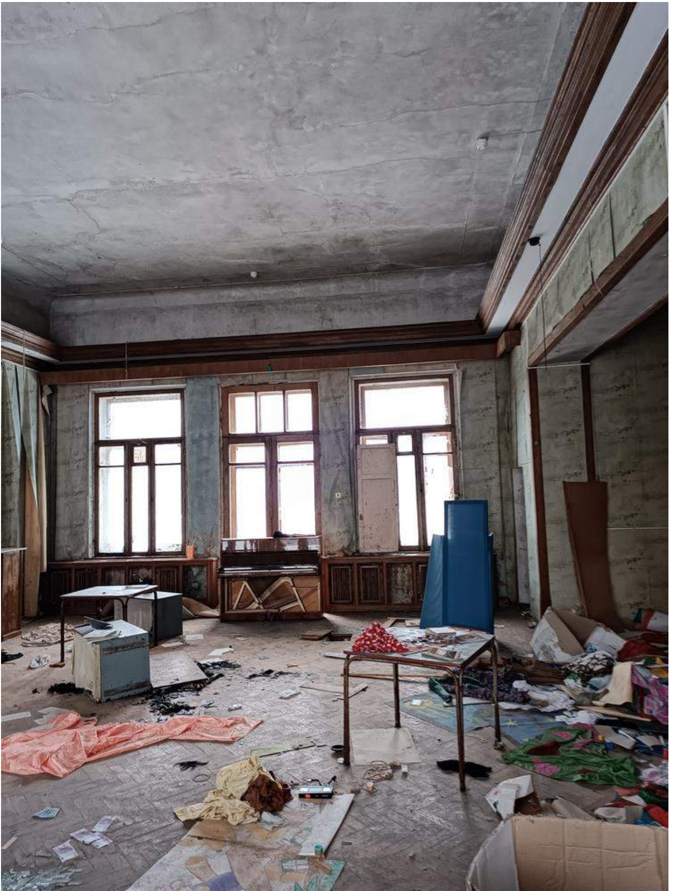
Фото 1.72 Внутренняя часть здания. Основное здание
