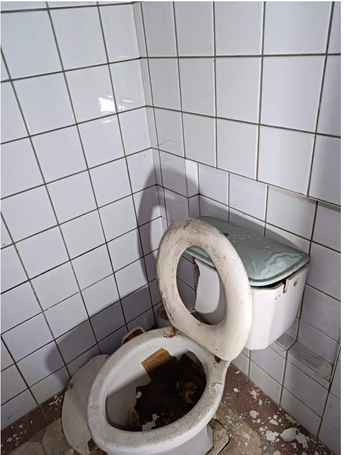
Фото 4.7 Состояние санитарно-технического узла. Демонтаж. Административный корпус
