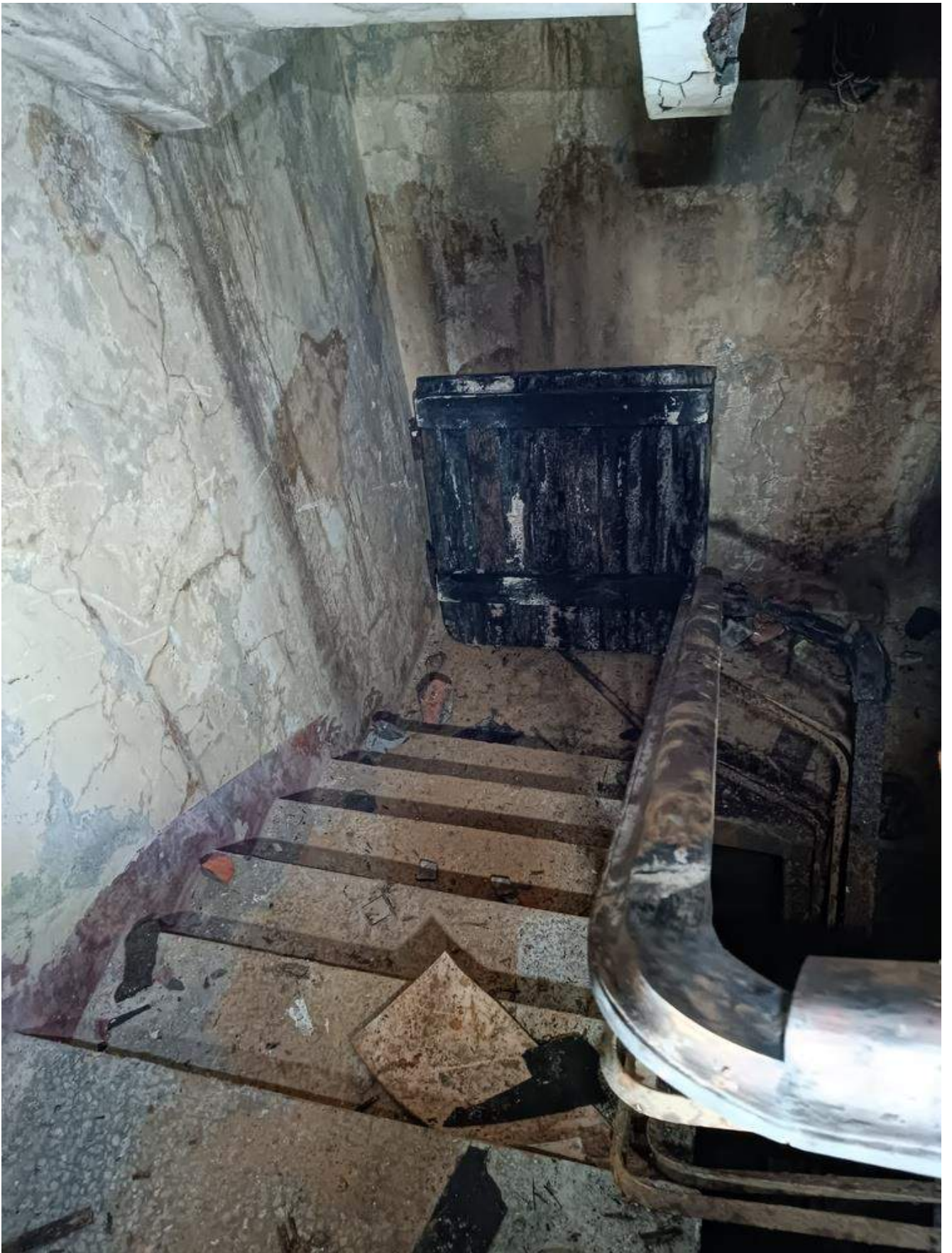
Фото 1.86 Внутренняя часть здания. Бомбоубежище
