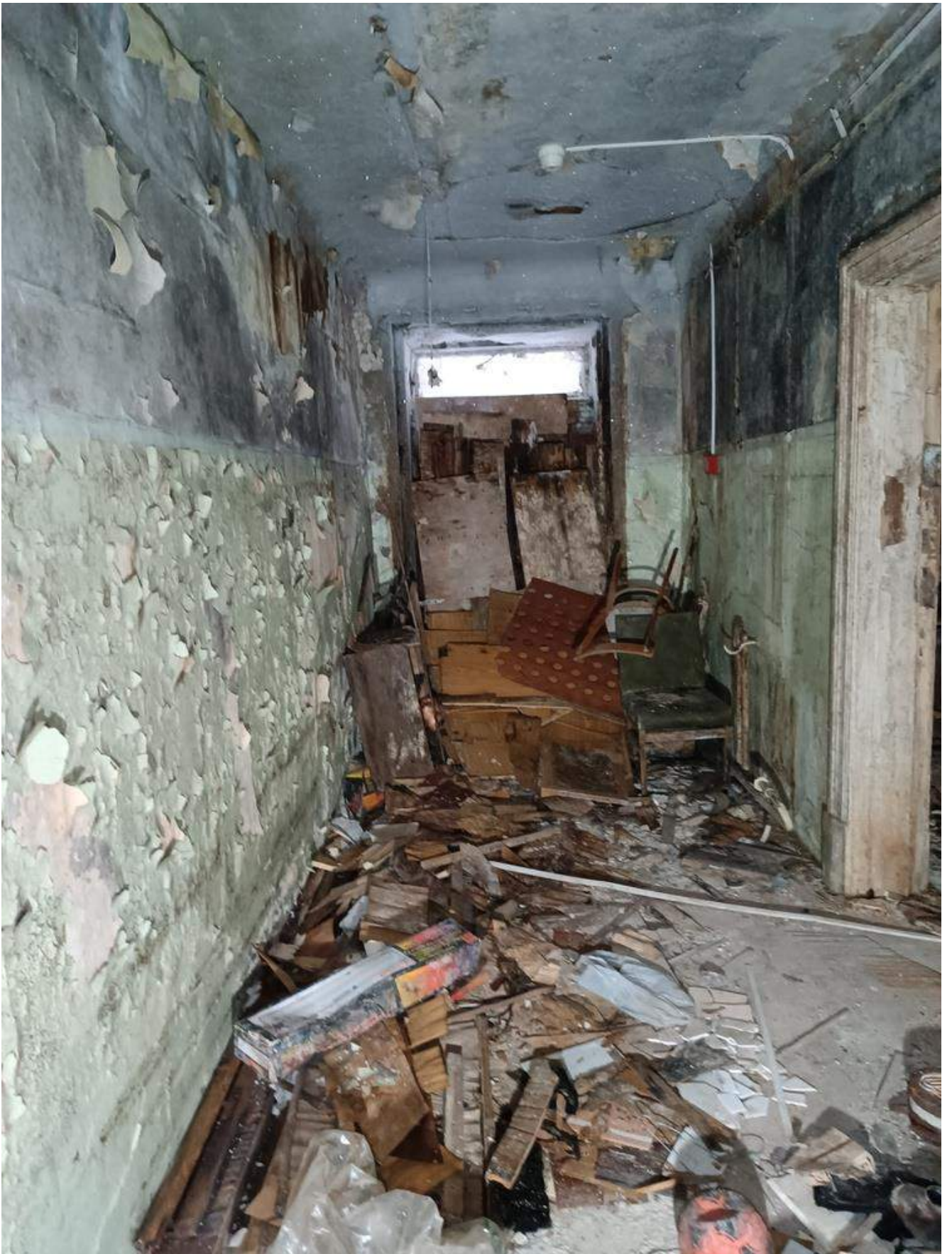
Фото 1.60 Внутренняя часть здания. Основное здание
