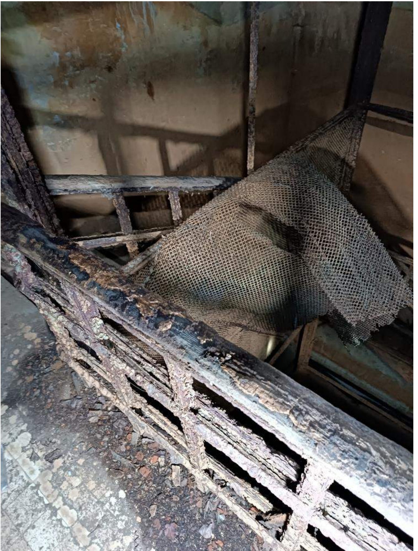
Фото 1.84 Внутренняя часть здания. Бомбоубежище
