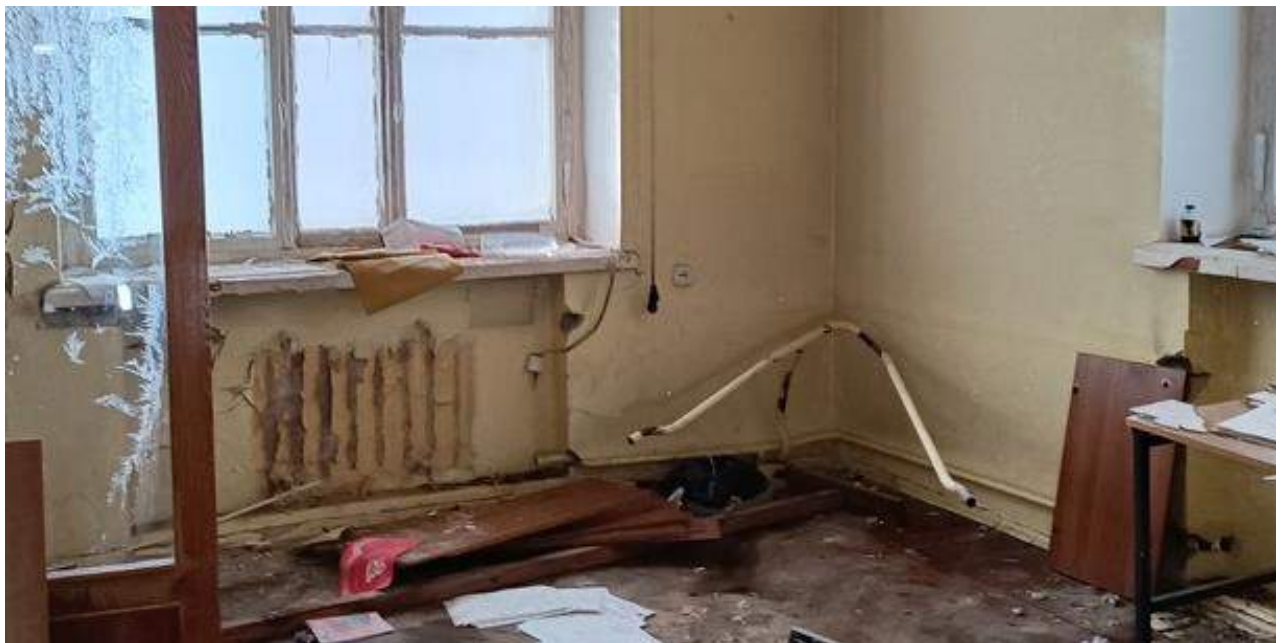
Фото 3.18 Состояние системы отопления. Демонтаж. Административный корпус
