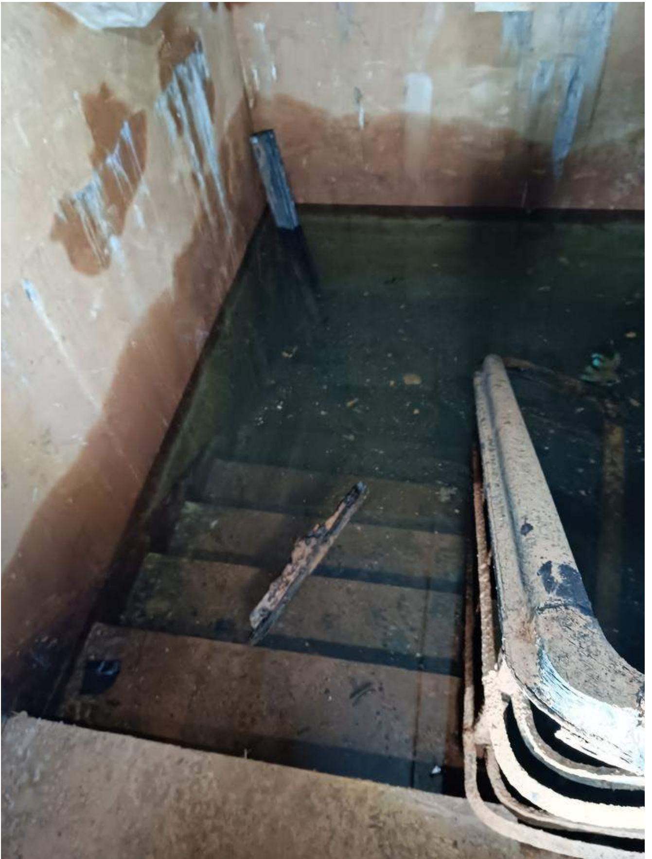
Фото 1.87 Внутренняя часть здания. Бомбоубежище
