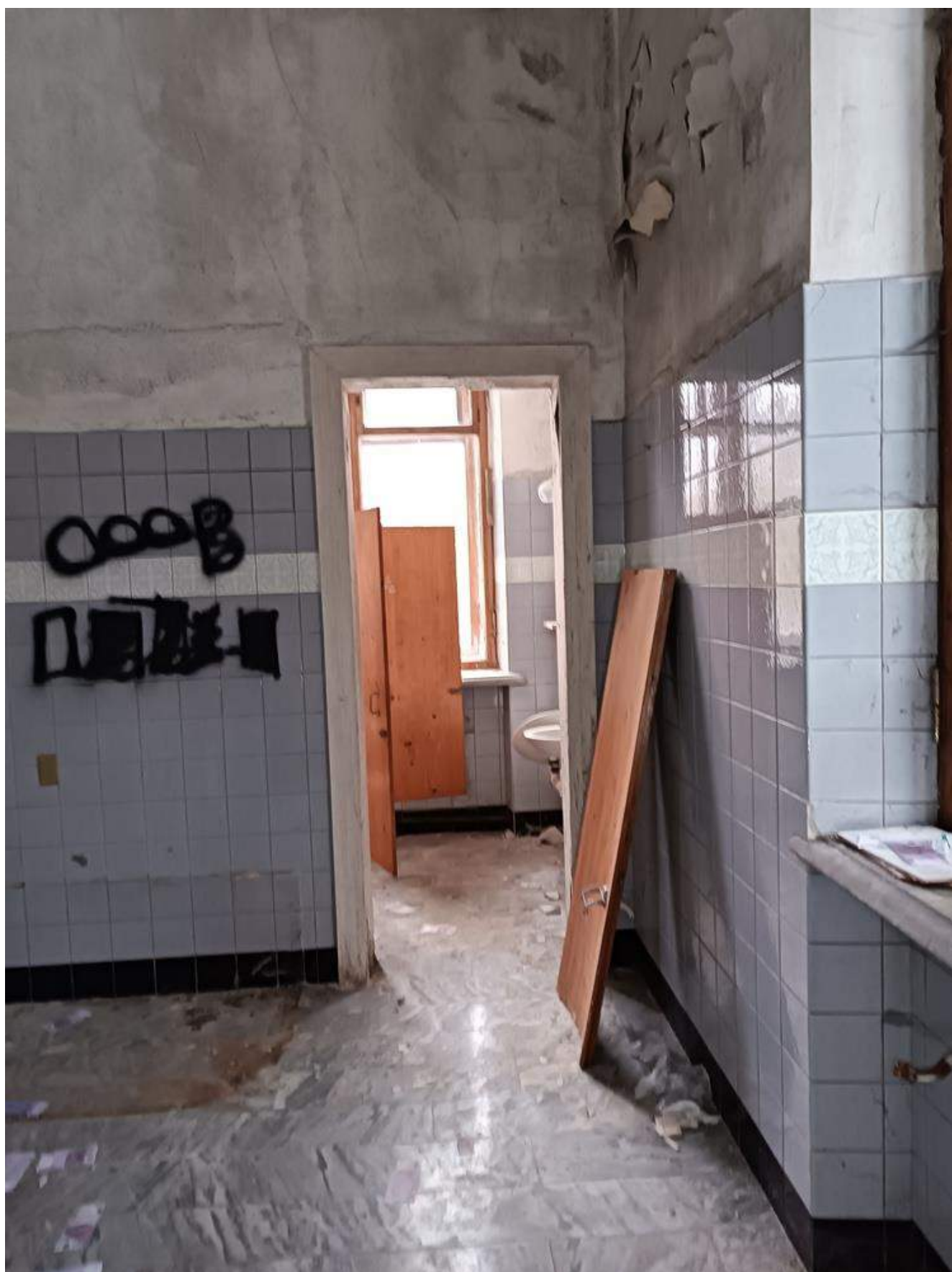
Фото 1.69 Внутренняя часть здания. Основное здание
