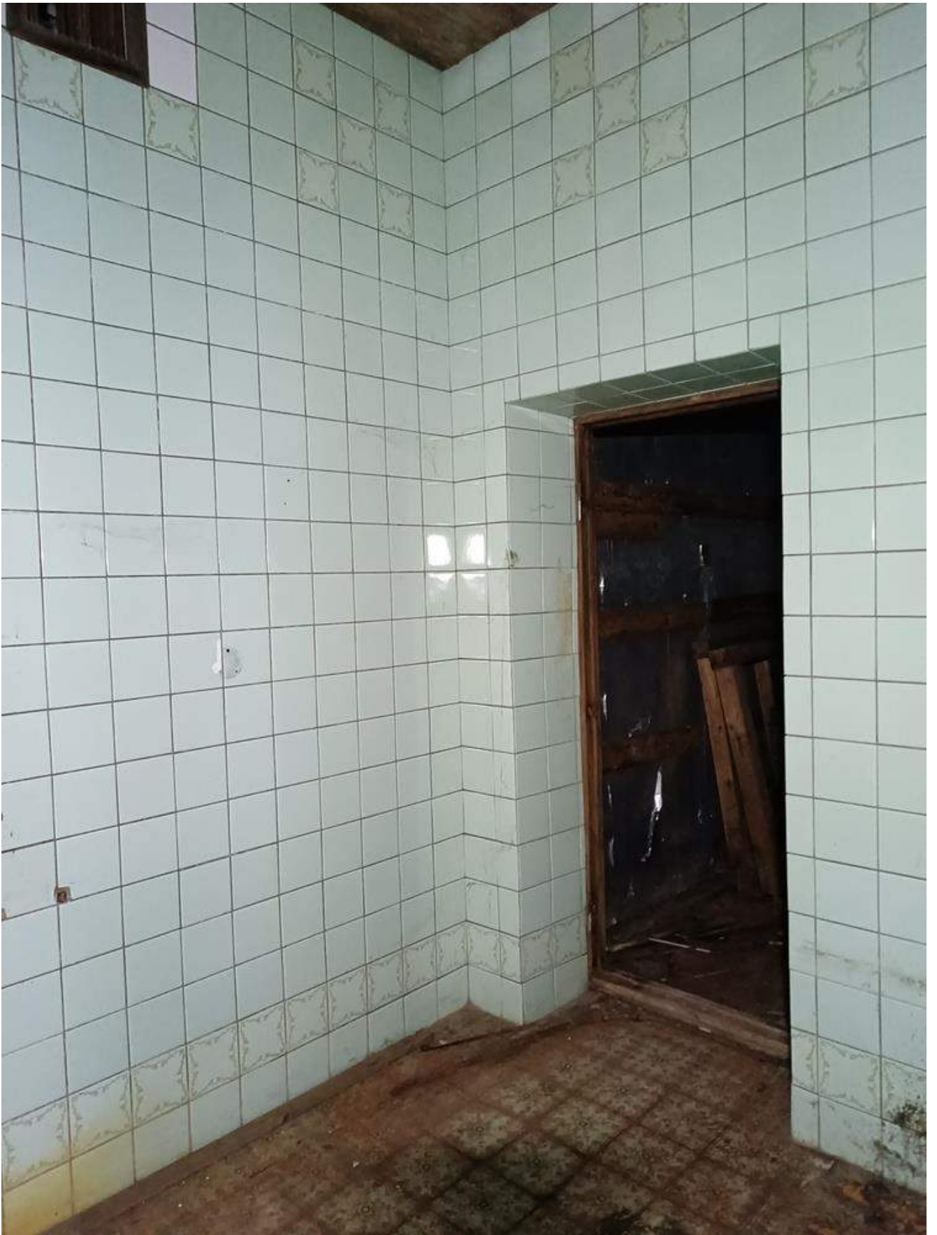
Фото 1.74 Внутренняя часть здания. Бассейн
