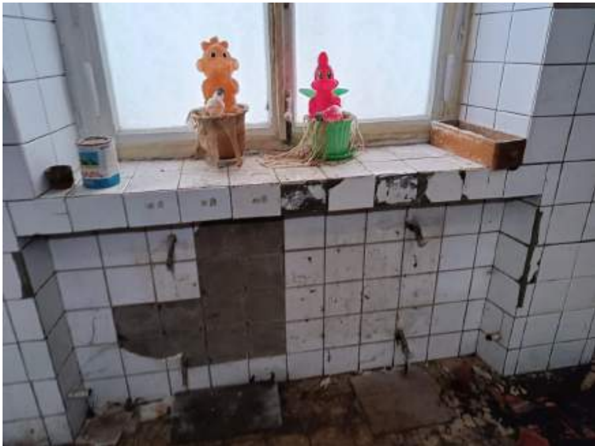
Фото 3.10 Состояние системы отопления. Демонтаж. Административный корпус
