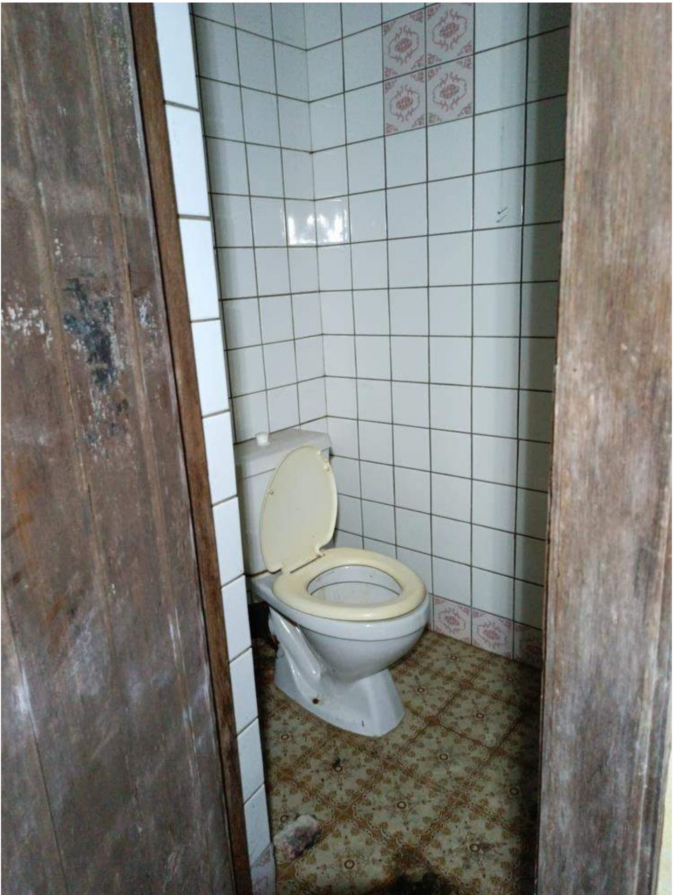
Фото 4.23 Состояние санитарно-технического узла. Бассейн
