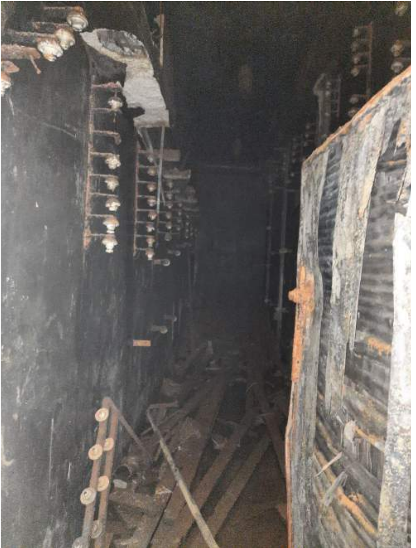
Фото 1.91 Внутренняя часть здания. Бомбоубежище
