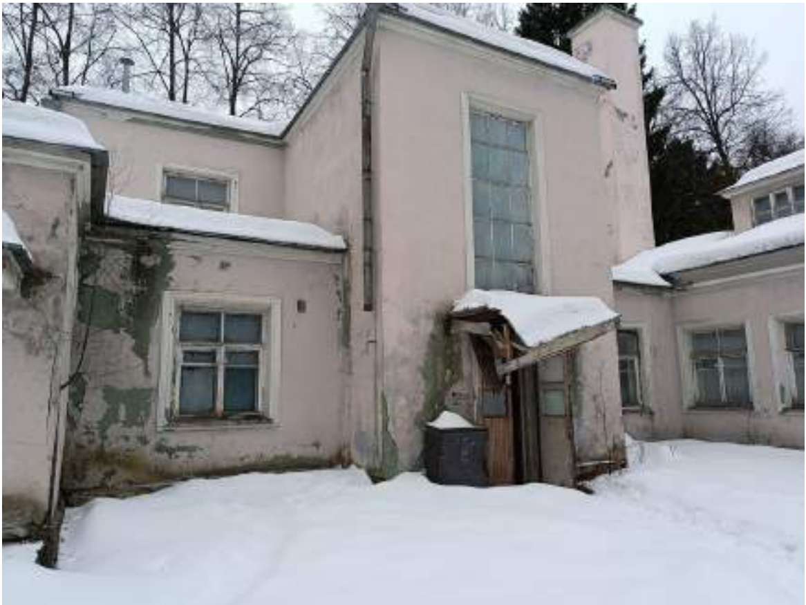
Фото 1.15 Общий вид. Административный корпус
