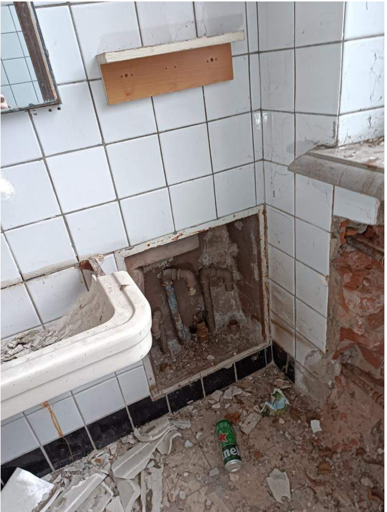
Фото 4.20 Состояние санитарно-технического узла и трубопроводов системы водоснабжения. Демонтаж. Основное здание
