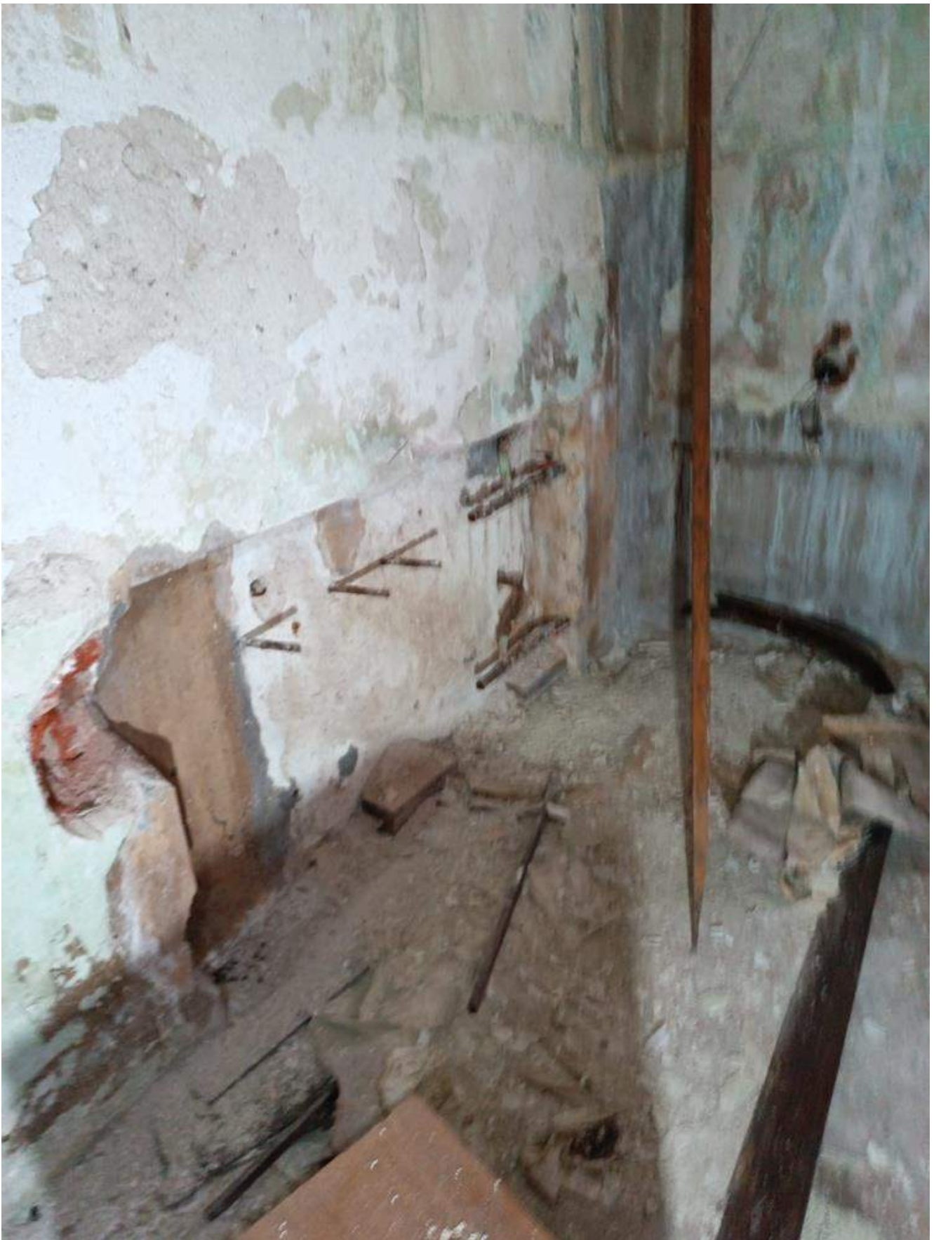
Фото 3.26 Состояние системы отопления. Демонтаж. Основное здание
