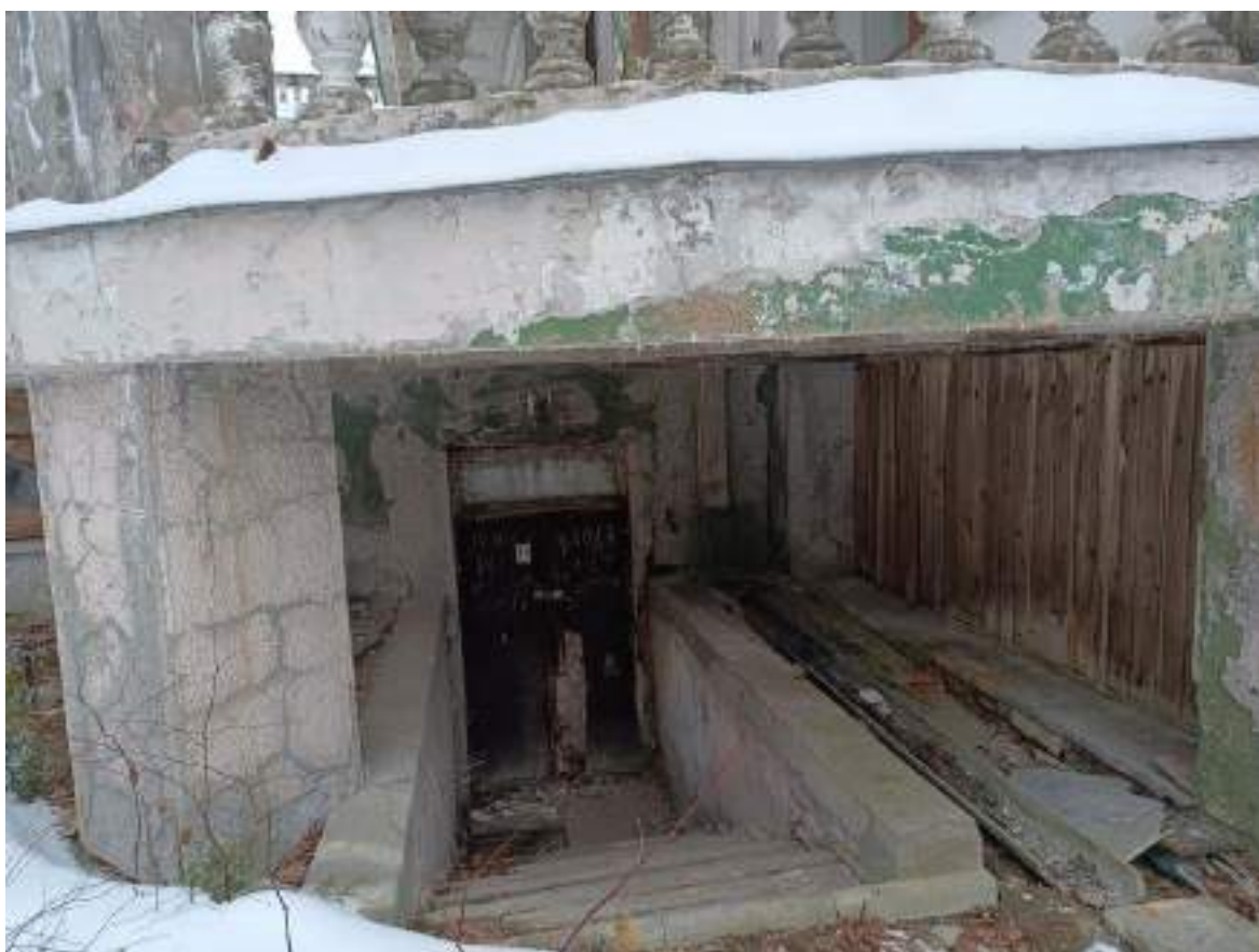
Фото 1.45 Общий вид. Основное здание
