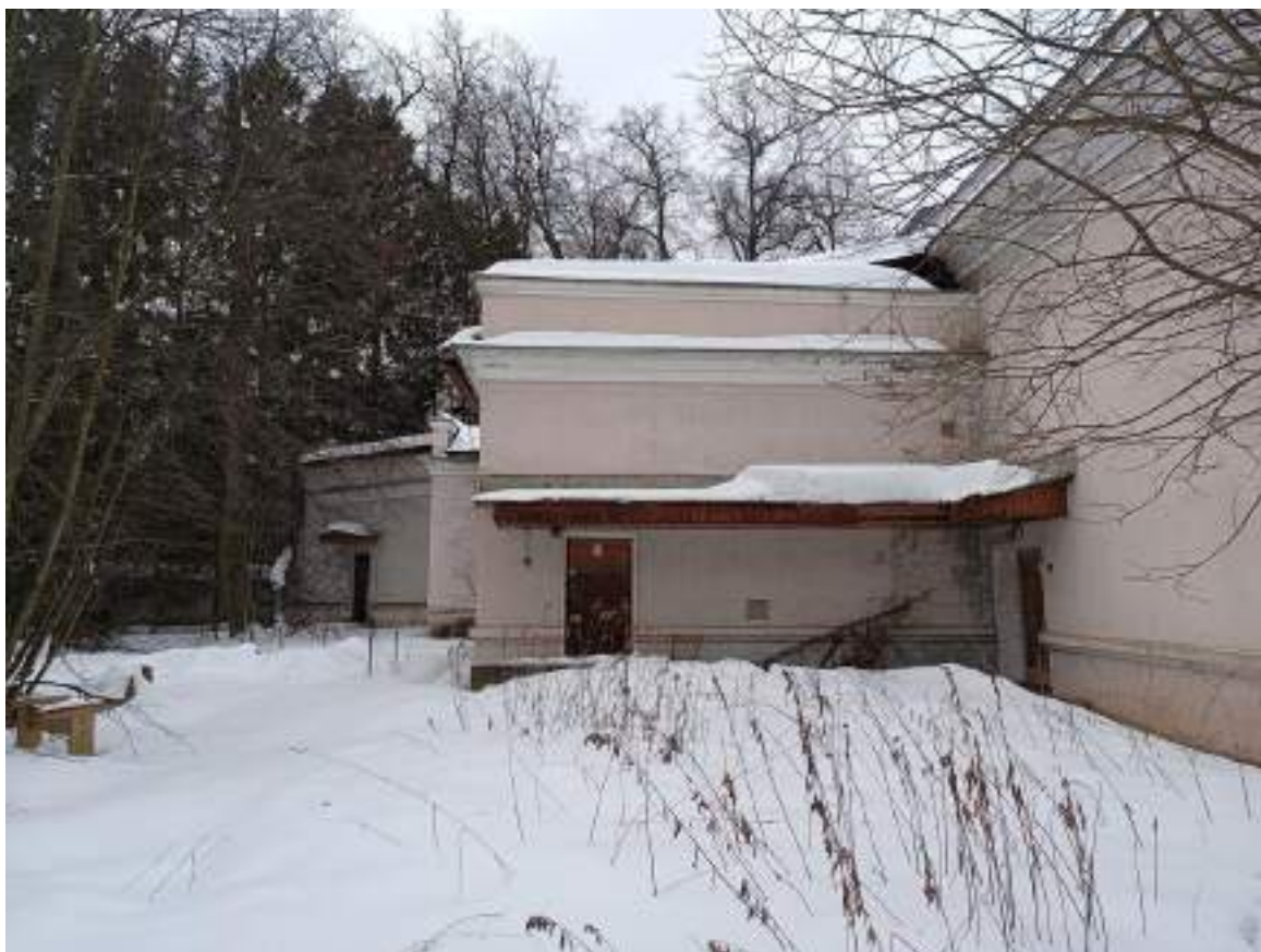
Фото 1.21 Общий вид. Административный корпус
