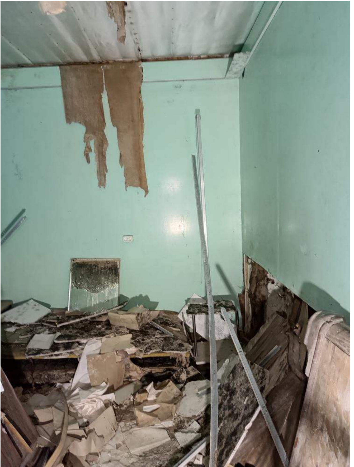
Фото 1.59 Внутренняя часть здания. Основное здание
