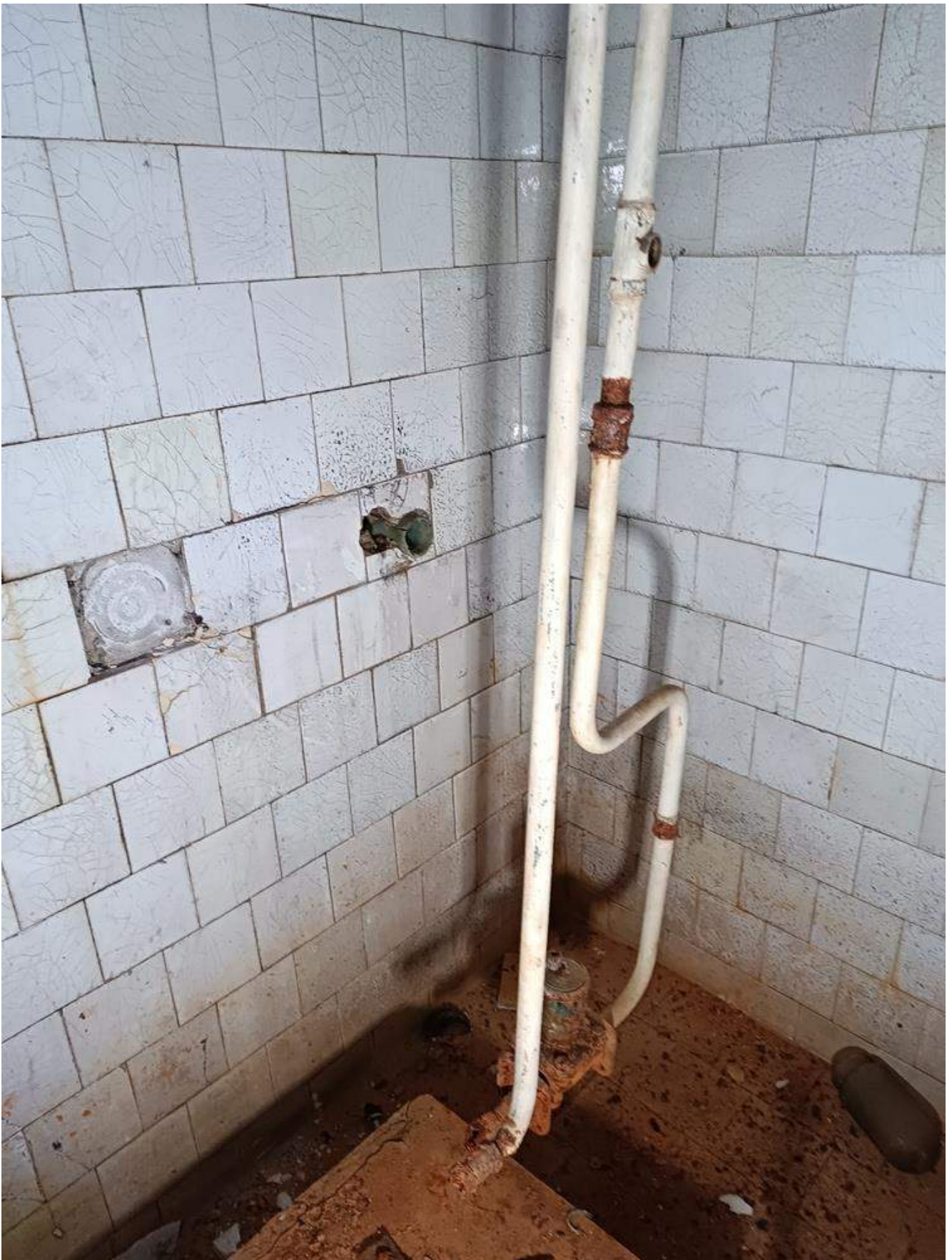
Фото 4.26 Состояние трубопроводов системы водоснабжения. Бомбоубежище
