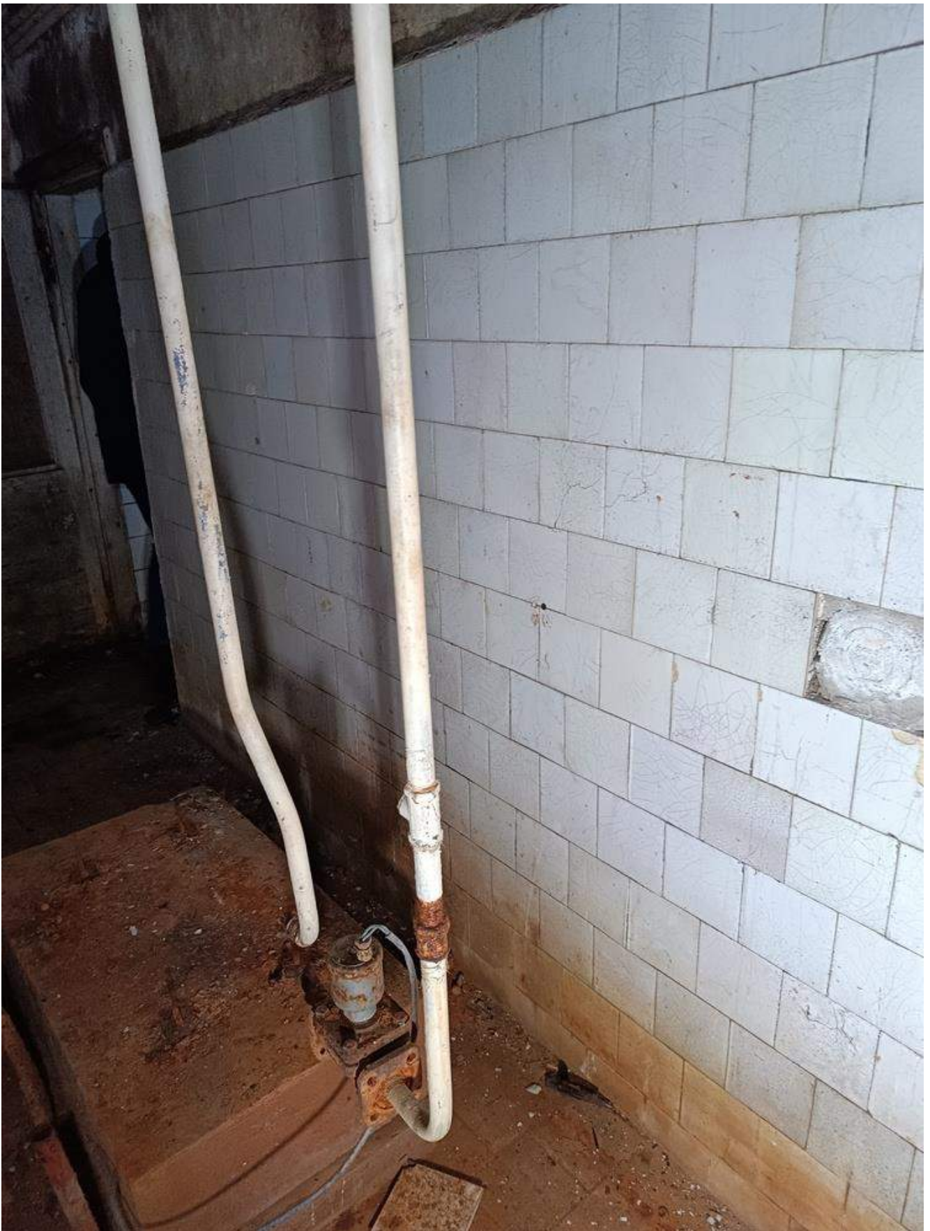
Фото 4.27 Состояние трубопроводов системы водоснабжения. Бомбоубежище
