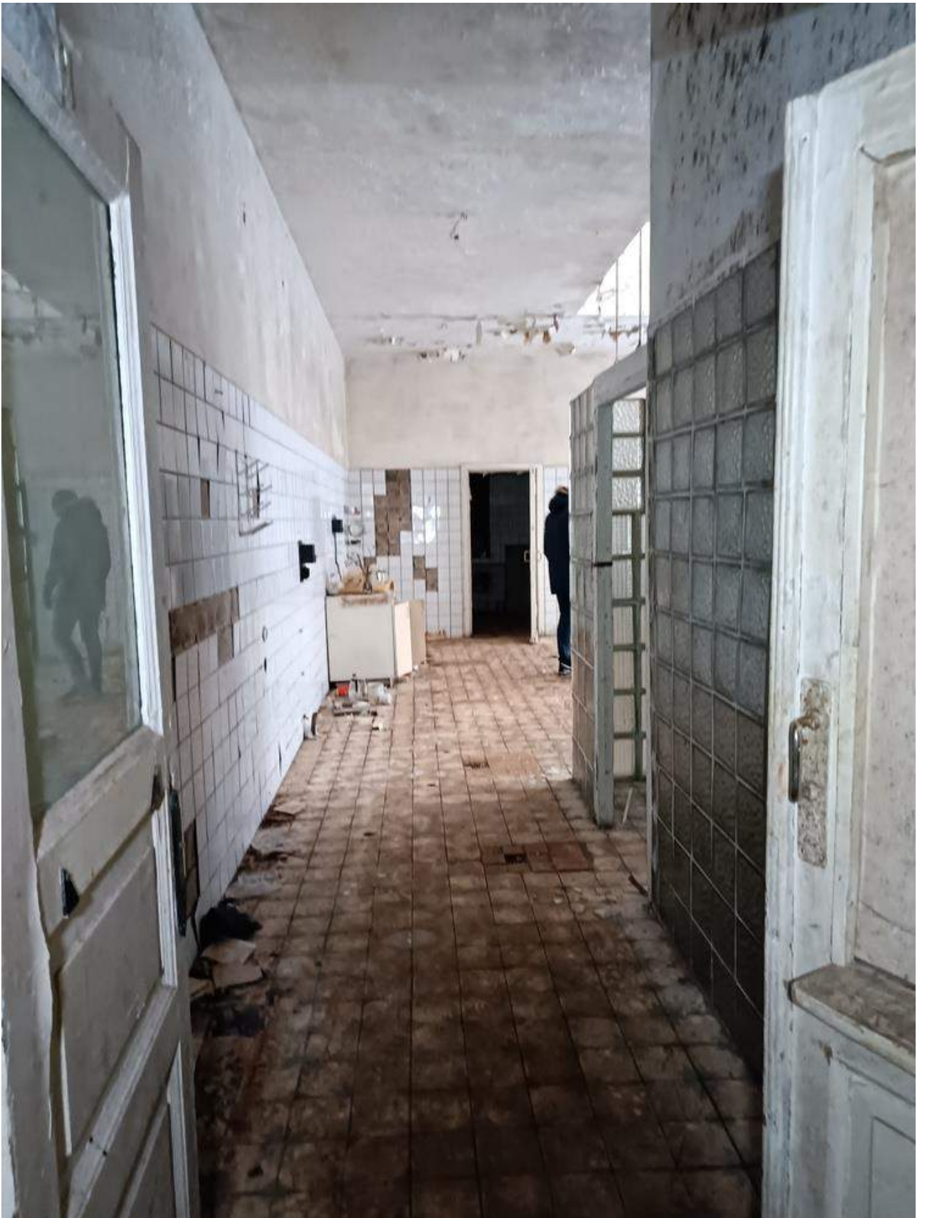
Фото 1.28 Внутренняя часть здания. Административный корпус
