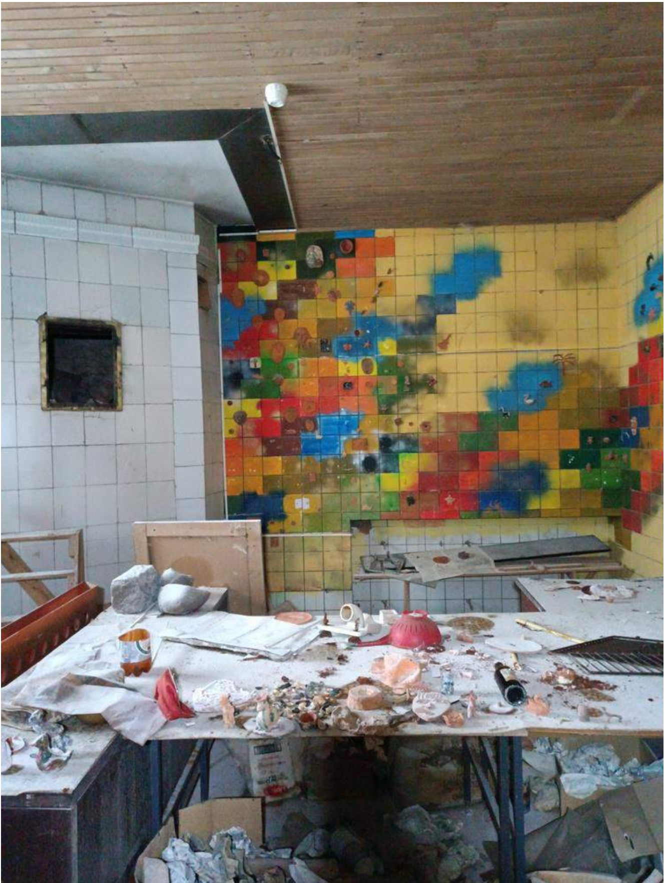
Фото 1.32 Внутренняя часть здания. Административный корпус
