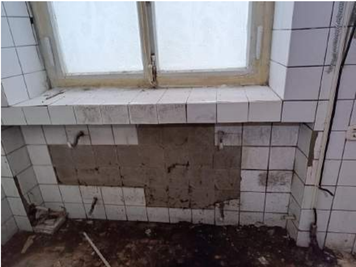
Фото 3.9 Состояние системы отопления. Демонтаж. Административный корпус
