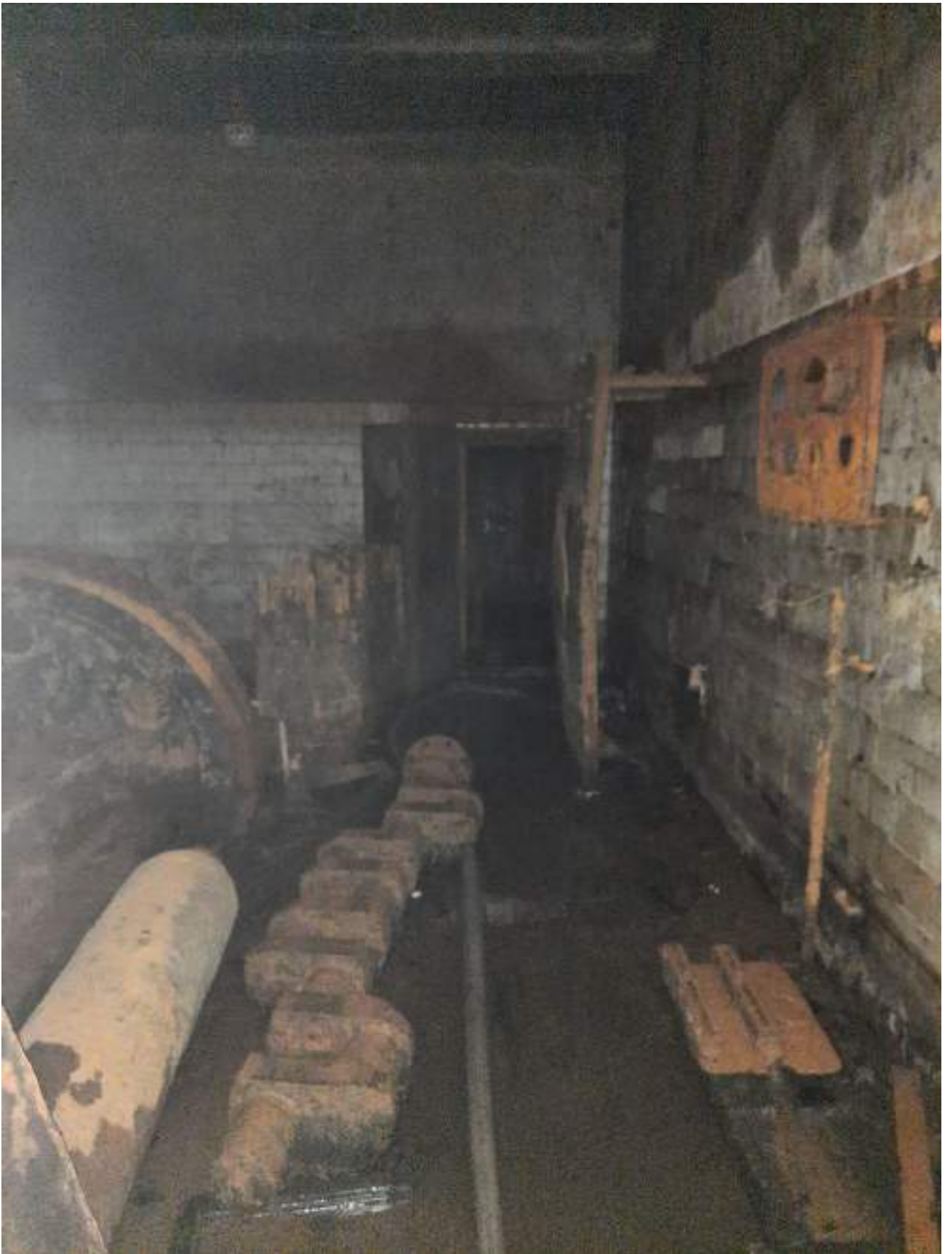
Фото 1.96 Внутренняя часть здания. Бомбоубежище
