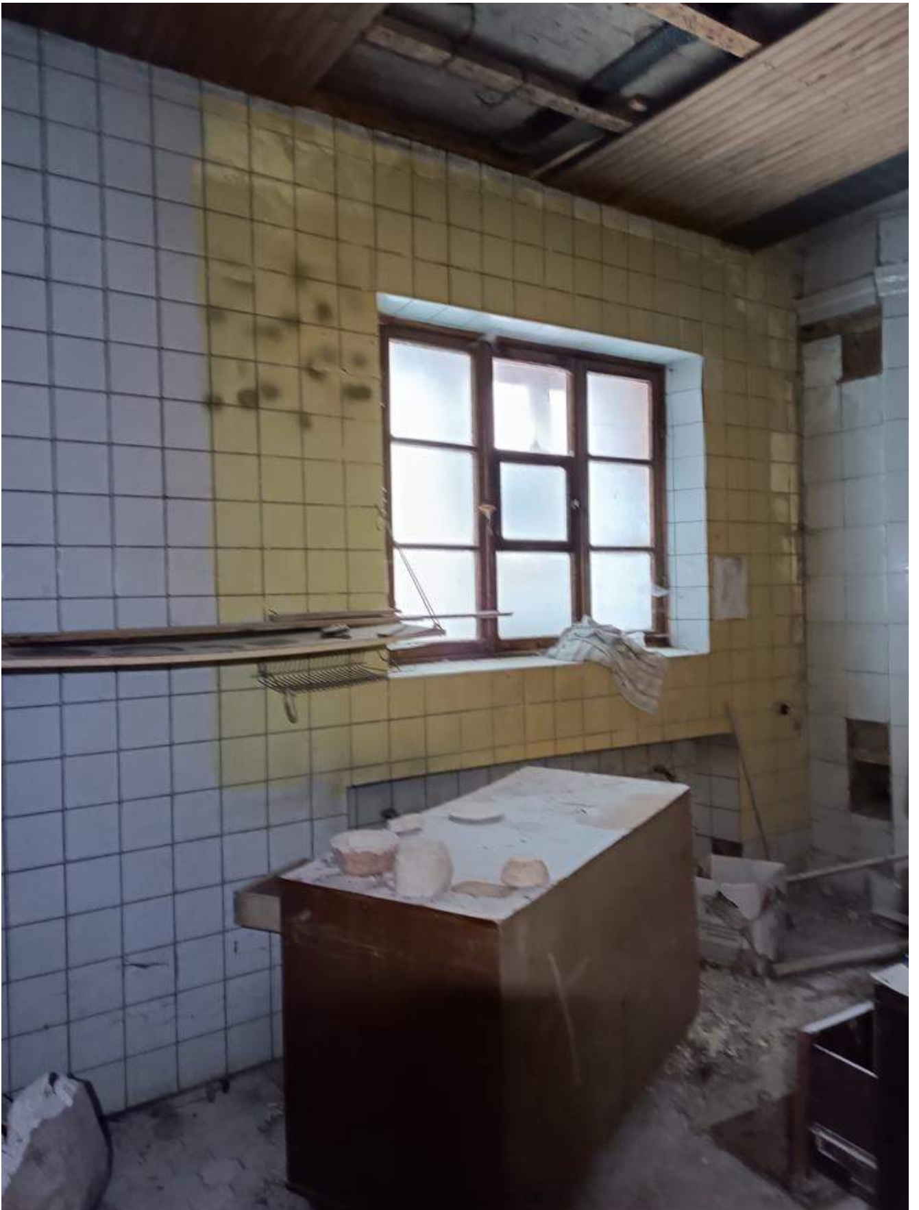
Фото 1.31 Внутренняя часть здания. Административный корпус
