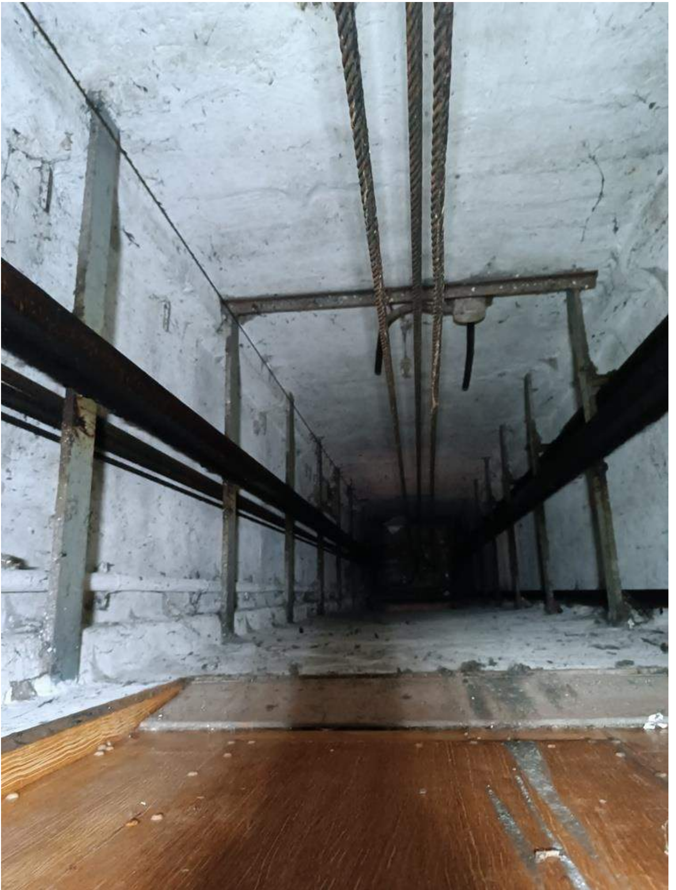
Фото 1.68 Внутренняя часть здания. Шахта лифта. Основное здание
