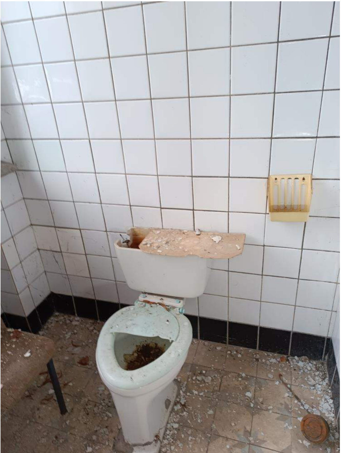
Фото 4.19 Состояние санитарно-технического узла. Демонтаж. Основное здание
