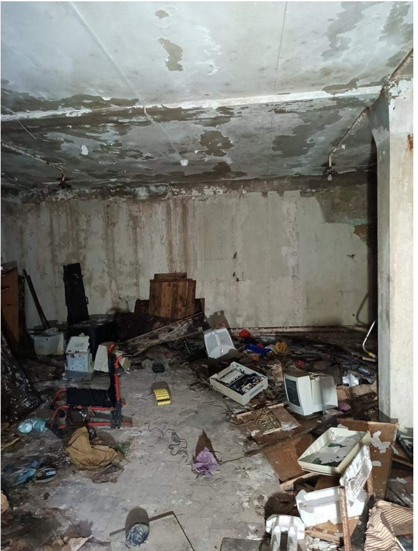
Фото 1.62 Внутренняя часть здания. Основное здание
