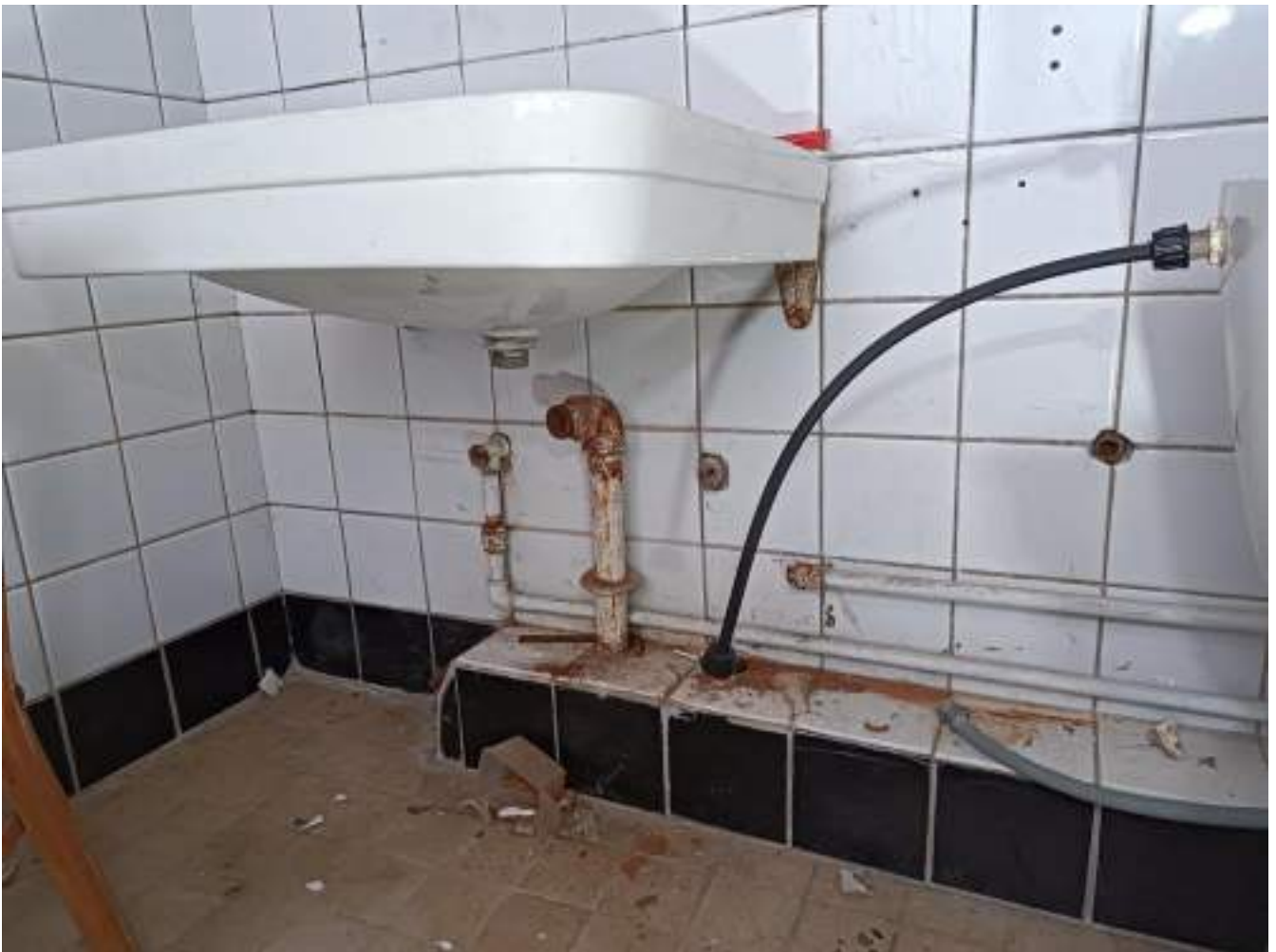
Фото 4.12 Состояние санитарно-технического узла и трубопроводов системы водоснабжения и водоотведения. Демонтаж. Административный корпус
