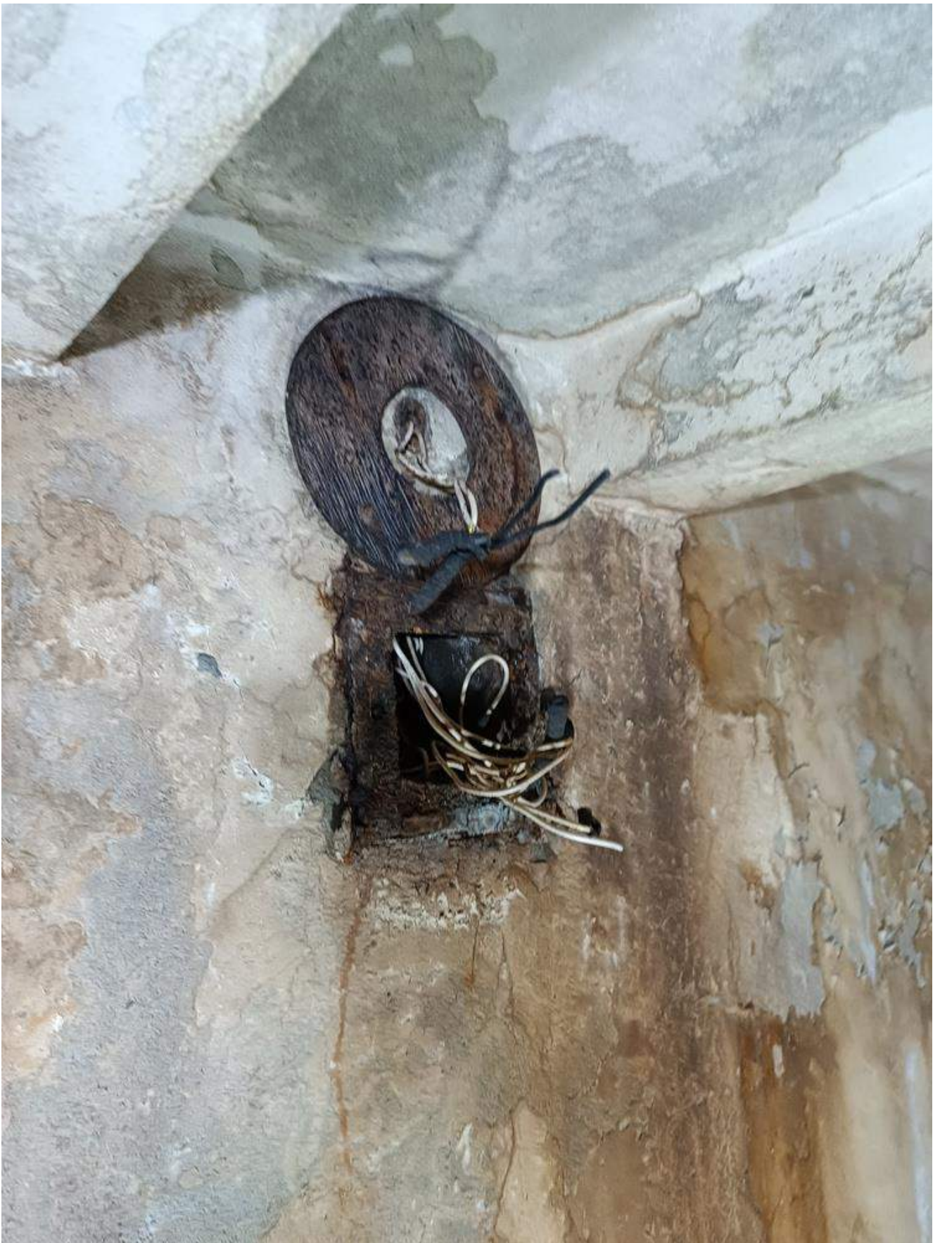
Фото 2.26 Состояние внутренних электрических сетей и освещения. Демонтаж. Бомбоубежище
