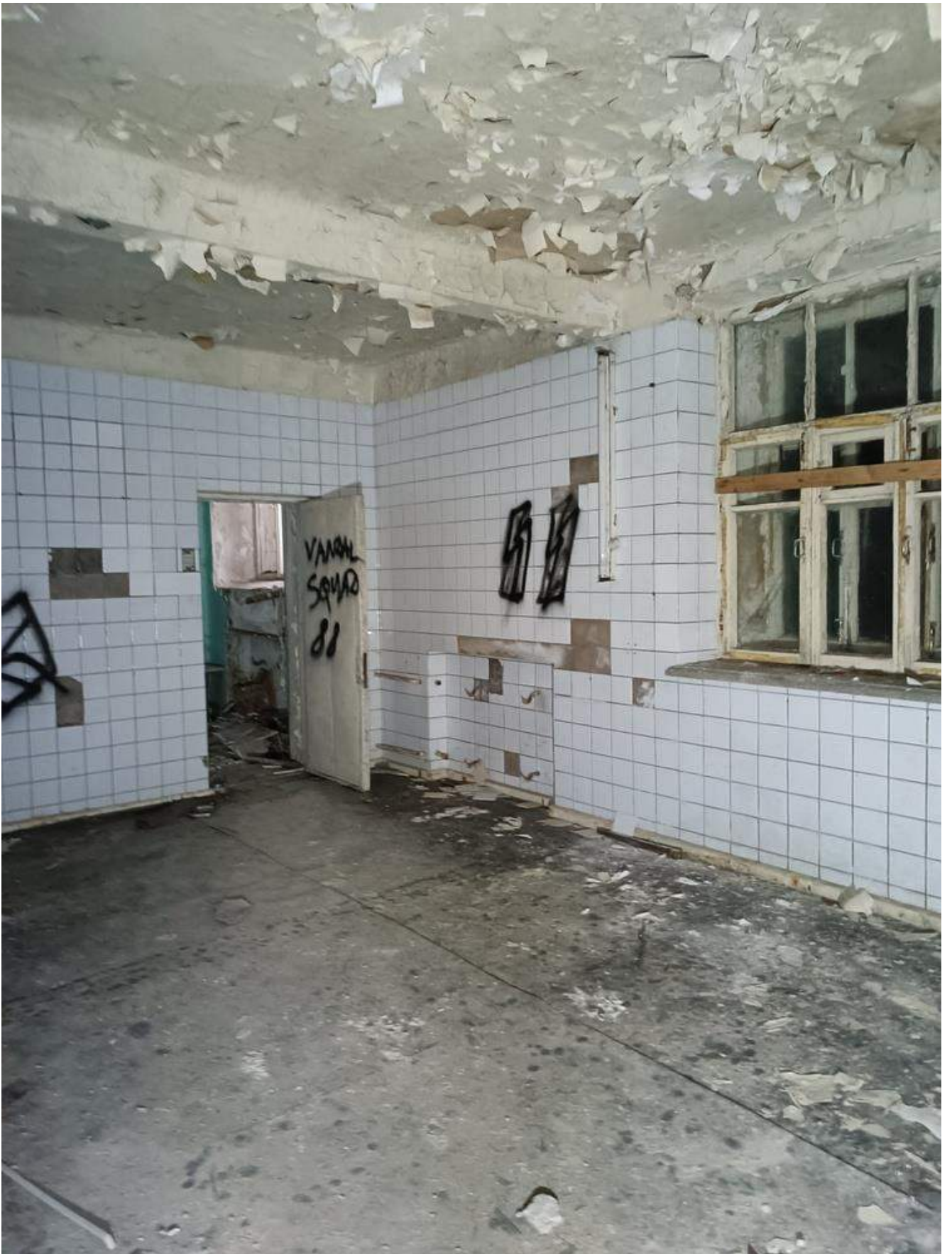
Фото 1.58 Внутренняя часть здания. Основное здание
