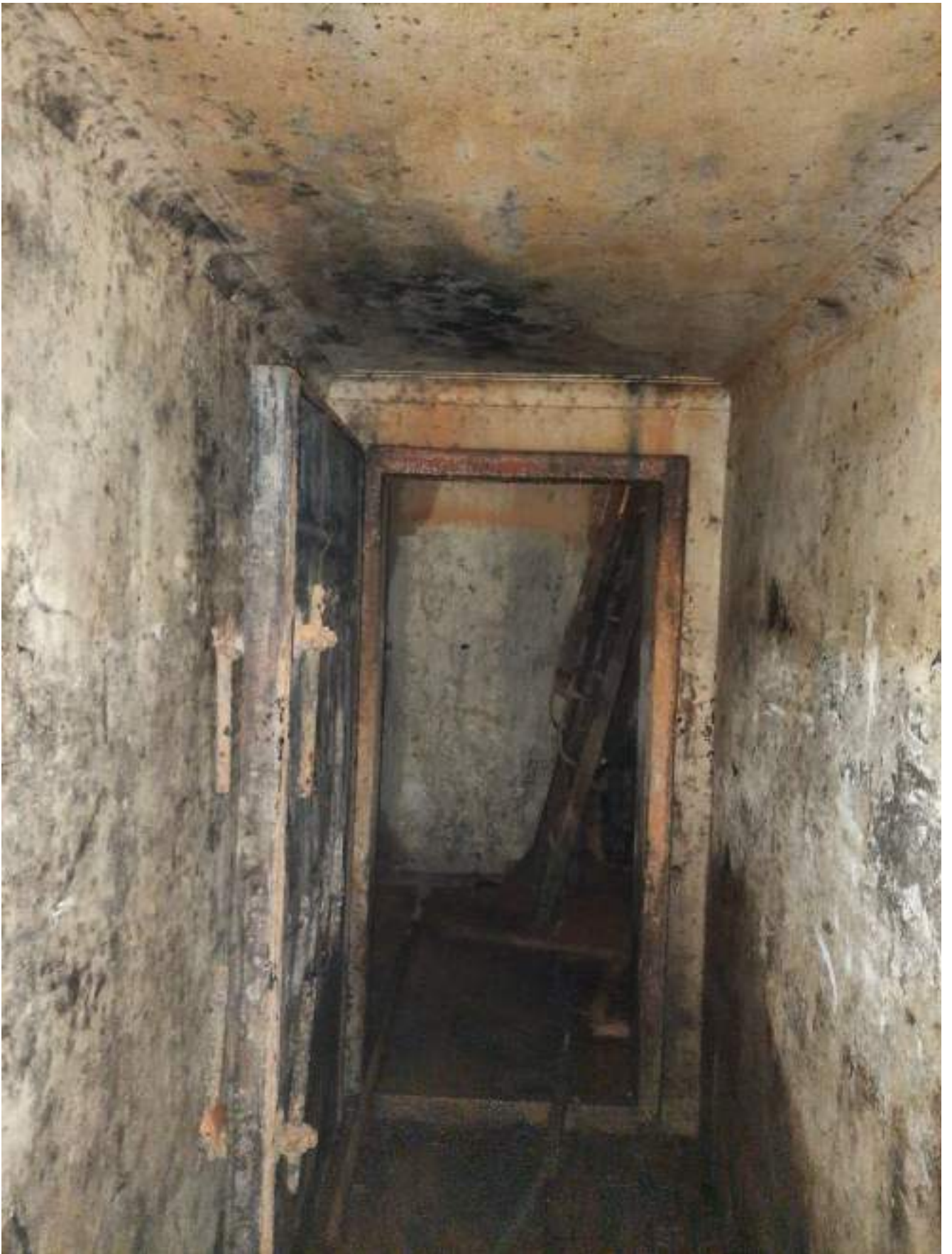
Фото 1.98 Внутренняя часть здания. Бомбоубежище
