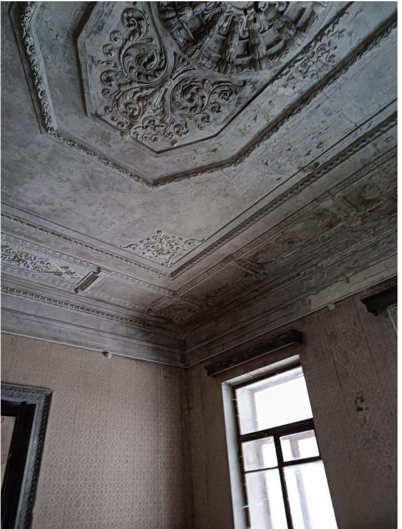
Фото 1.64 Внутренняя часть здания. Основное здание
