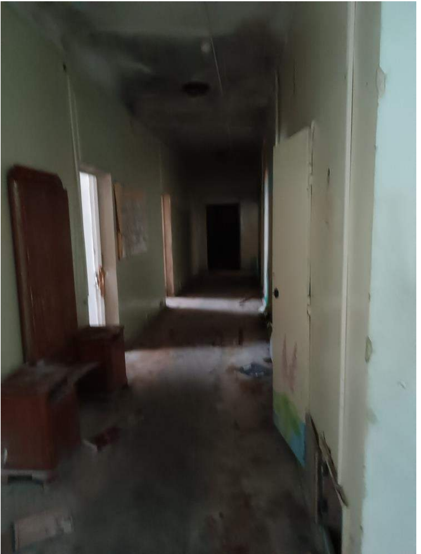
Фото 1.25 Внутренняя часть здания. Административный корпус
