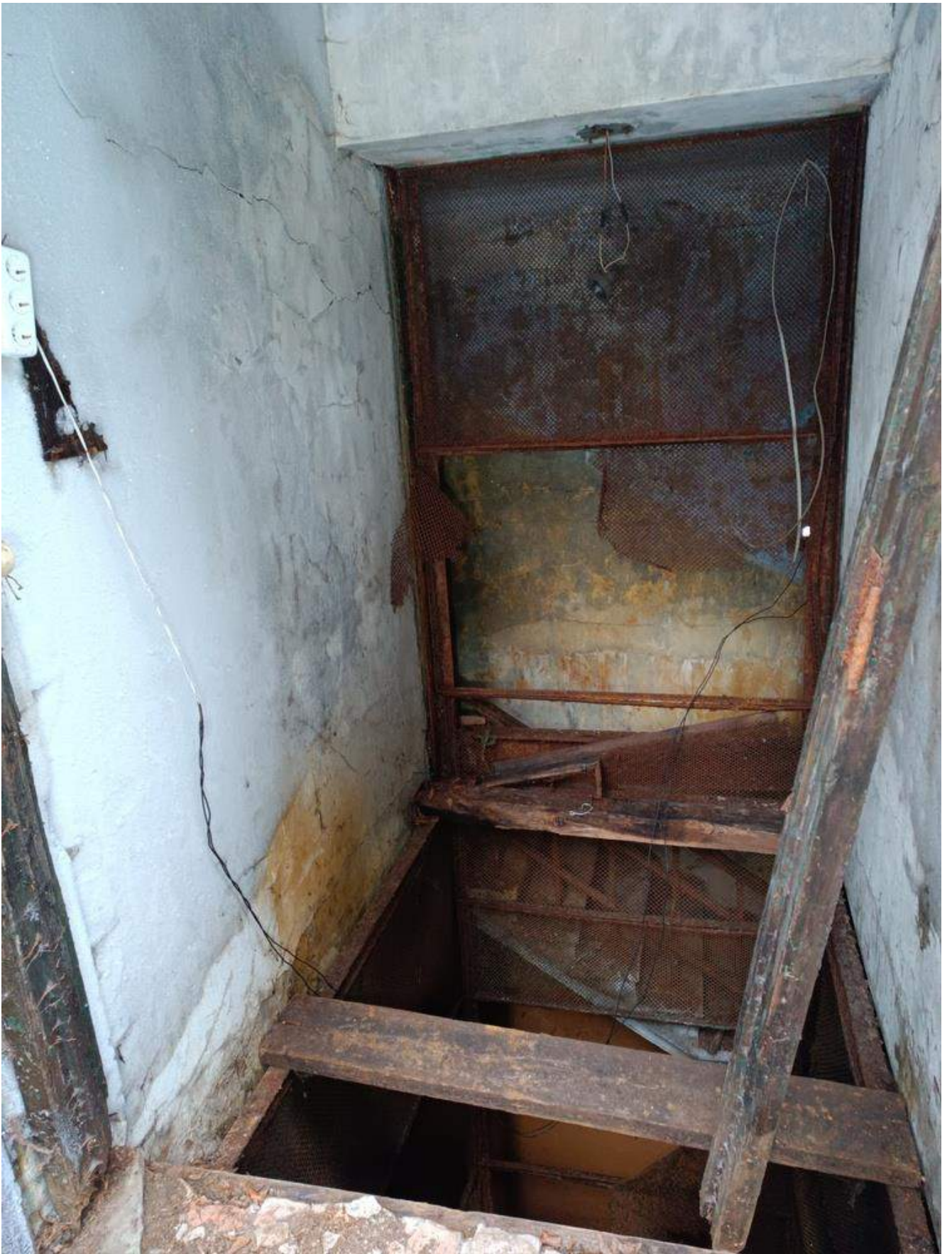
Фото 1.83 Внутренняя часть здания. Бомбоубежище
