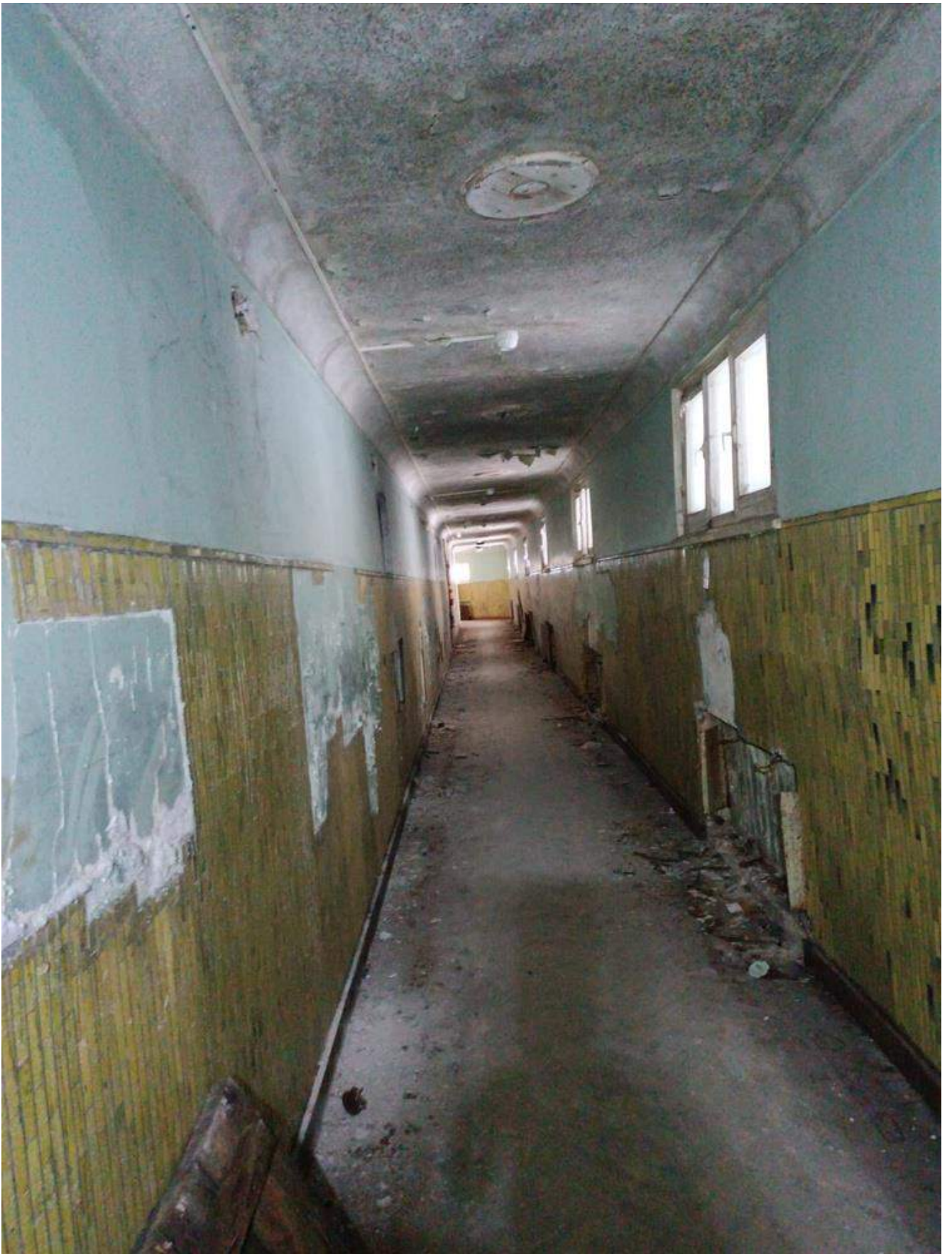
Фото 1.80 Внутренняя часть здания. Бассейн
