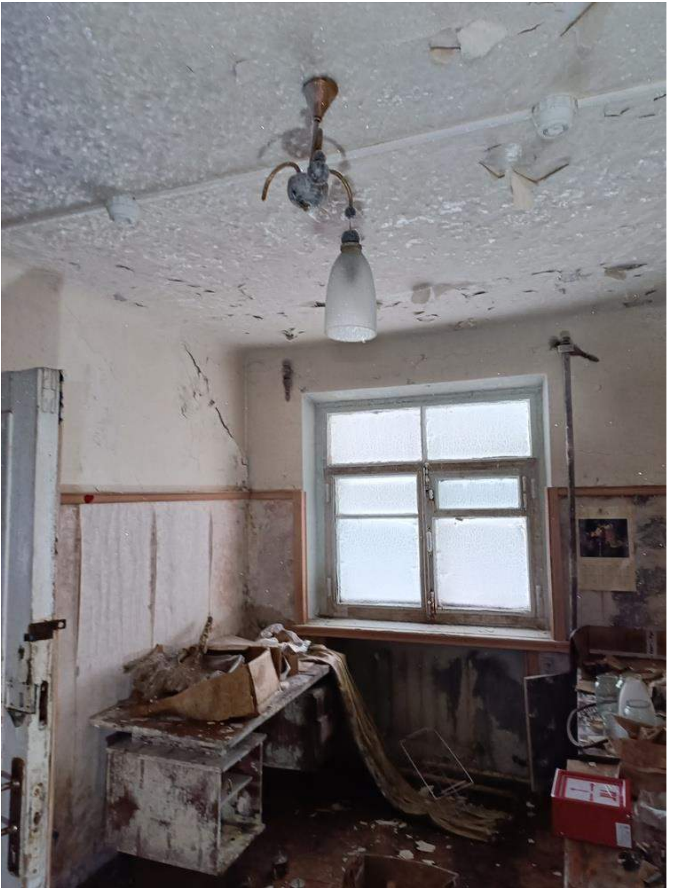
Фото 1.36 Внутренняя часть здания. Административный корпус
