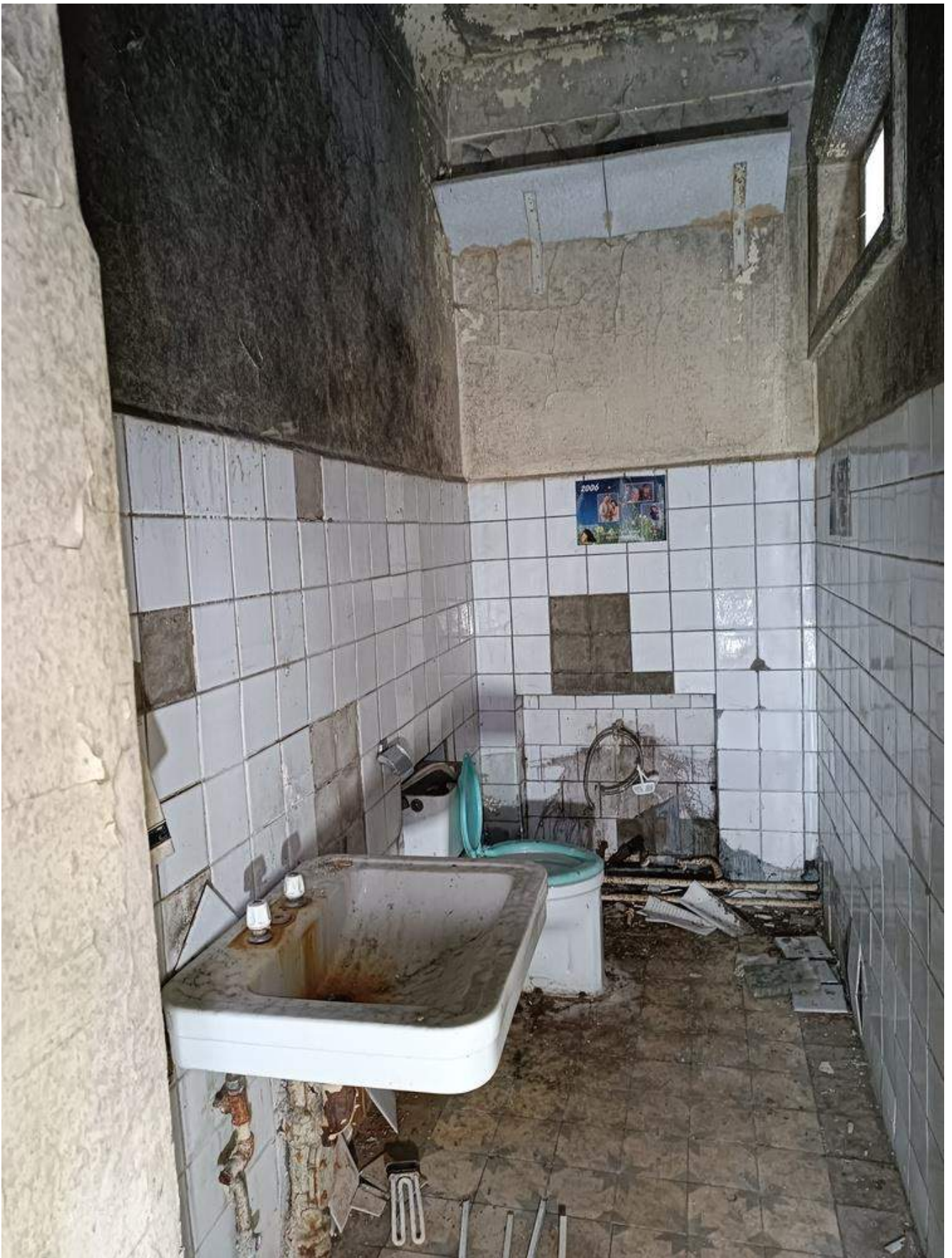
Фото 4.8 Состояние санитарно-технического узла. Демонтаж. Административный корпус
