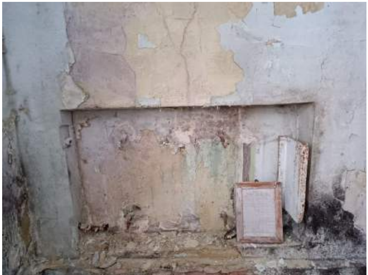
Фото 3.6 Состояние системы отопления. Демонтаж. Административный корпус
