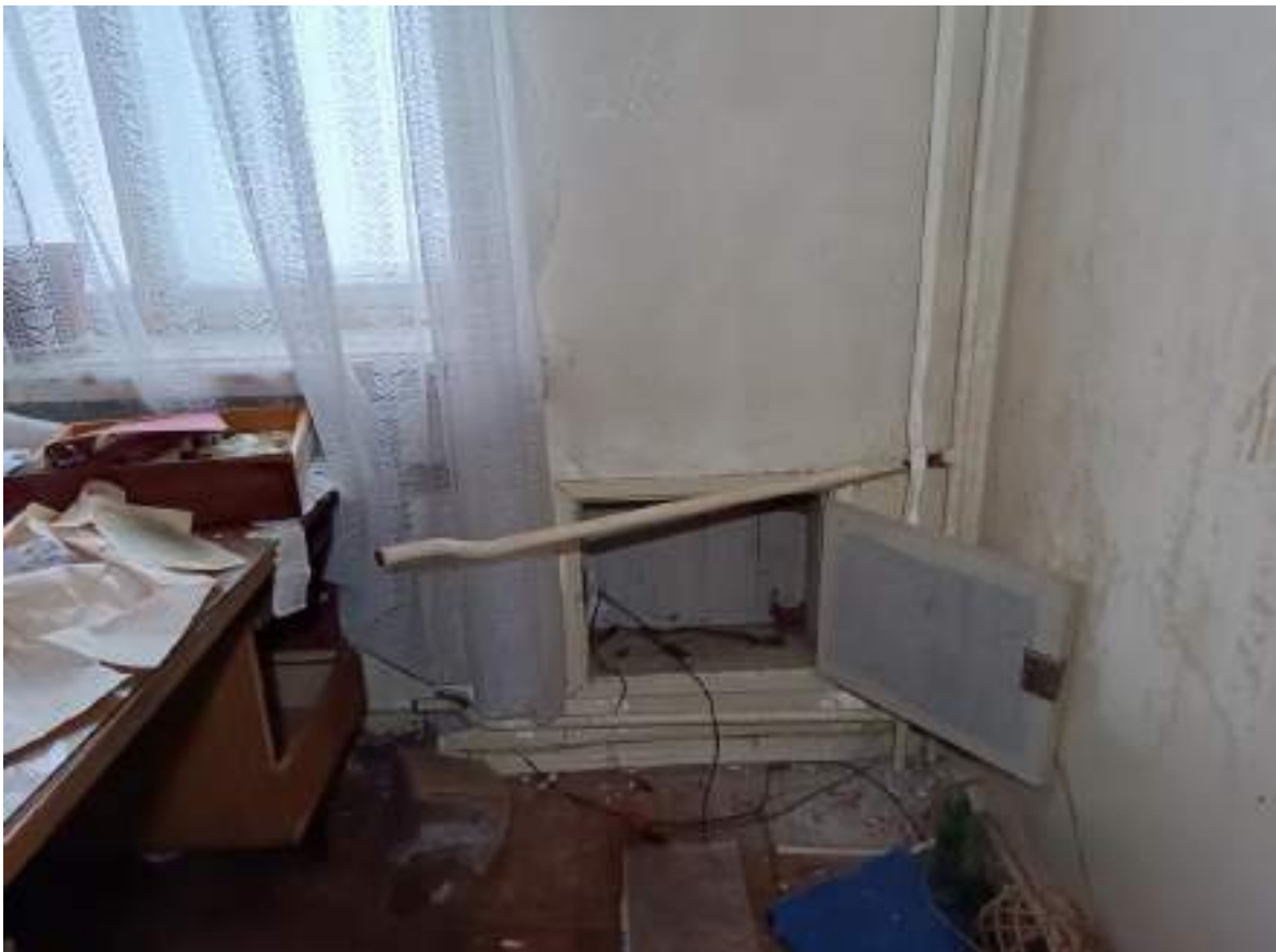
Фото 3.8 Состояние системы отопления. Демонтаж. Административный корпус
