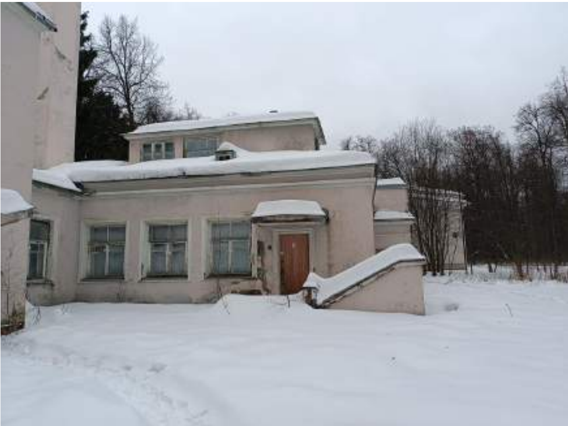
Фото 1.16 Общий вид. Административный корпус
