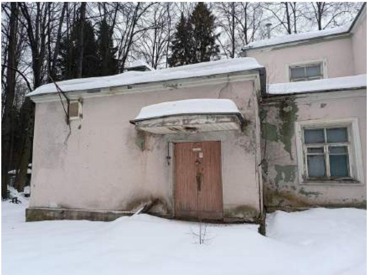
Фото 1.14 Общий вид. Административный корпус
