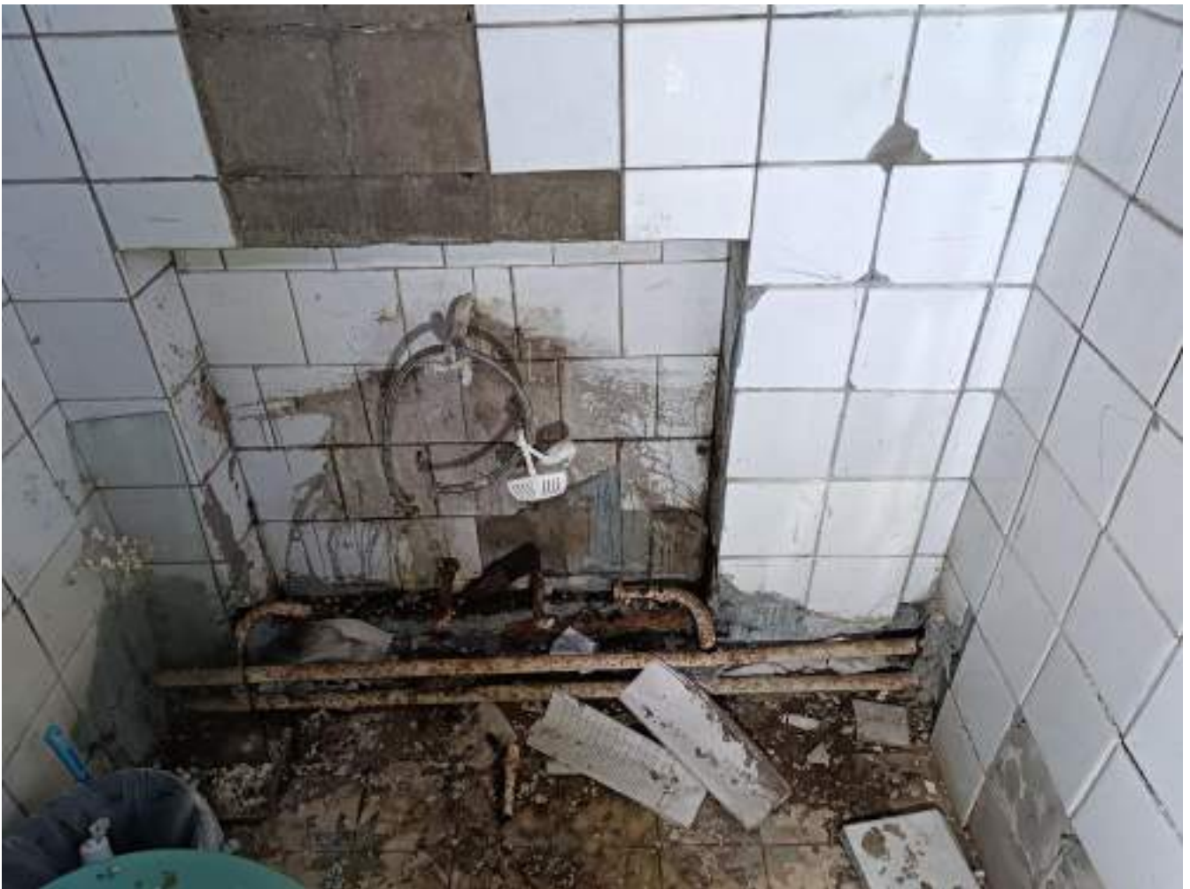
Фото 4.9 Состояние санитарно-технического узла. Демонтаж. Административный корпус
