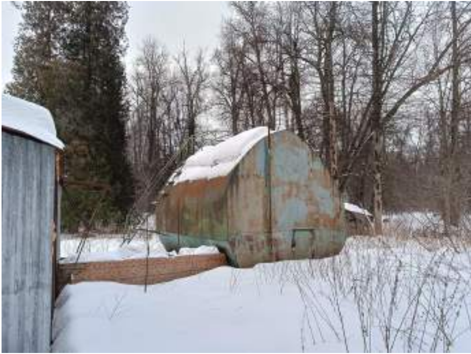
Фото 4.1 Резервуар для холодной воды в границах рассматриваемой территории
