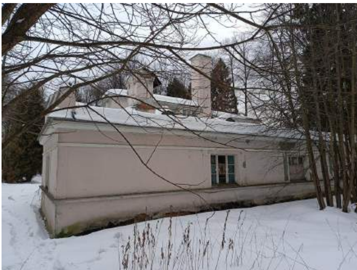
Фото 1.22 Общий вид. Административный корпус
