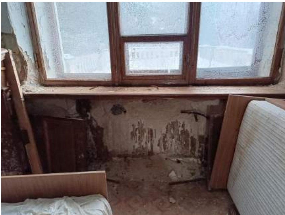
Фото 3.28 Демонтаж радиаторов отопления. Основное здание
