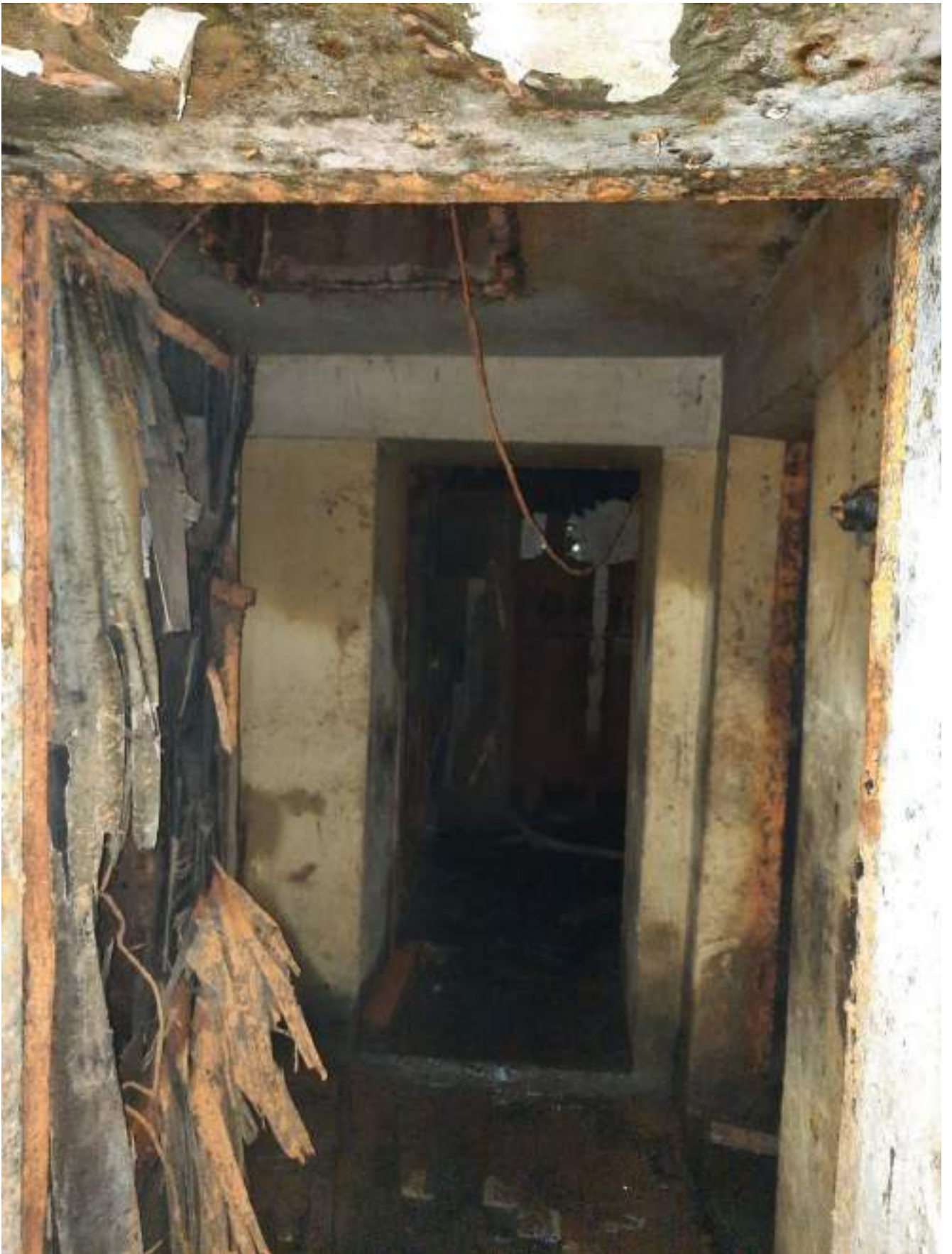
Фото 1.95 Внутренняя часть здания. Бомбоубежище
