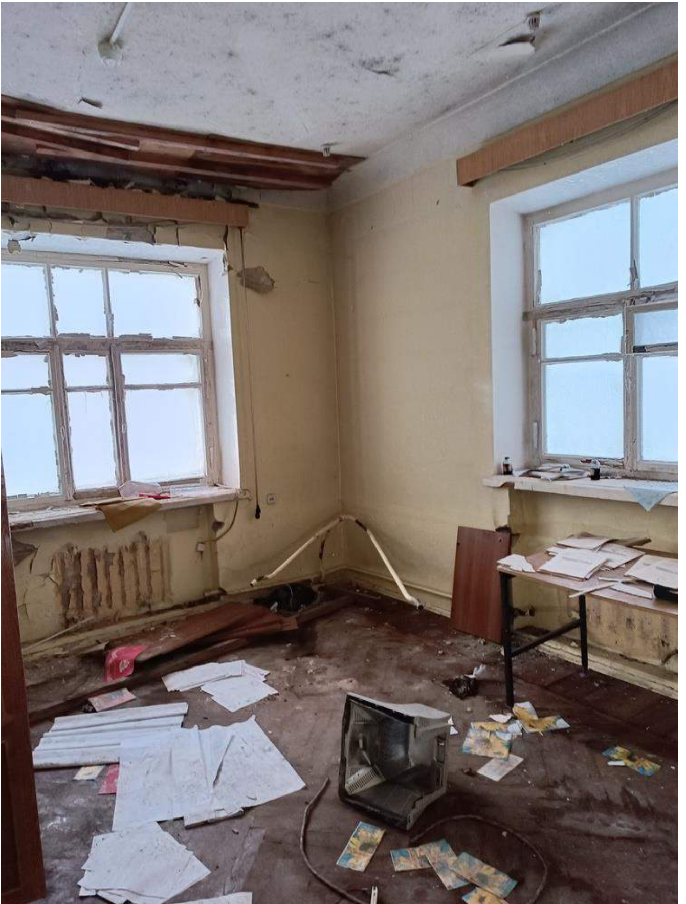
Фото 1.41 Внутренняя часть здания. Административный корпус
