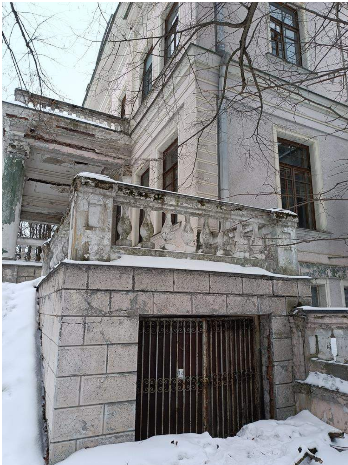
Фото 1.49 Общий вид. Основное здание
