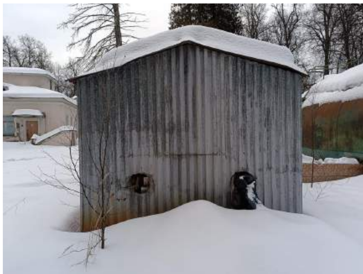
Фото 3.2 Автономный теплоисточник. Котельная
