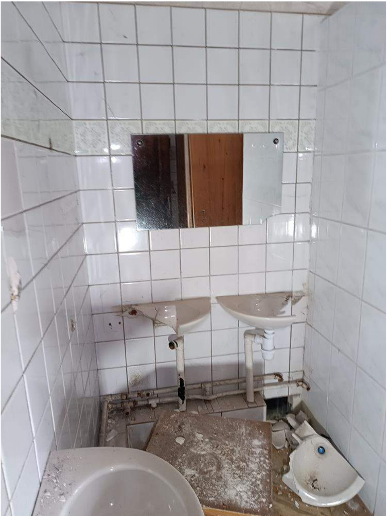
Фото 4.15 Состояние санитарно-технического узла. Демонтаж. Основное здание
