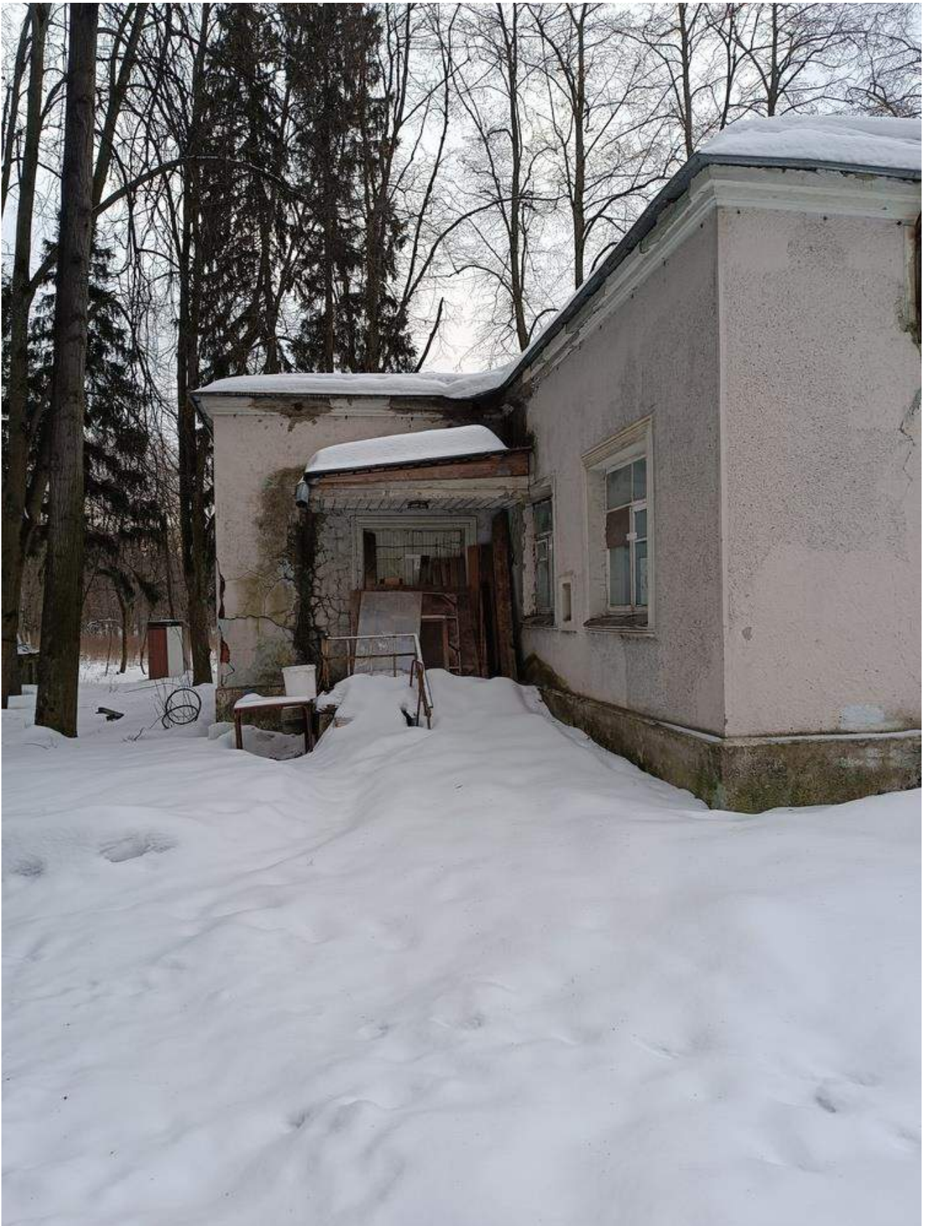
Фото 1.20 Общий вид. Административный корпус
