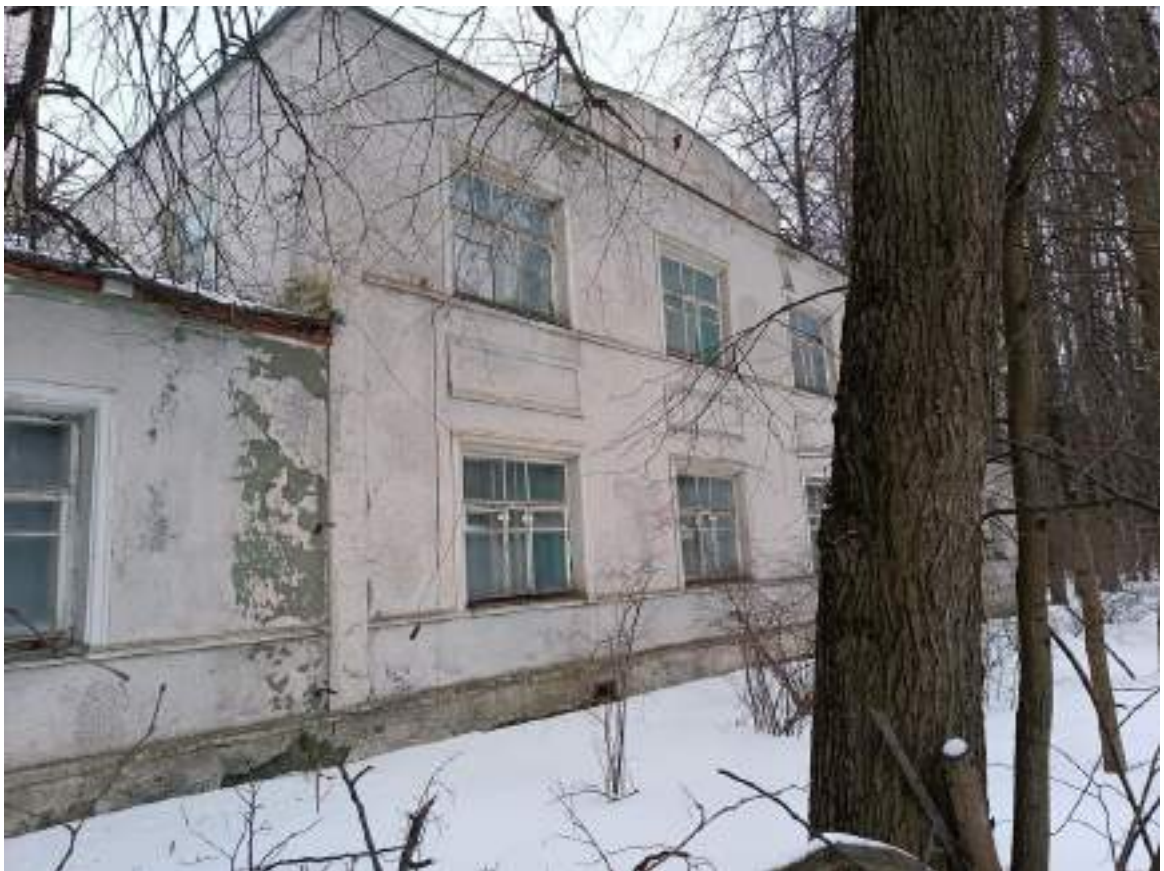
Фото 1.19 Общий вид. Административный корпус
