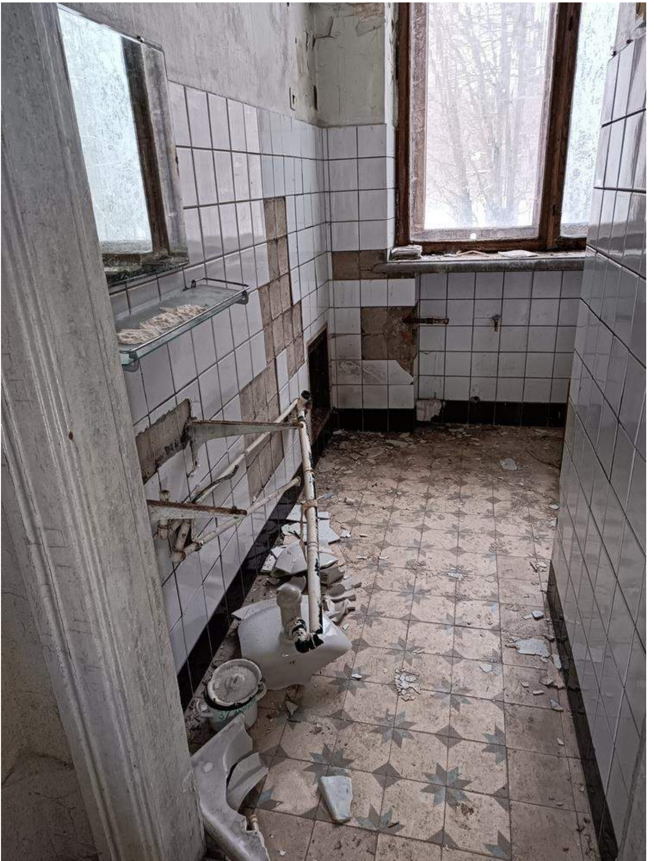
Фото 4.14 Состояние санитарно-технического узла. Демонтаж. Основное здание
