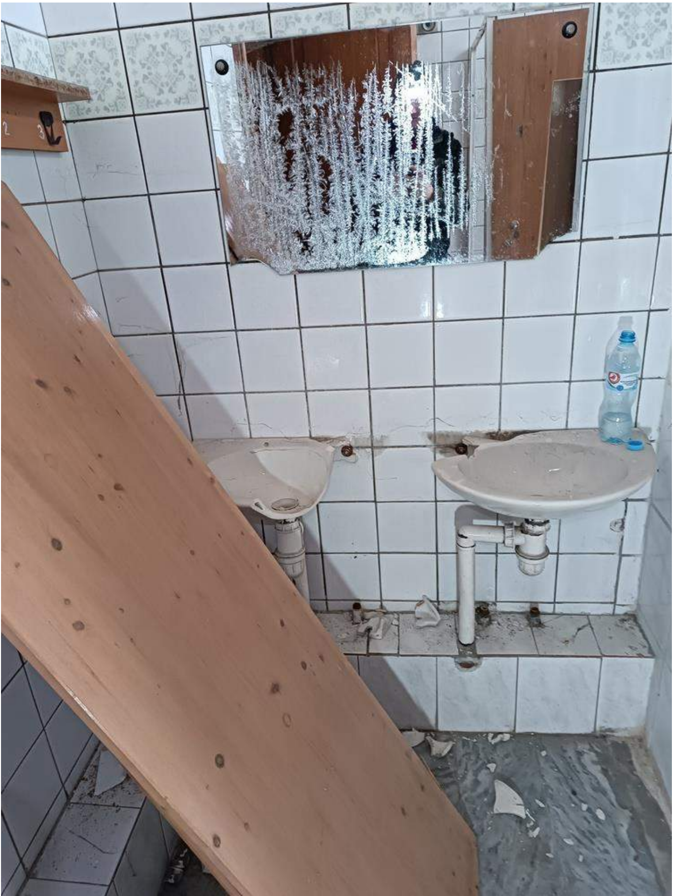
Фото 4.21 Состояние санитарно-технического узла. Демонтаж. Основное здание
