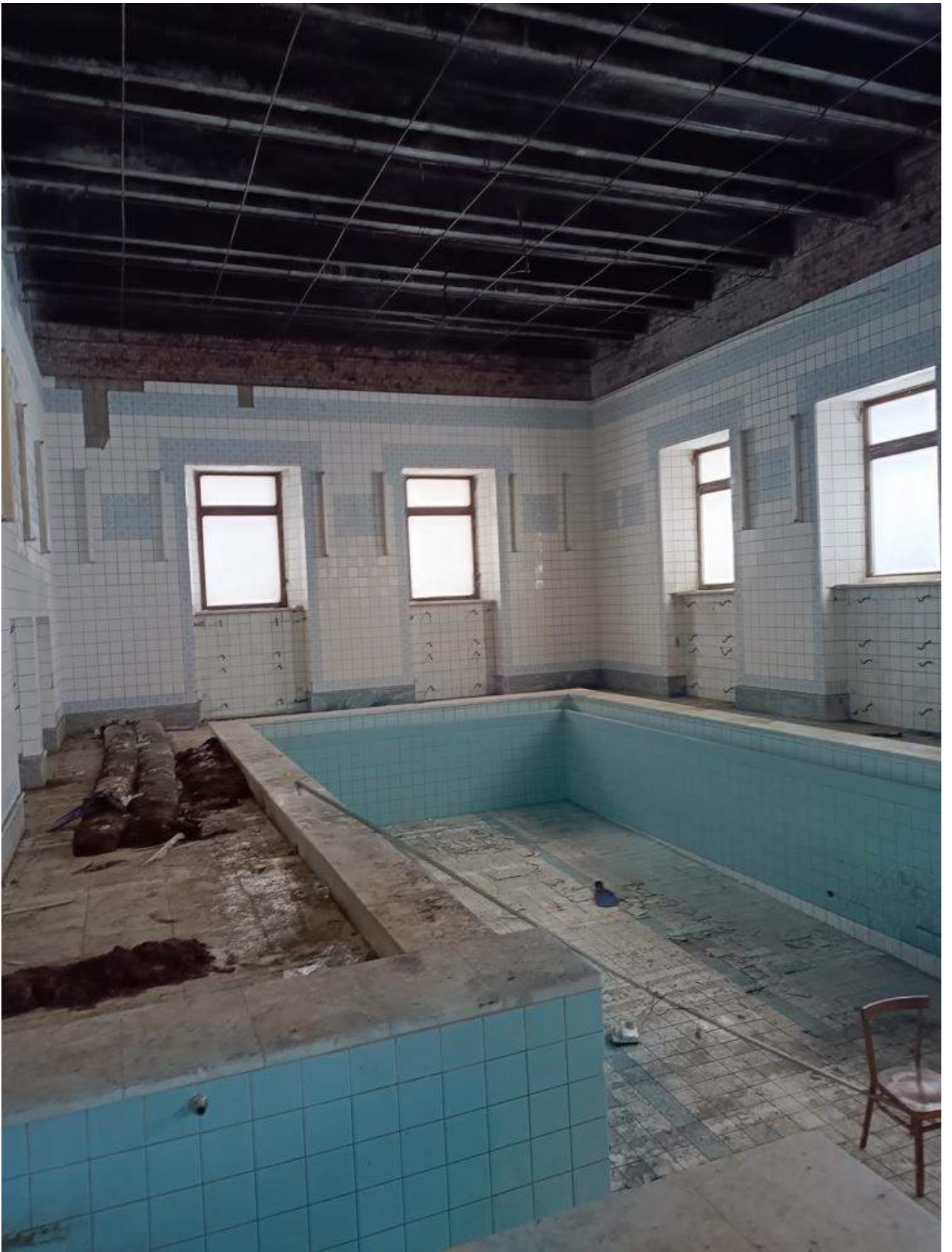
Фото 1.78 Внутренняя часть здания. Бассейн
