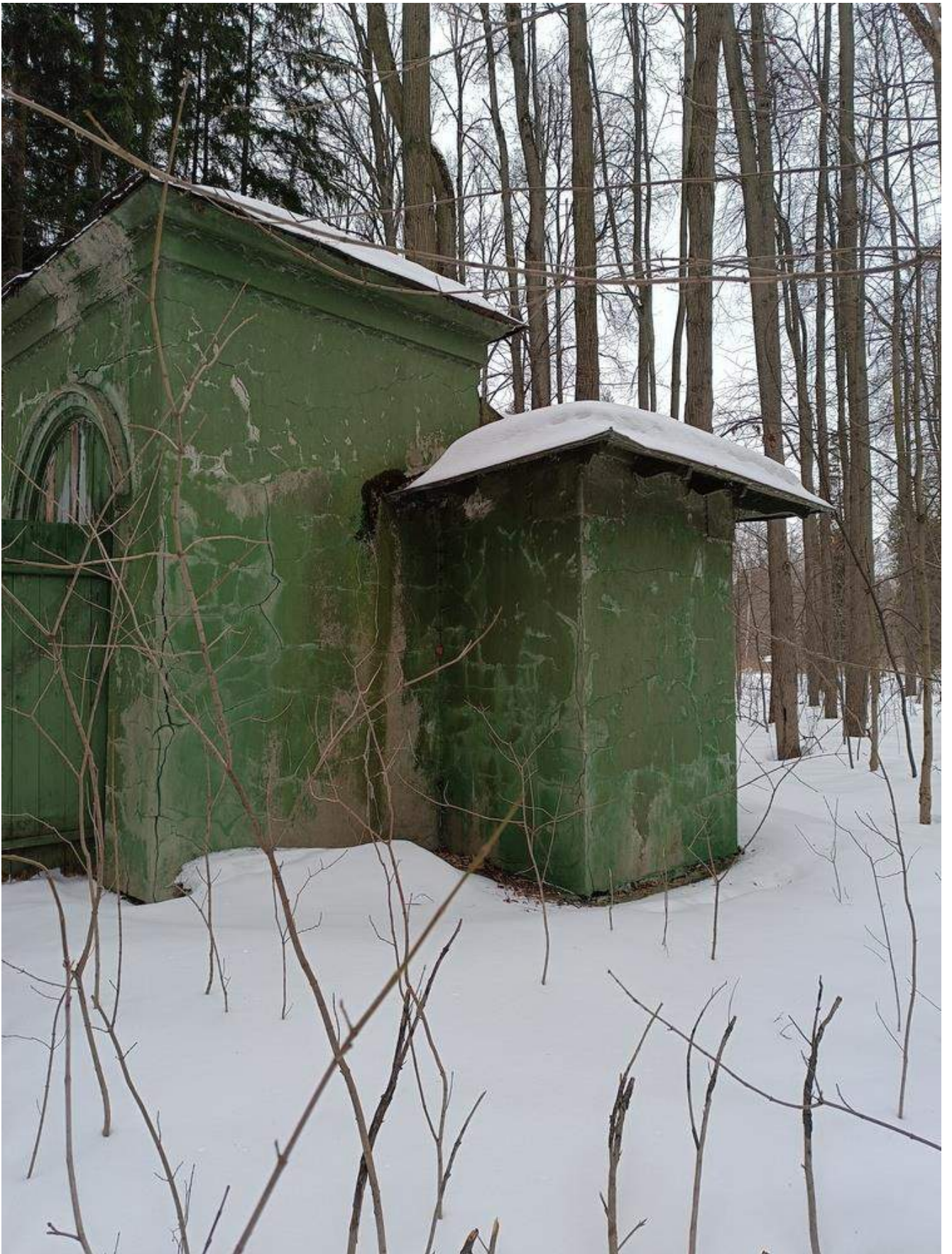
Фото 1.82 Общий вид. Бомбоубежище
