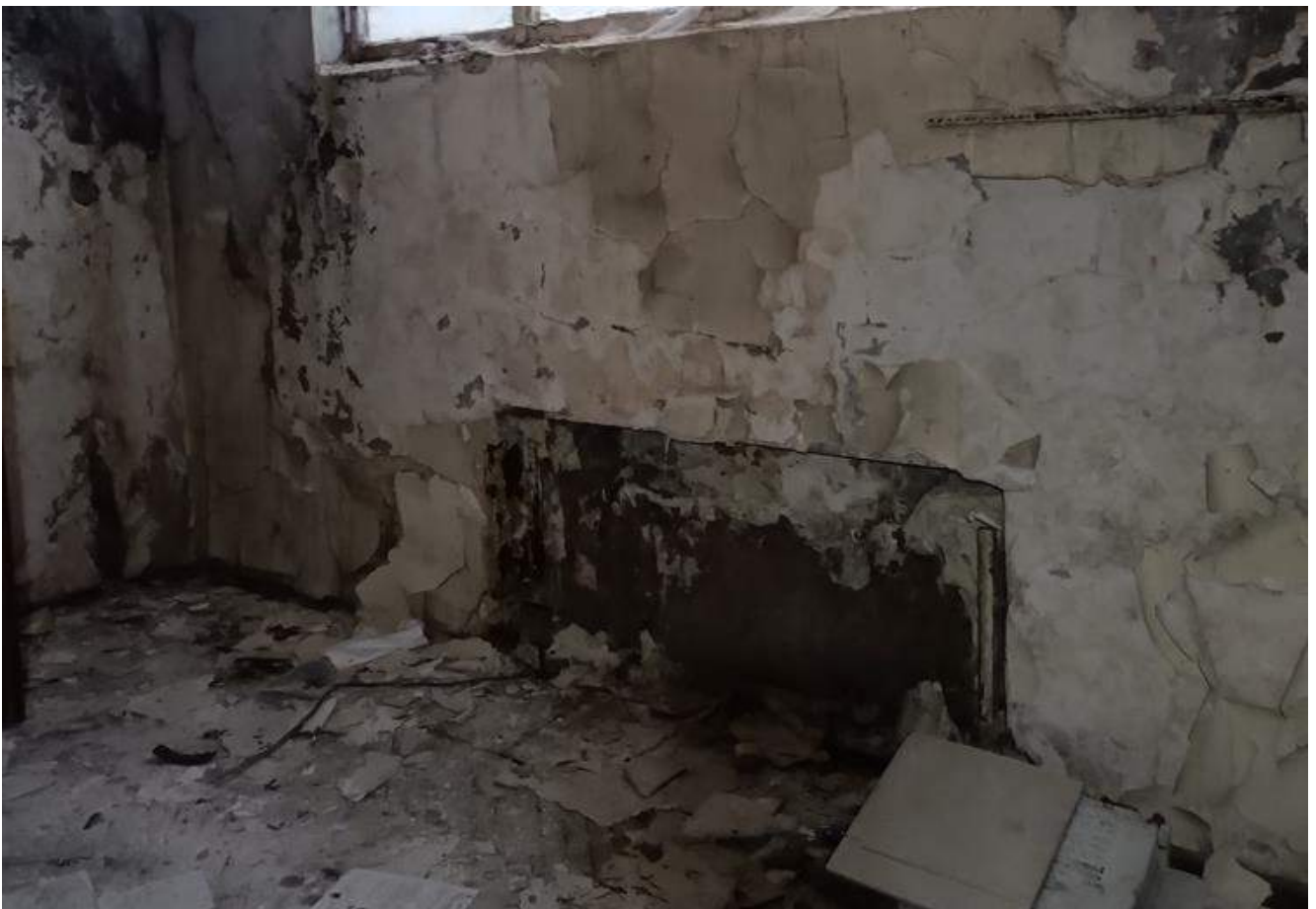
Фото 3.19 Состояние системы отопления. Демонтаж. Основное здание
