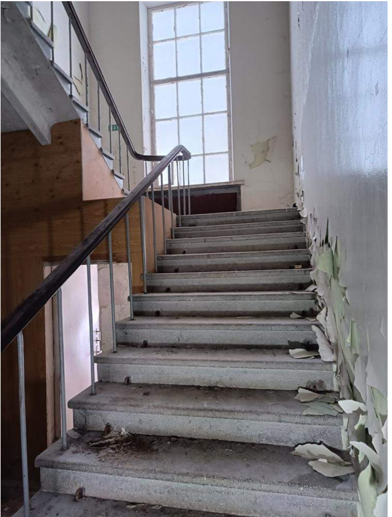
Фото 1.38 Внутренняя часть здания. Административный корпус
