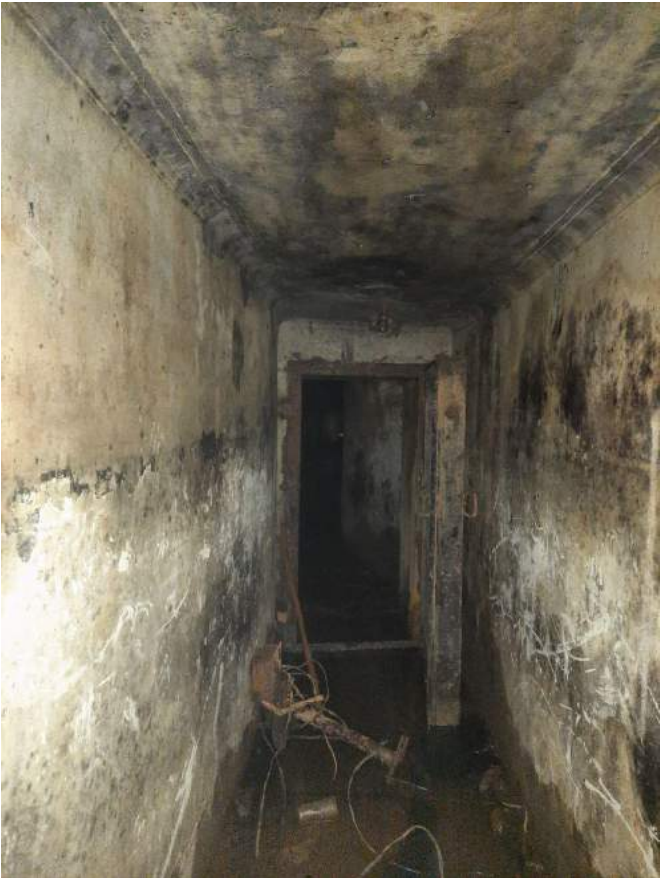
Фото 1.93 Внутренняя часть здания. Бомбоубежище
