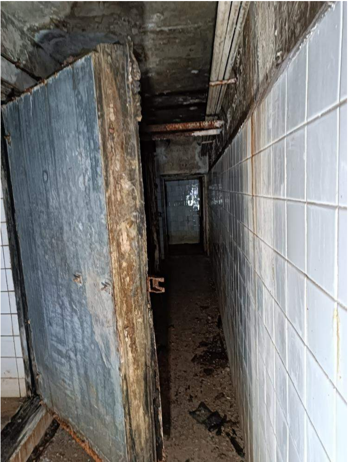
Фото 1.89 Внутренняя часть здания. Бомбоубежище
