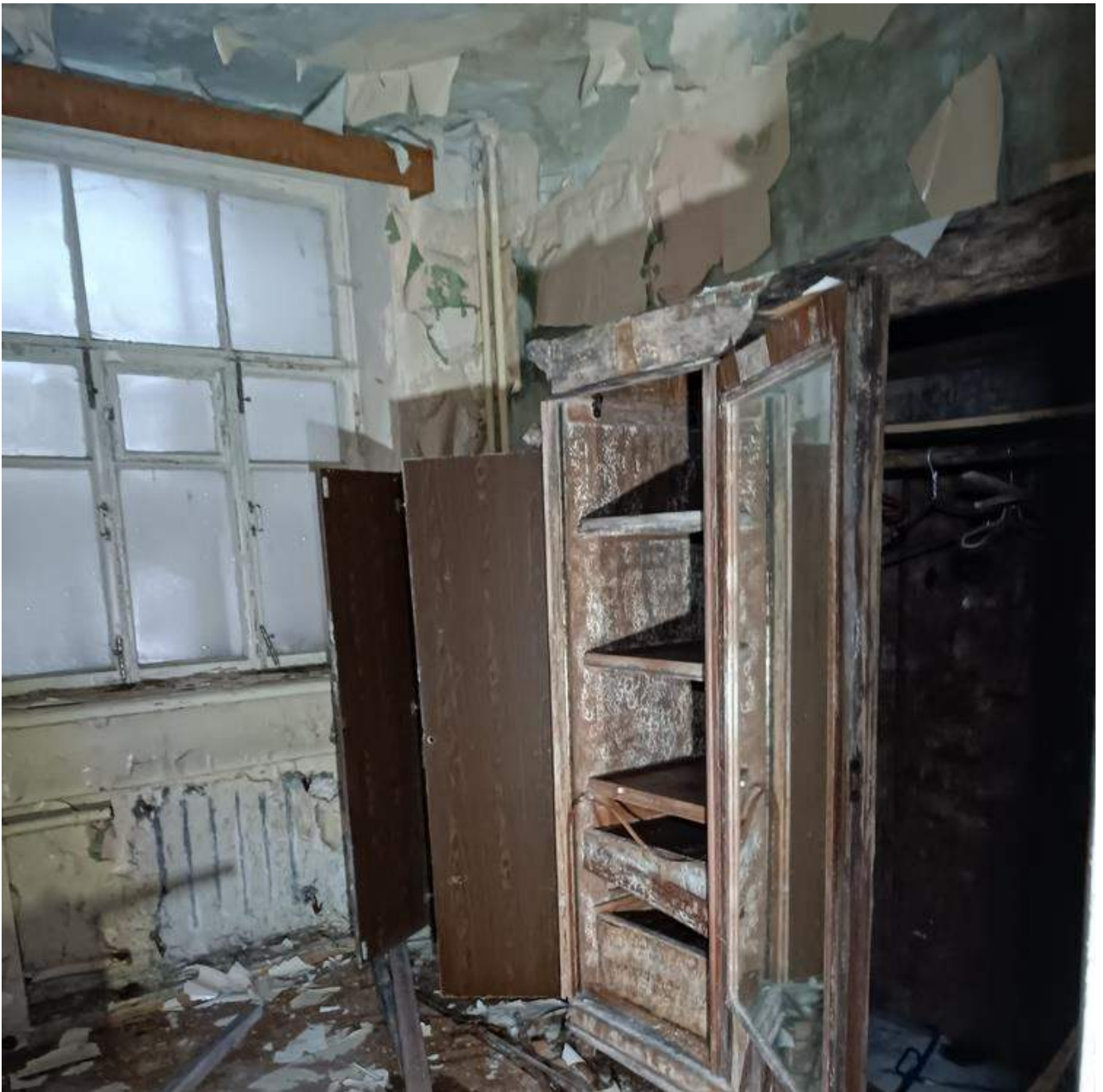
Фото 3.20 Состояние системы отопления. Демонтаж. Основное здание
