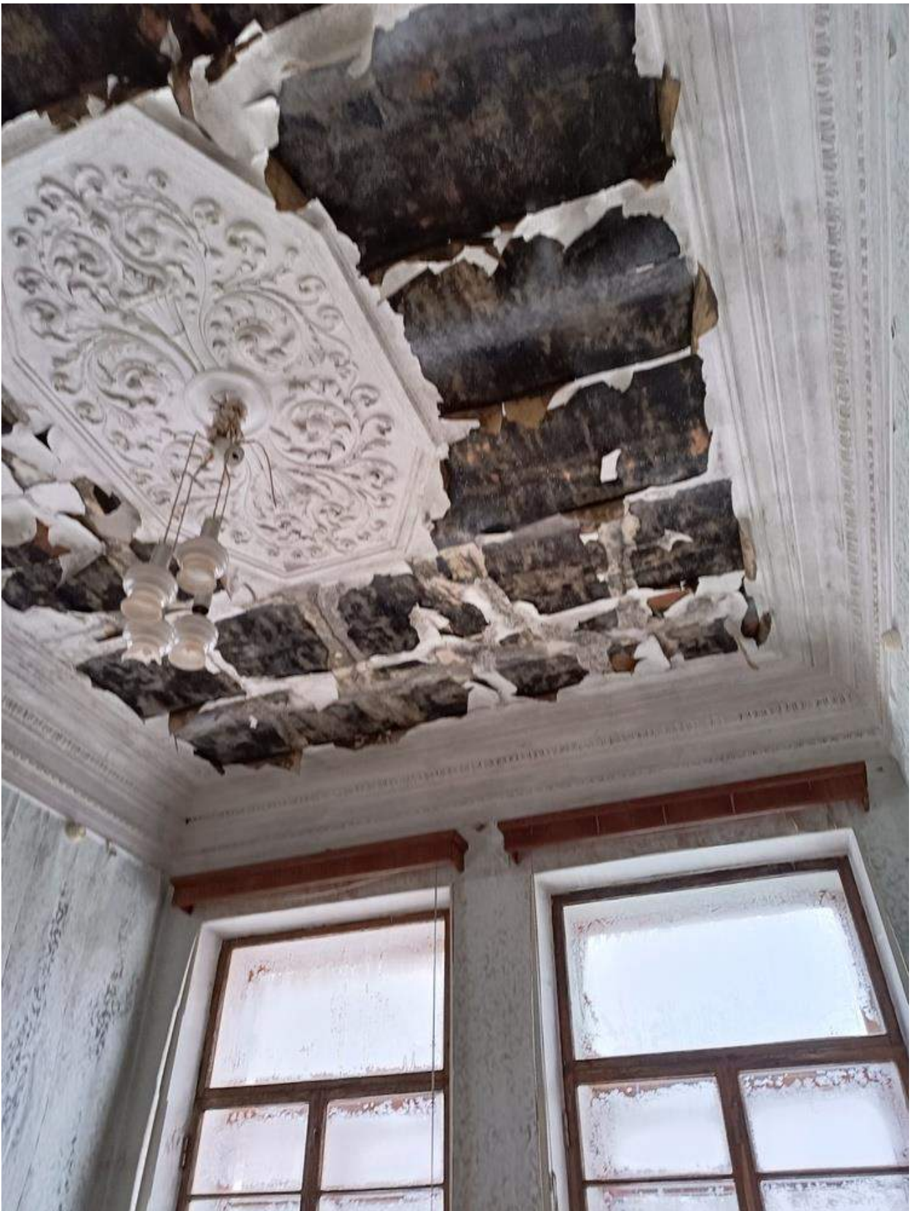
Фото 2.21 Состояние приборов освещения. Основное здание
