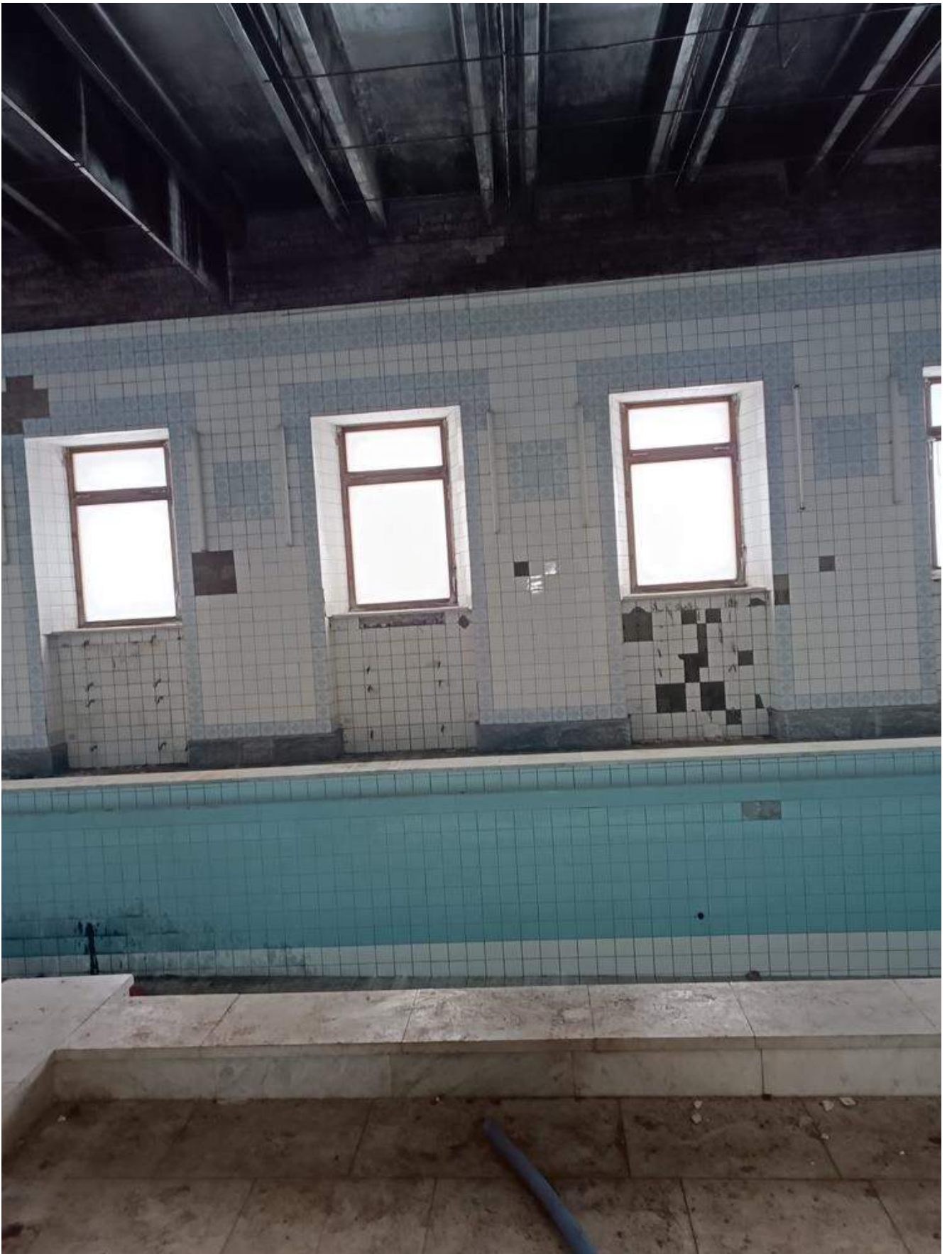
Фото 1.76 Внутренняя часть здания. Бассейн
