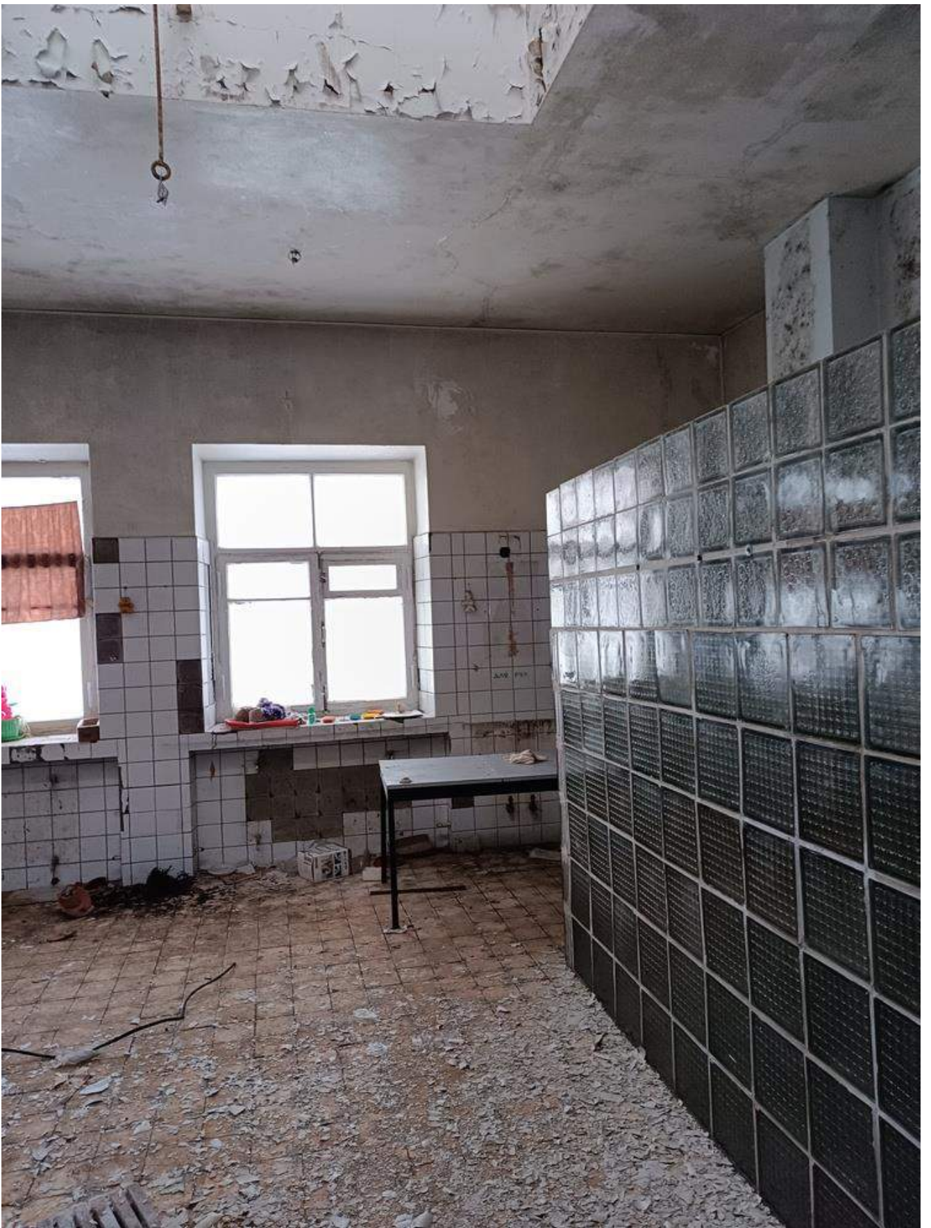
Фото 1.29 Внутренняя часть здания. Административный корпус
