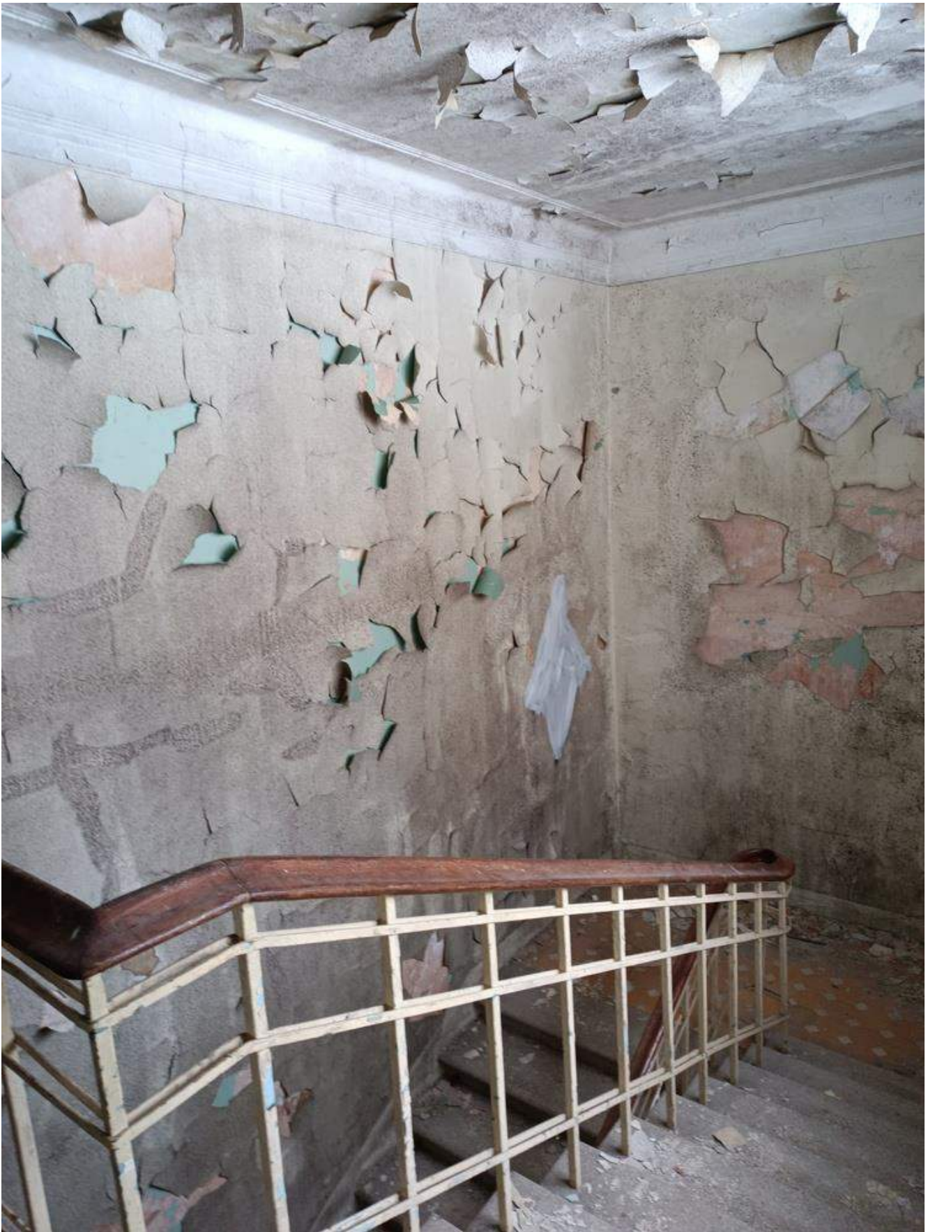
Фото 1.71 Внутренняя часть здания. Основное здание
