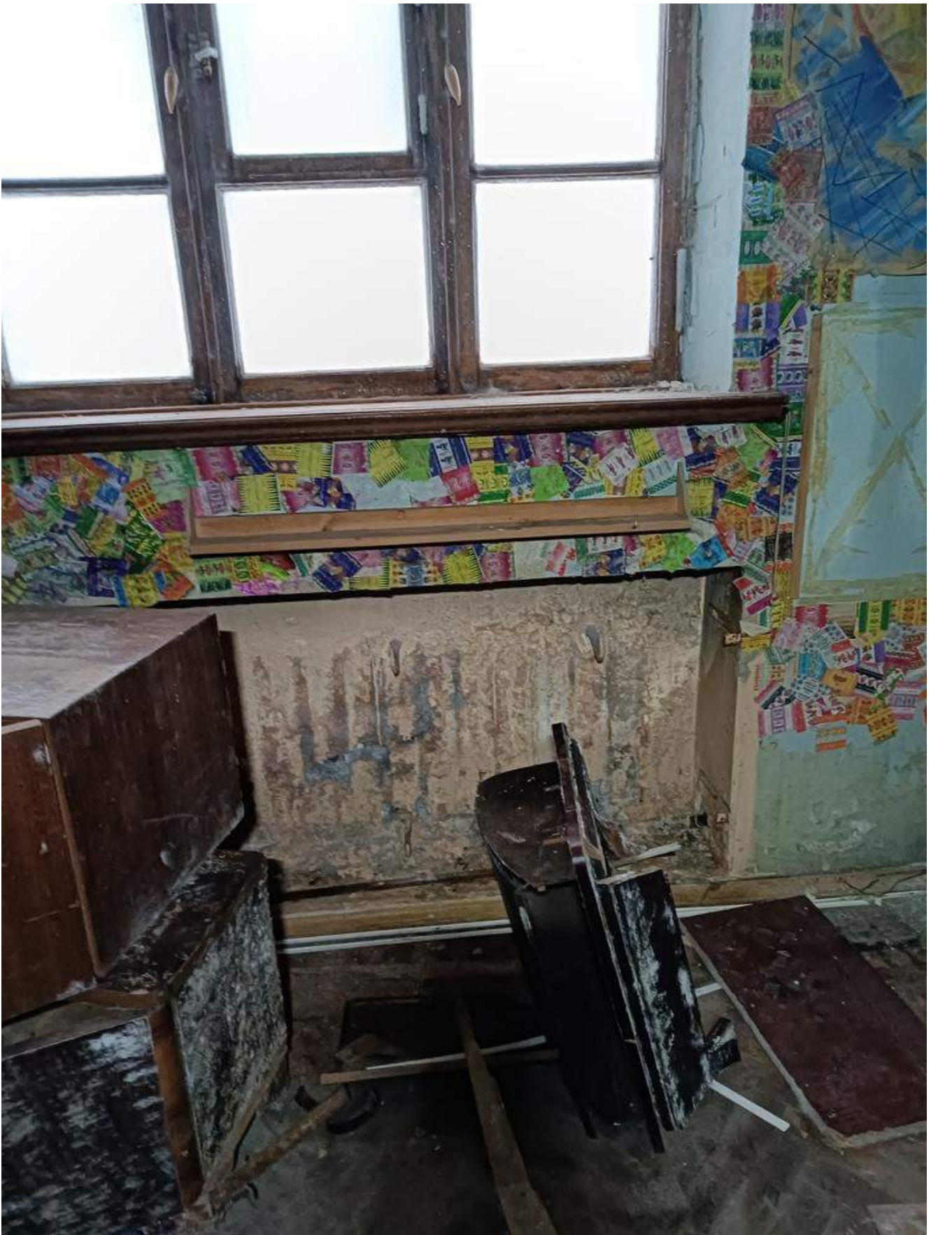
Фото 3.12 Состояние системы отопления. Демонтаж. Административный корпус
