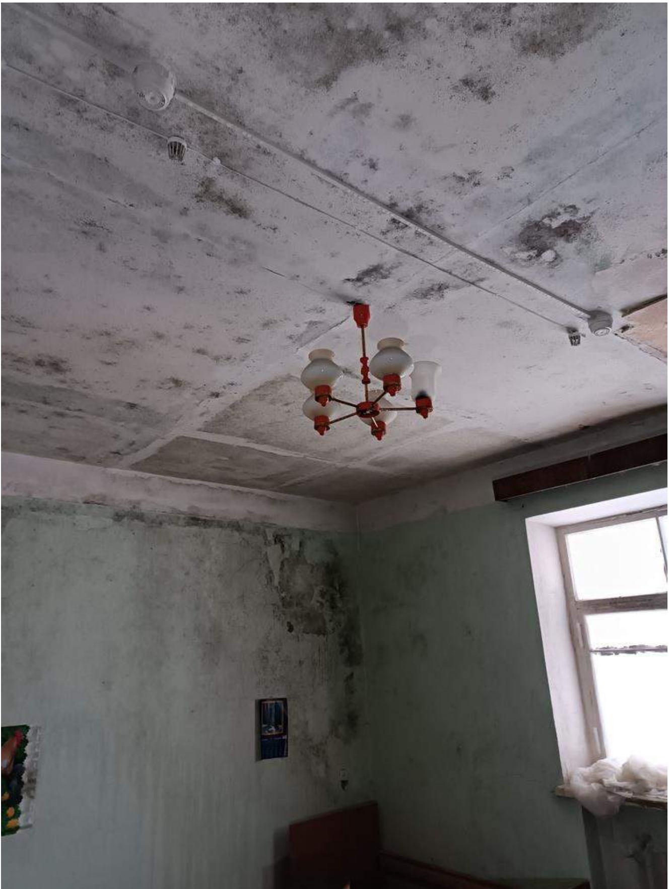
Фото 2.12 Состояние внутренних электрических сетей и освещения. Пожарно-дымовые извещатели. Административный корпус
