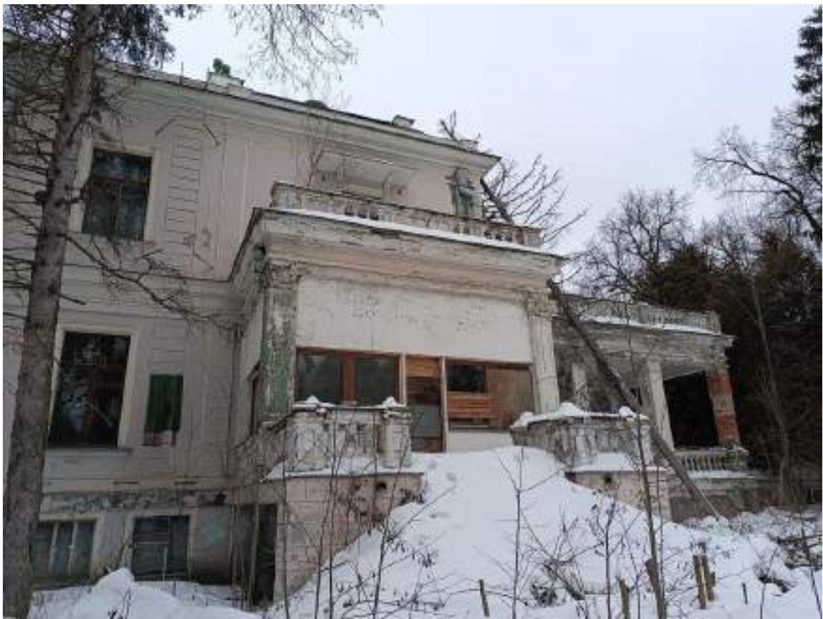
Фото 1.50 Общий вид. Основное здание
