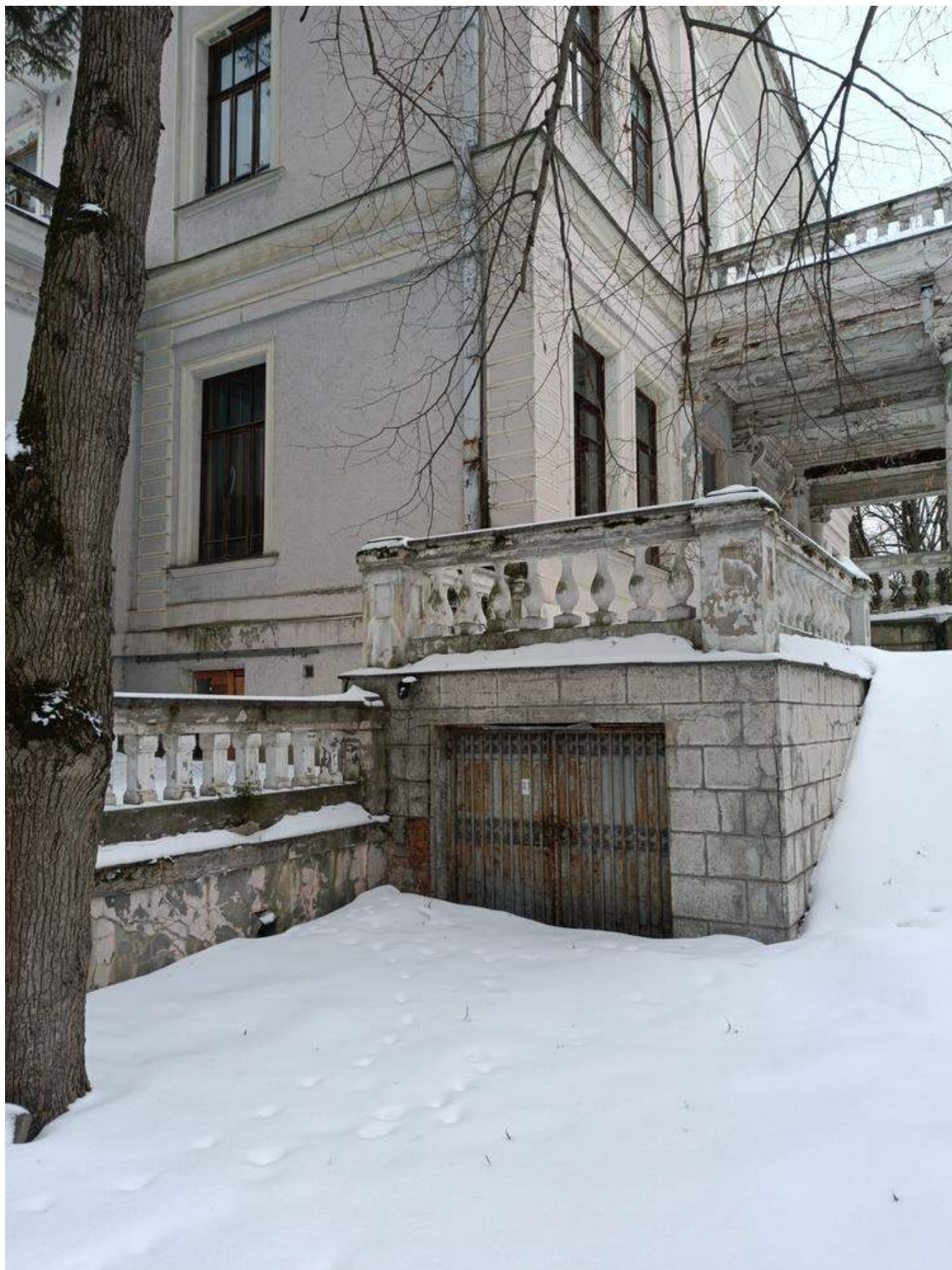
Фото 1.47 Общий вид. Основное здание
