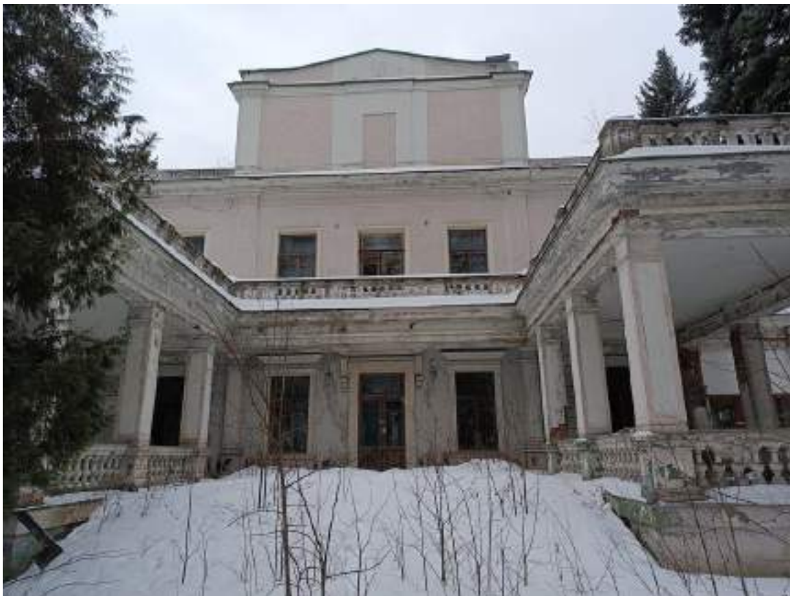
Фото 1.42 Общий вид. Основное здание
