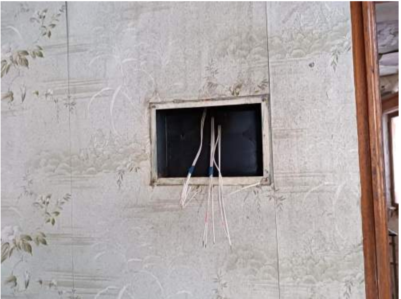
Фото 2.11 Щит управления внутренних электрических сетей. Демонтаж. Административный корпус
