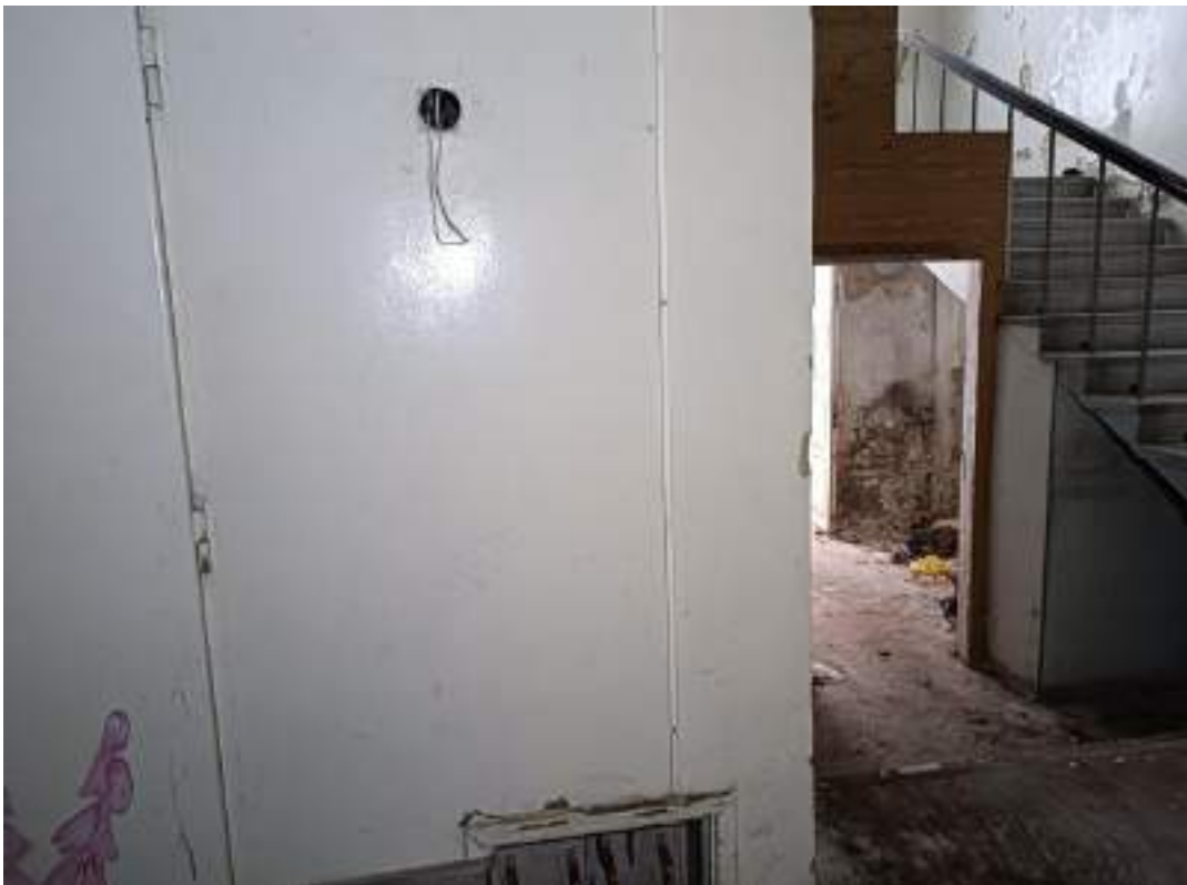
Фото 2.4 Состояние внутренних электрических сетей. Административный корпус
