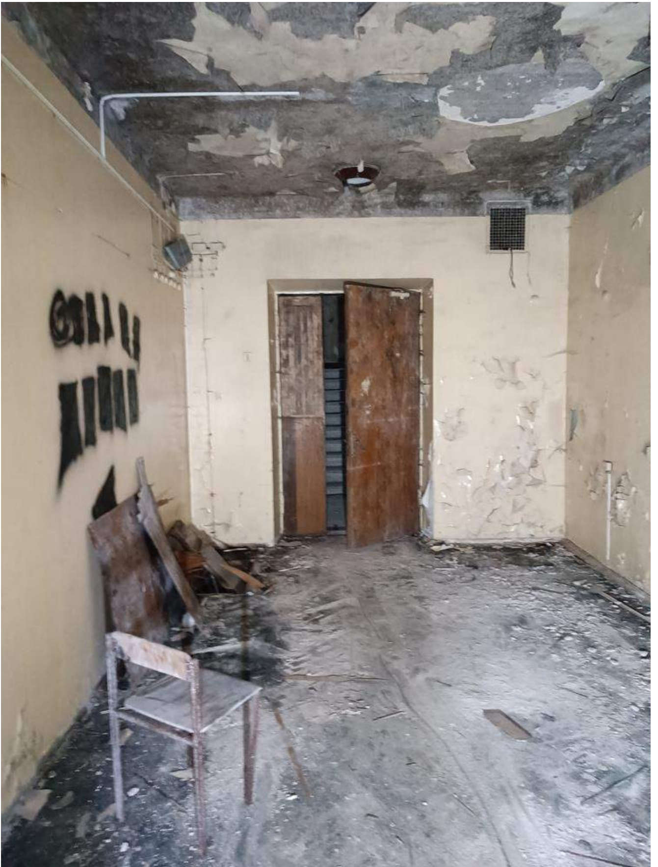
Фото 1.56 Внутренняя часть здания. Основное здание
