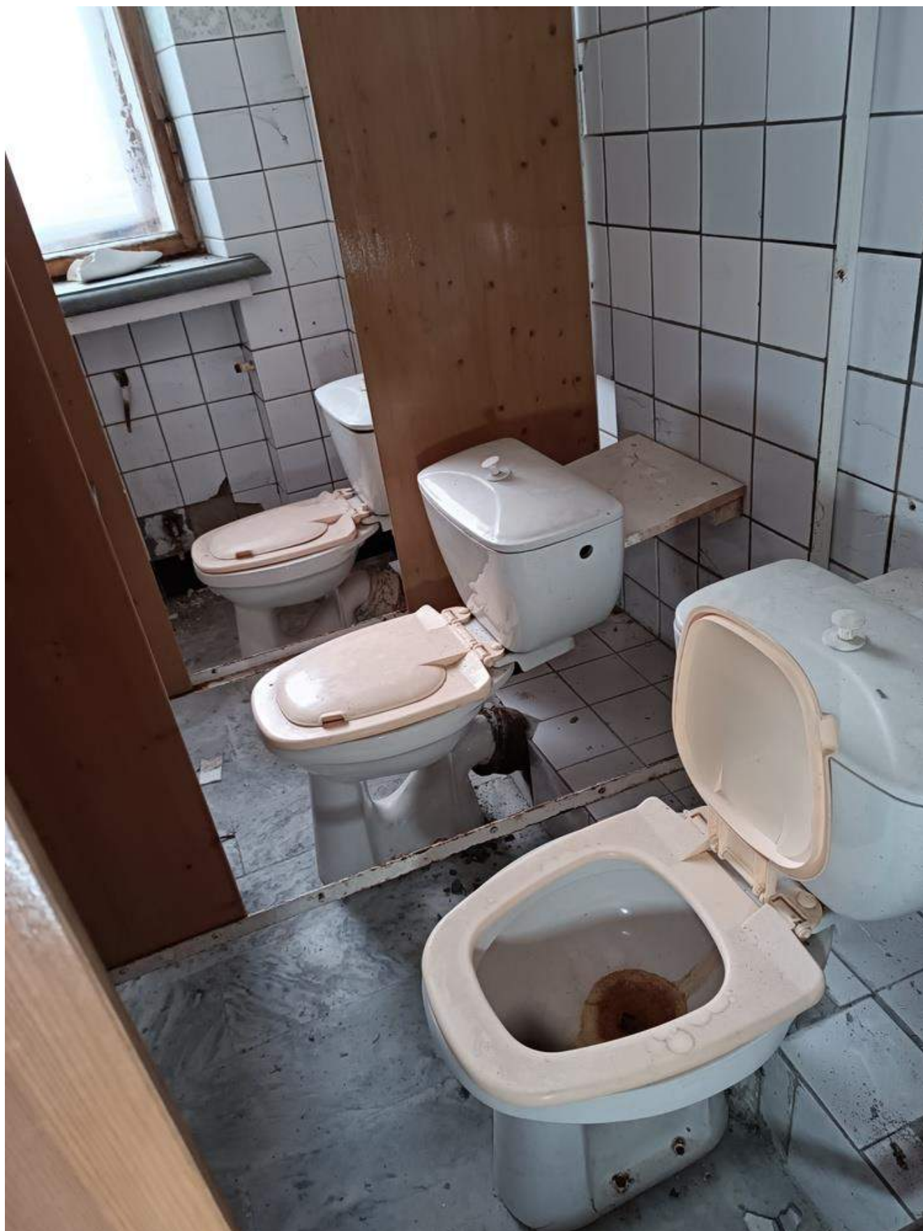
Фото 4.22 Состояние санитарно-технического узла. Основное здание
