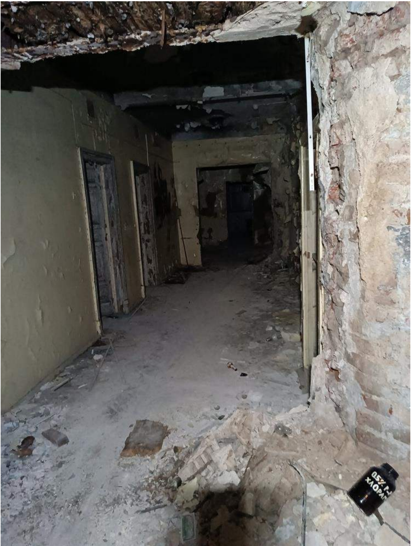
Фото 1.53 Внутренняя часть здания. Основное здание
