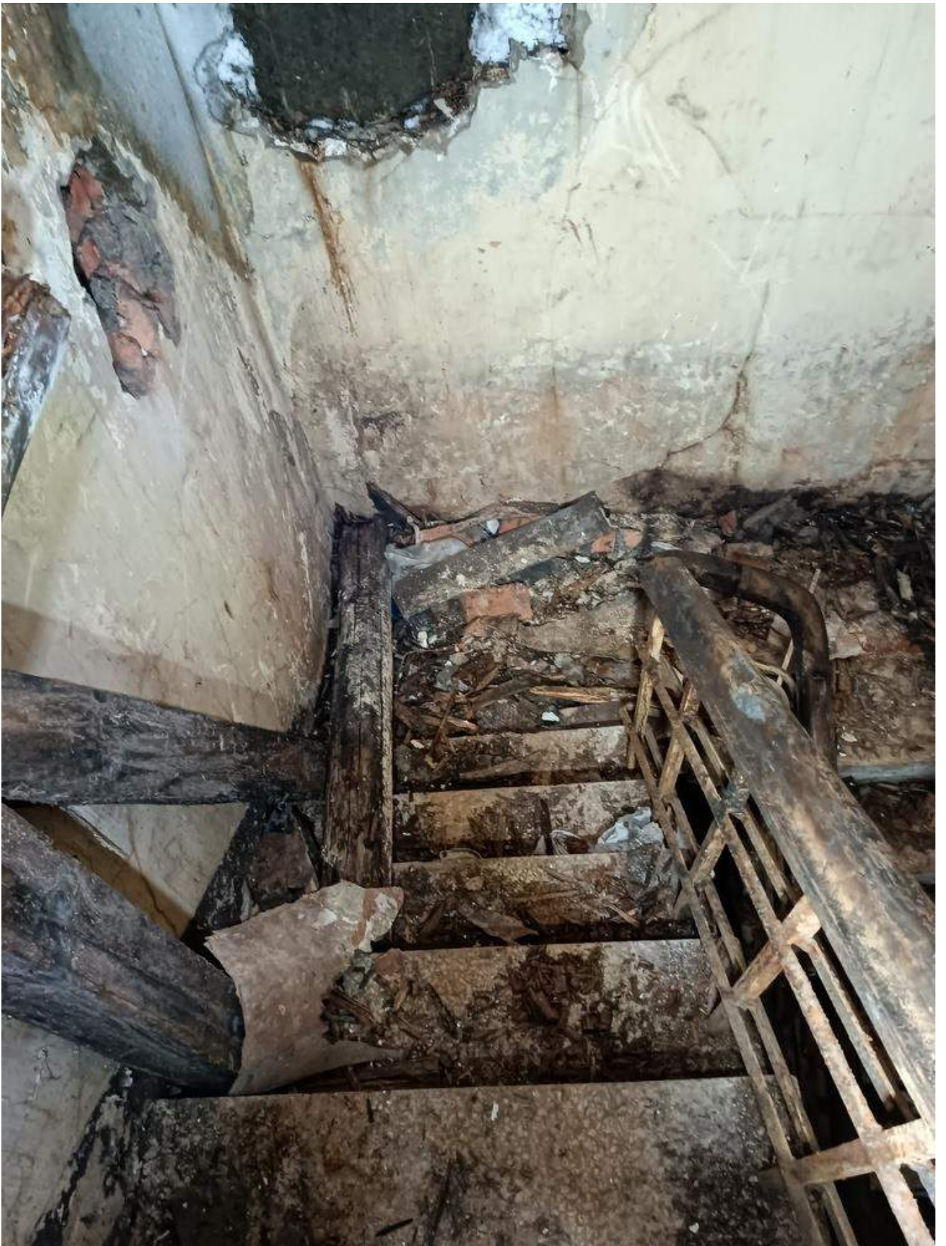
Фото 1.85 Внутренняя часть здания. Бомбоубежище
