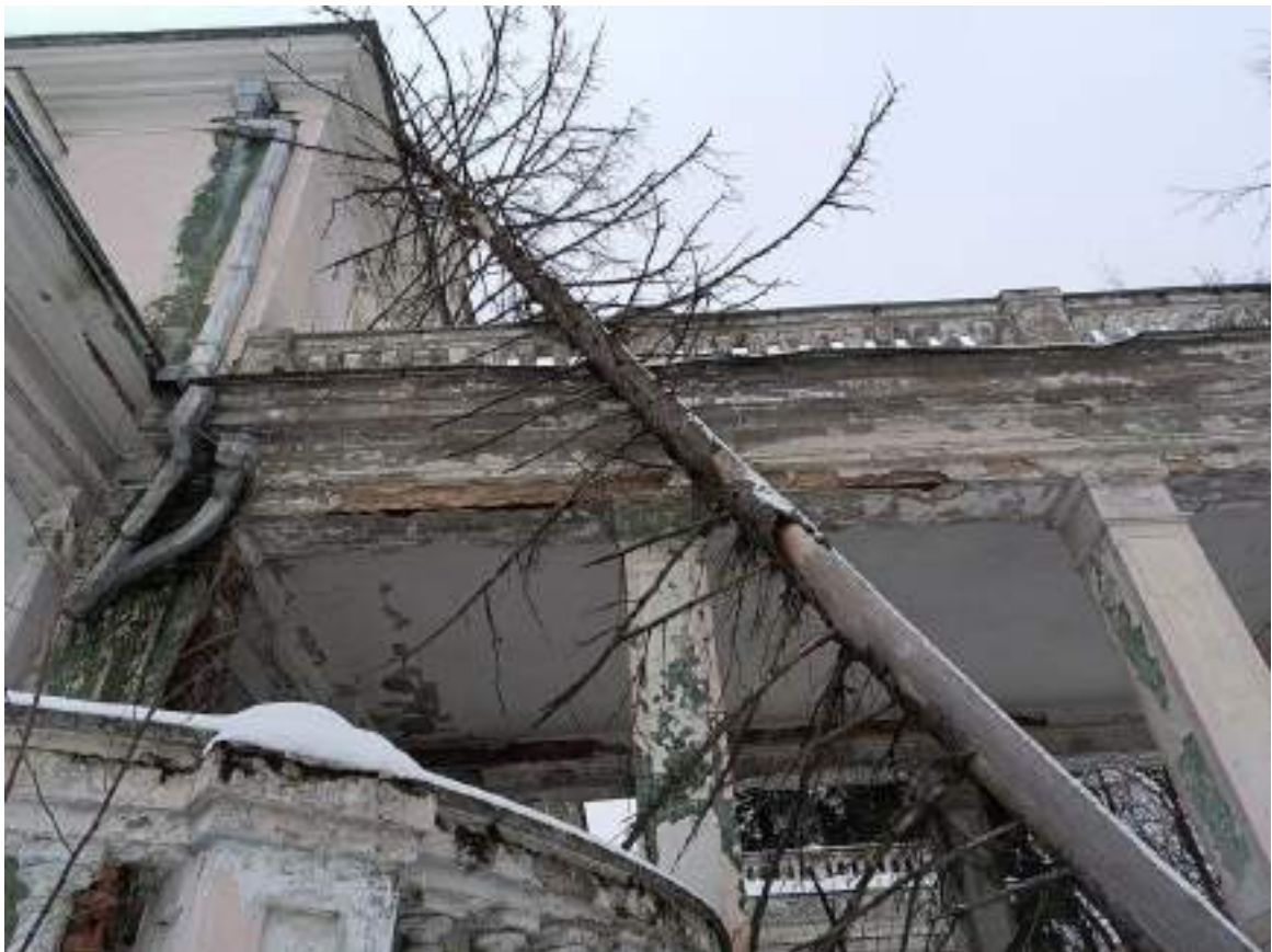
Фото 1.51 Общий вид. Основное здание
