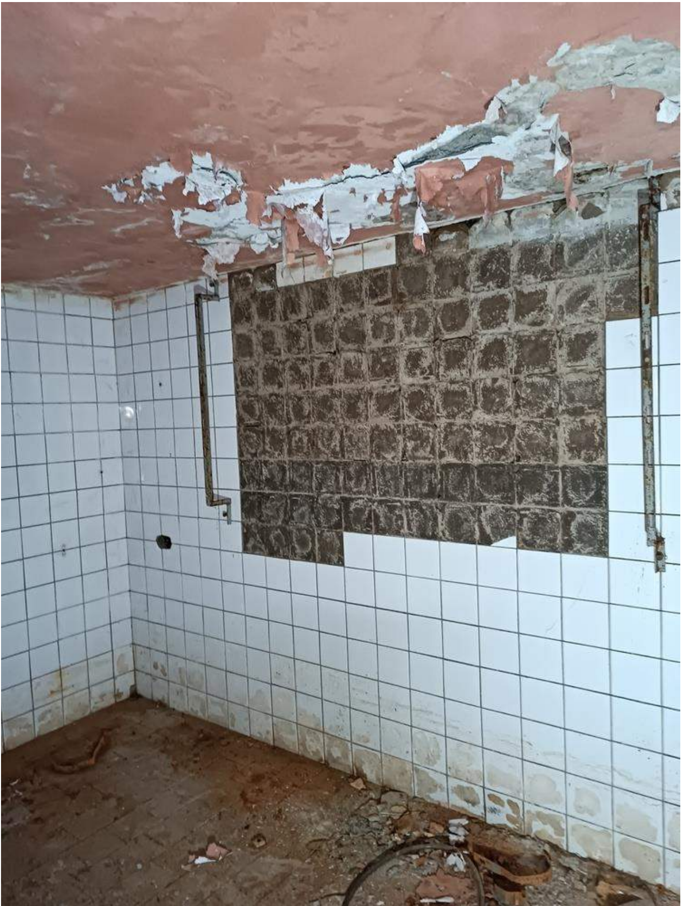
Фото 1.90 Внутренняя часть здания. Бомбоубежище
