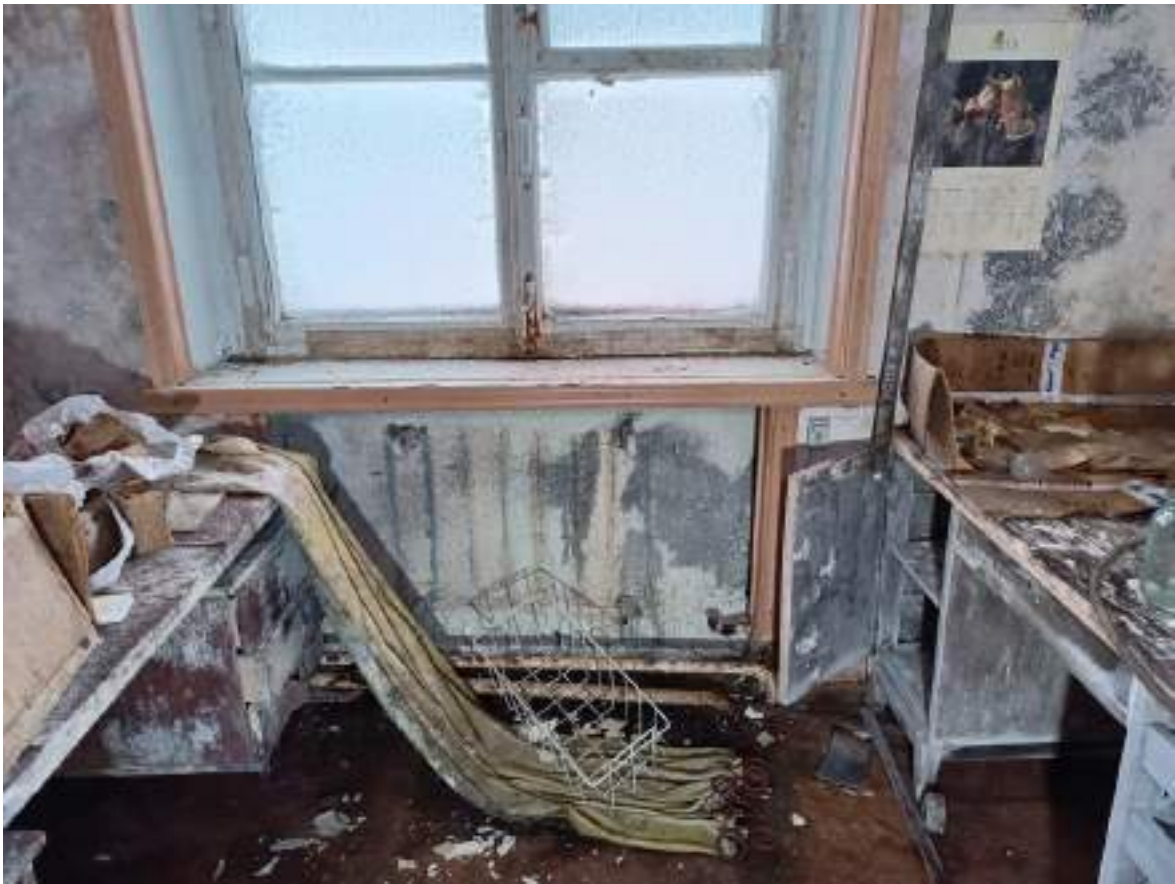
Фото 3.13 Состояние системы отопления. Демонтаж. Административный корпус
