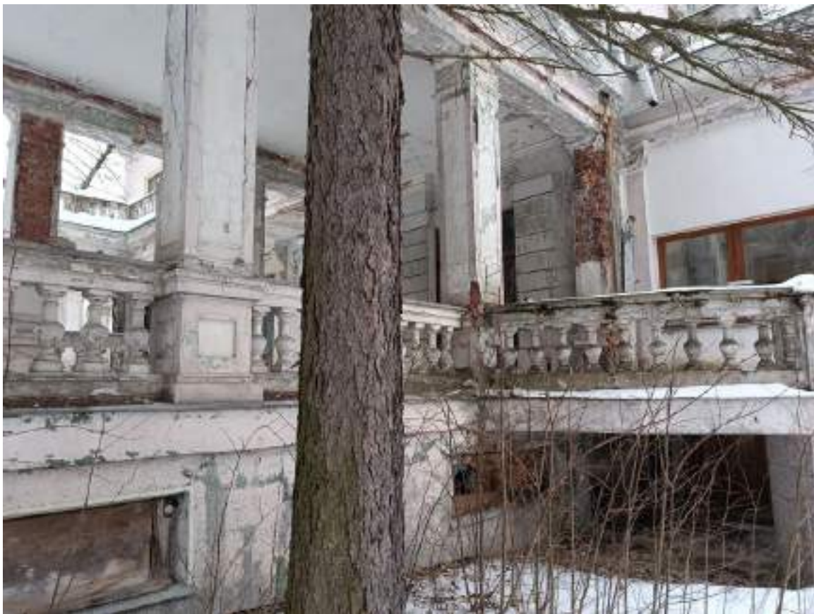
Фото 1.44 Общий вид. Основное здание
