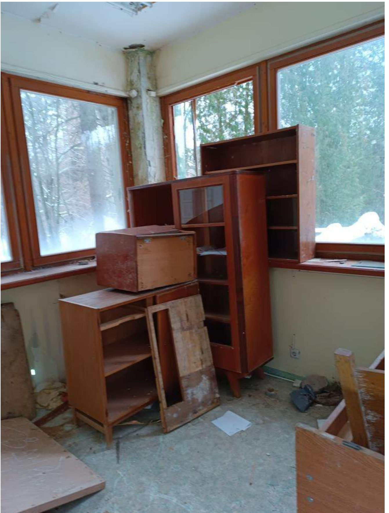
Фото 1.67 Внутренняя часть здания. Основное здание
