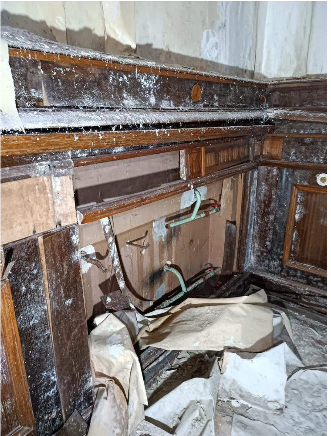
Фото 3.24 Состояние системы отопления. Демонтаж. Основное здание
