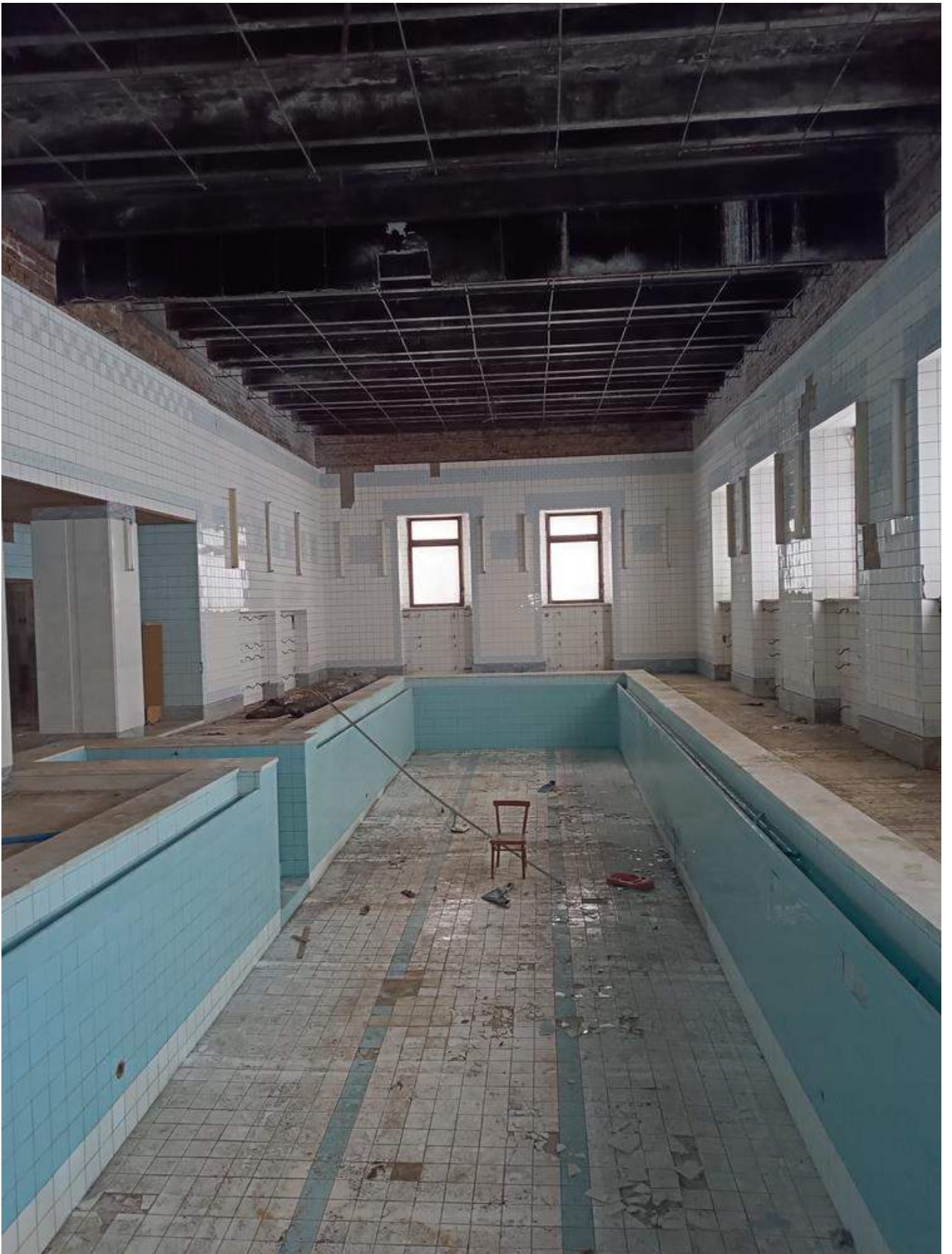
Фото 1.79 Внутренняя часть здания. Бассейн
