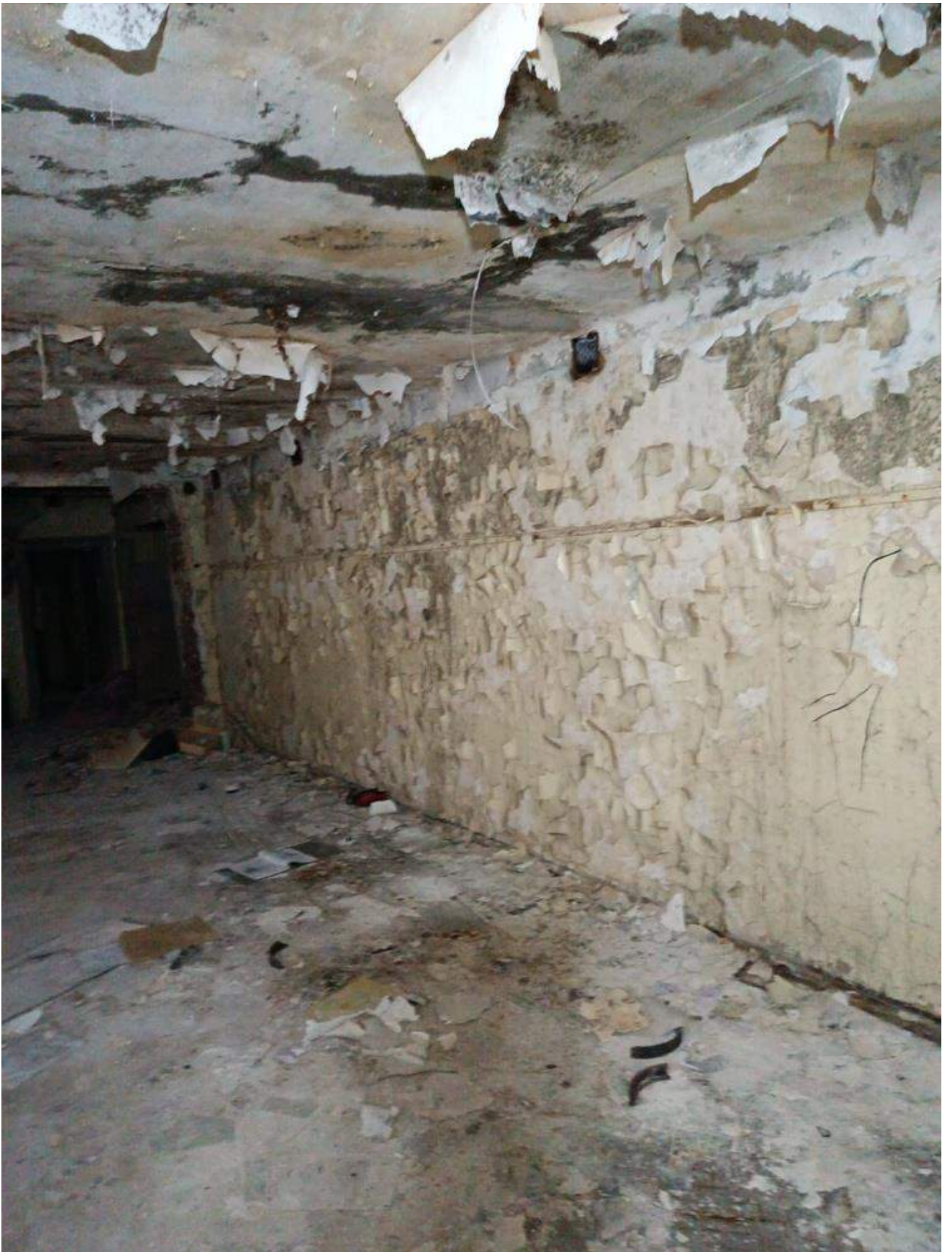
Фото 1.52 Внутренняя часть здания. Основное здание
