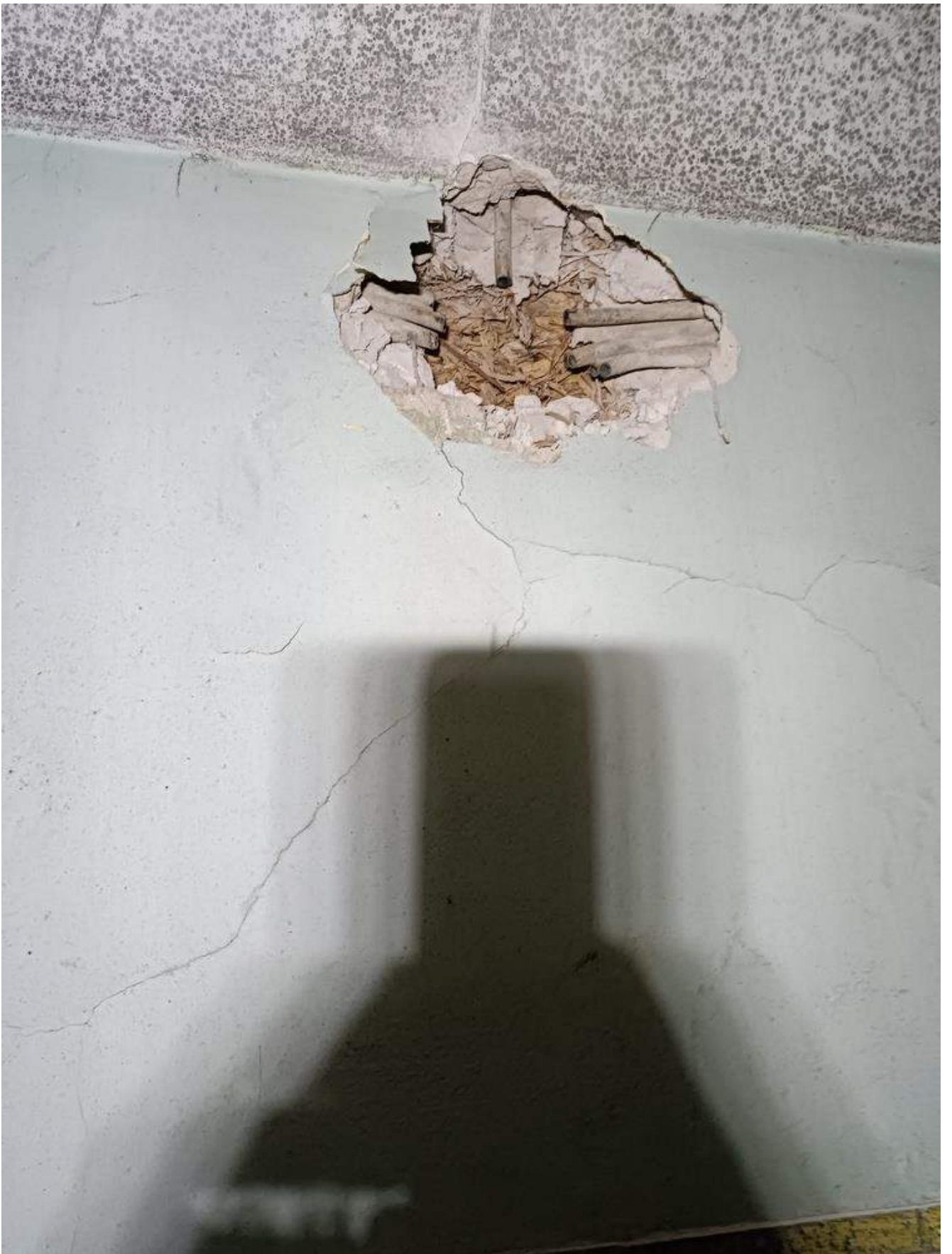
Фото 2.25 Щит управления внутренних электрических сетей. Демонтаж. Бассейн
