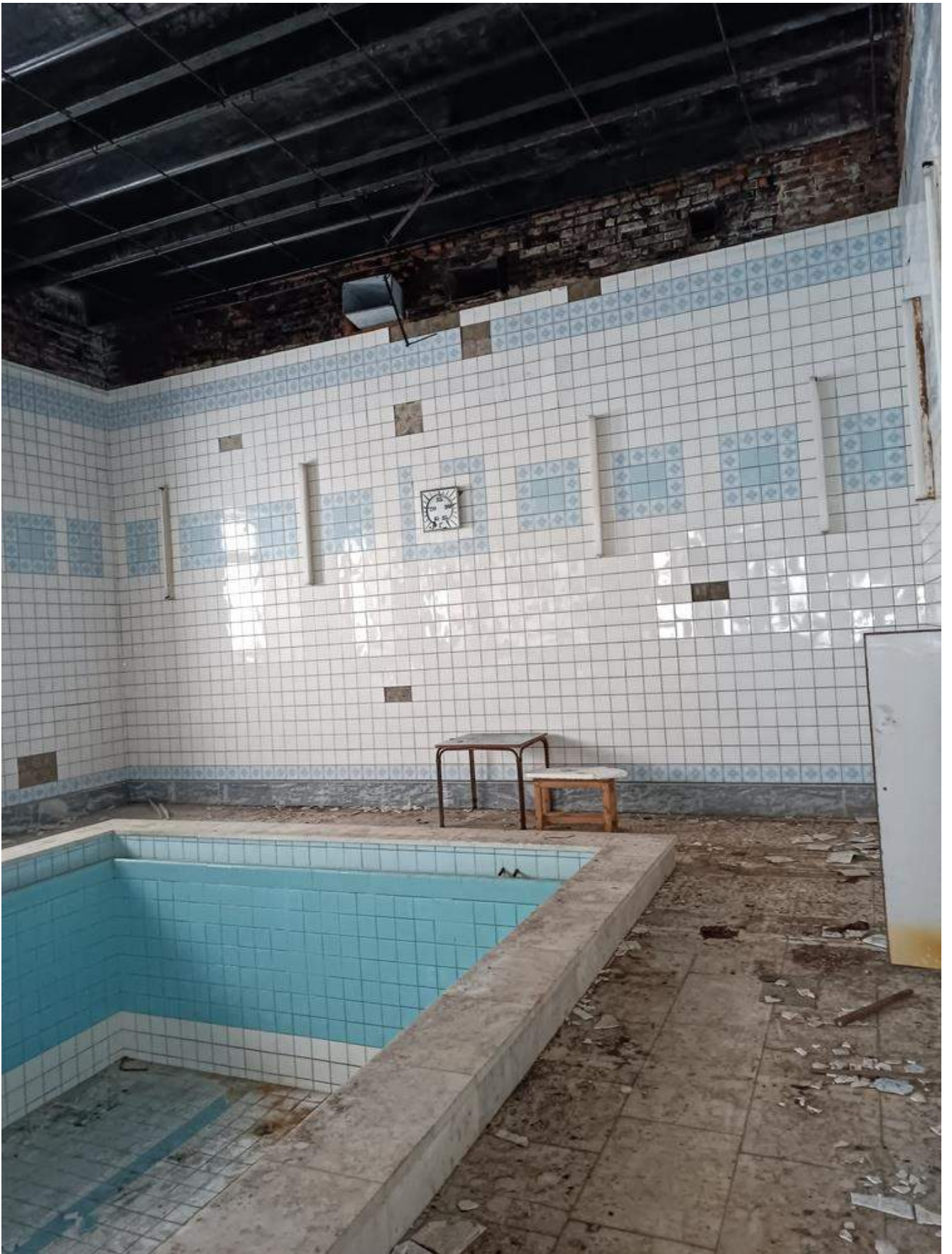
Фото 1.77 Внутренняя часть здания. Бассейн
