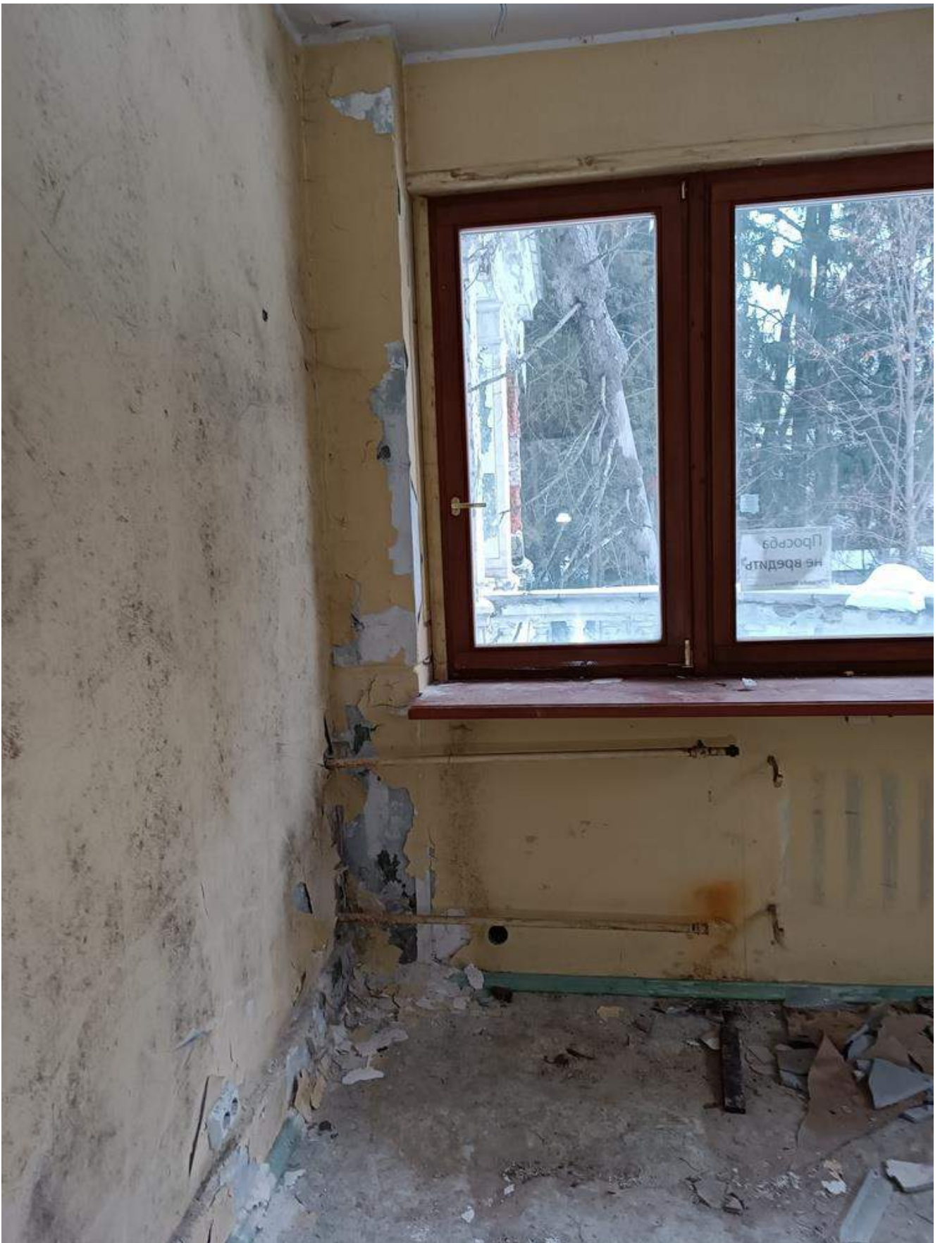
Фото 3.25 Состояние системы отопления. Демонтаж. Основное здание
