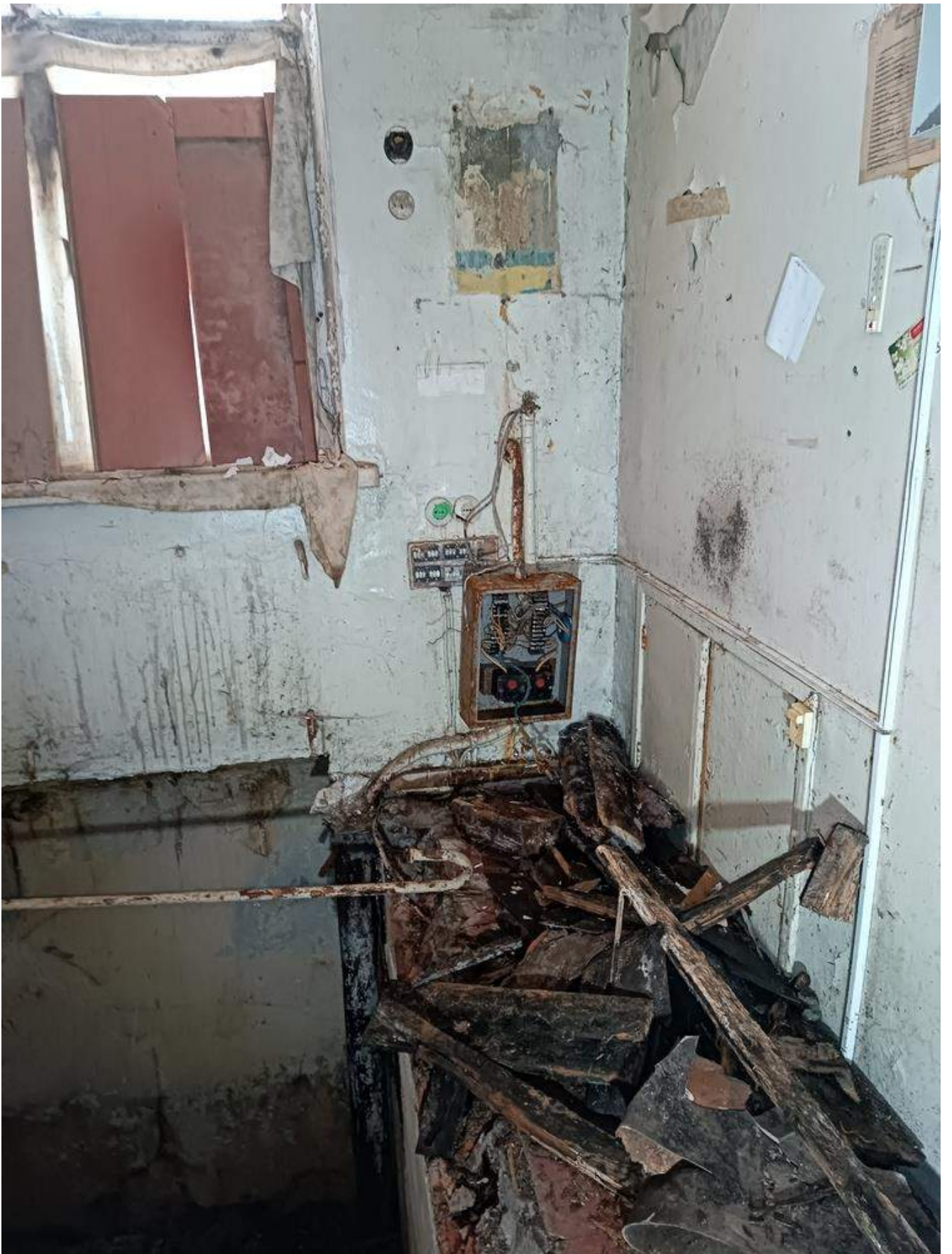
Фото 2.13 Щит управления внутренних электрических сетей. Демонтаж. Административный корпус
