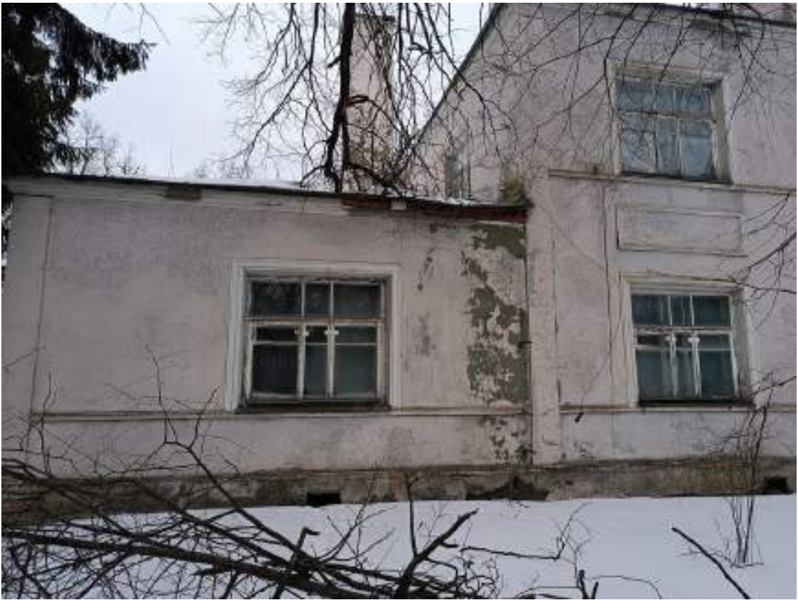
Фото 1.18 Общий вид. Административный корпус
