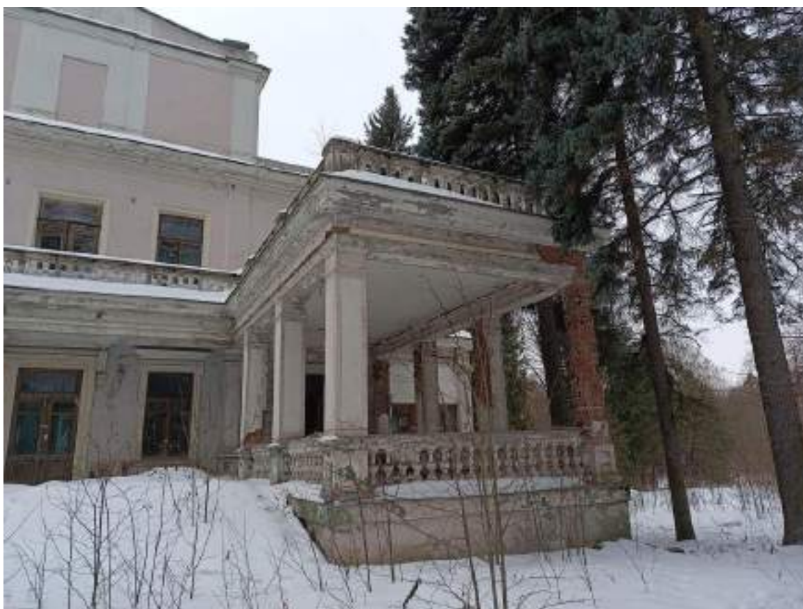
Фото 1.43 Общий вид. Основное здание
