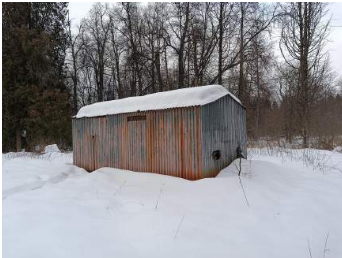
Фото 3.1 Автономный теплоисточник. Котельная
