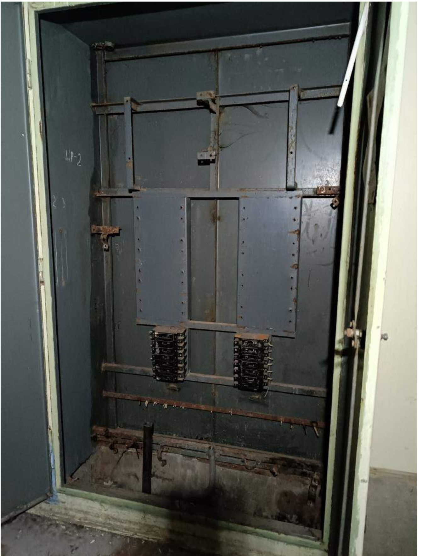
Фото 2.5 Электрощит. Демонтаж. Административный корпус
