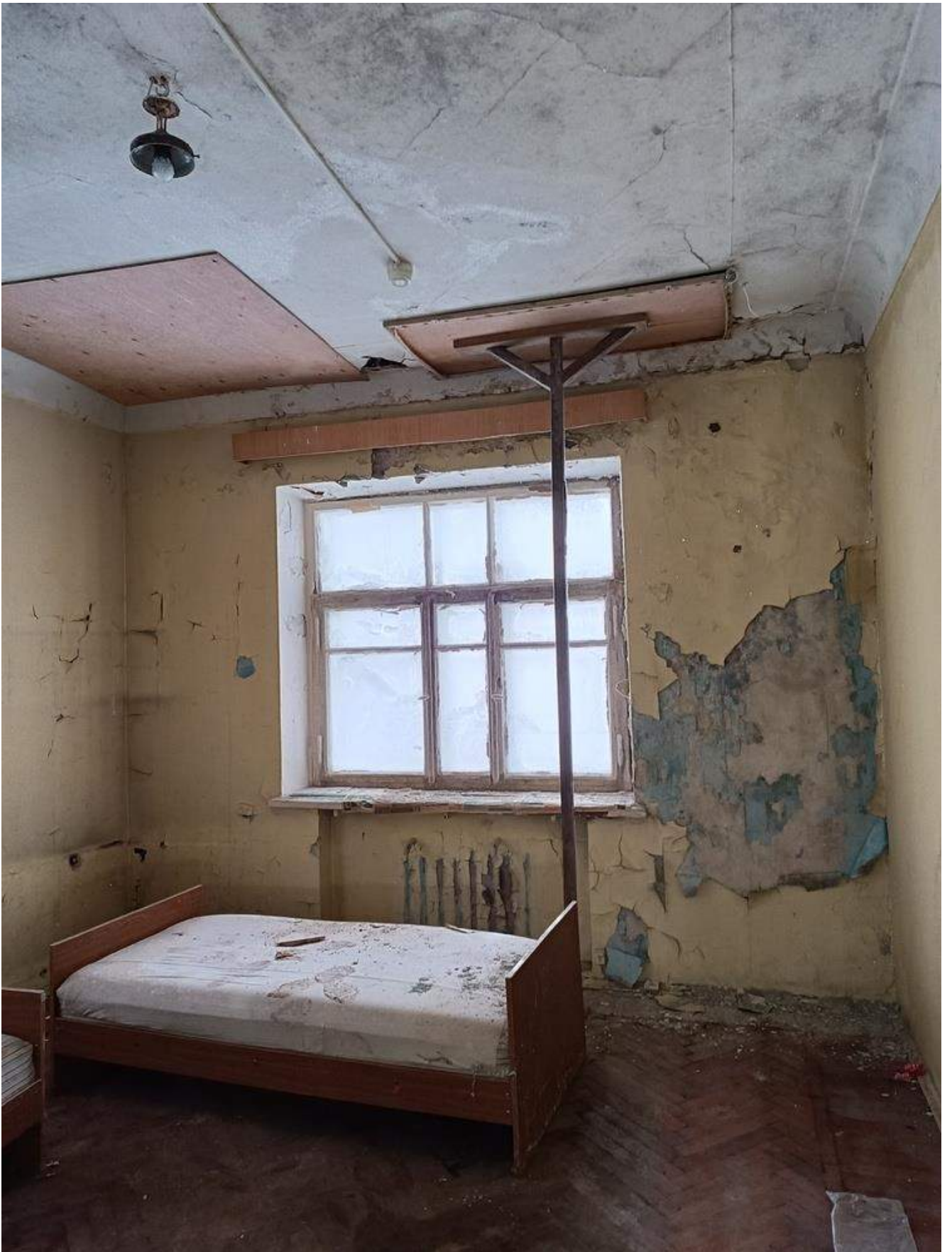
Фото 1.40 Внутренняя часть здания. Административный корпус
