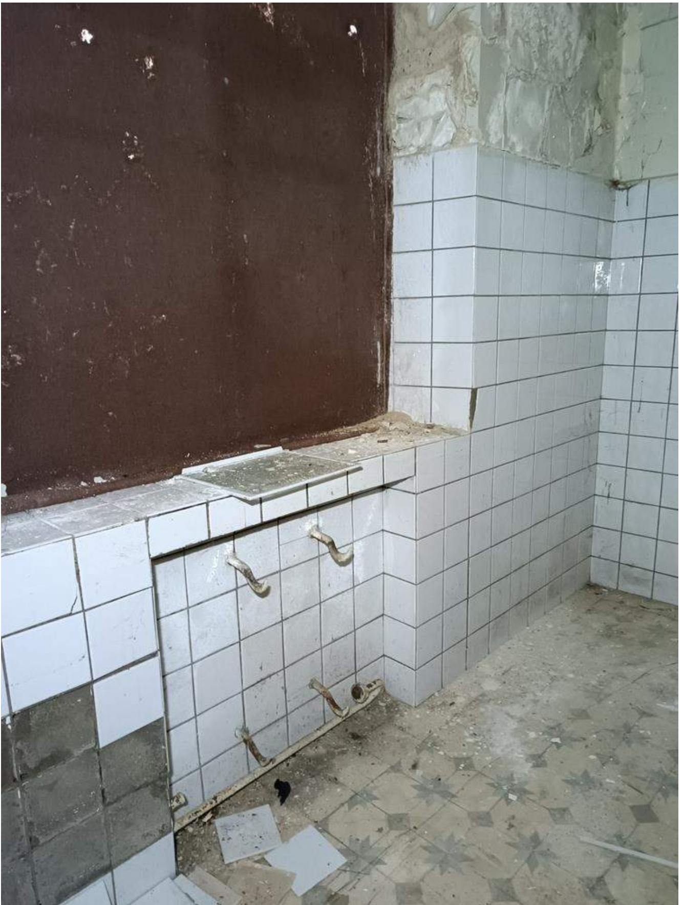
Фото 3.11 Состояние системы отопления. Демонтаж. Административный корпус
