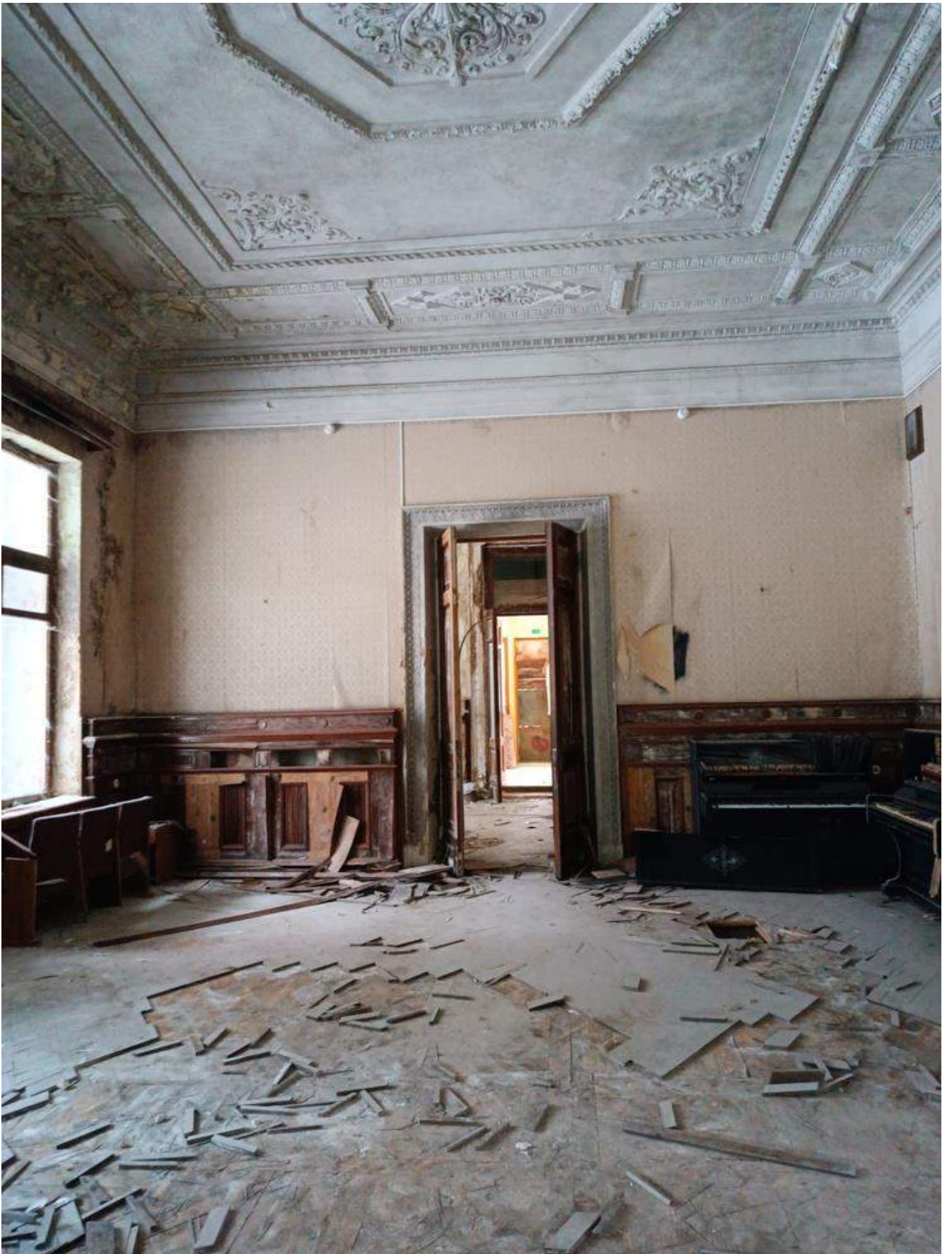
Фото 1.65 Внутренняя часть здания. Основное здание
