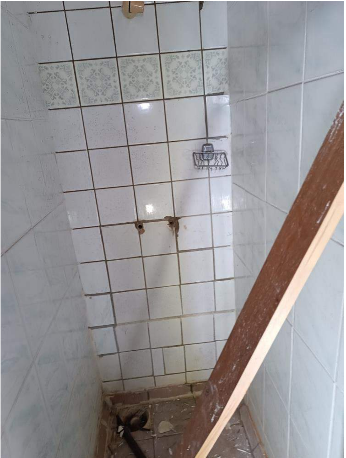
Фото 4.17 Состояние санитарно-технического узла. Демонтаж оборудования. Основное здание
