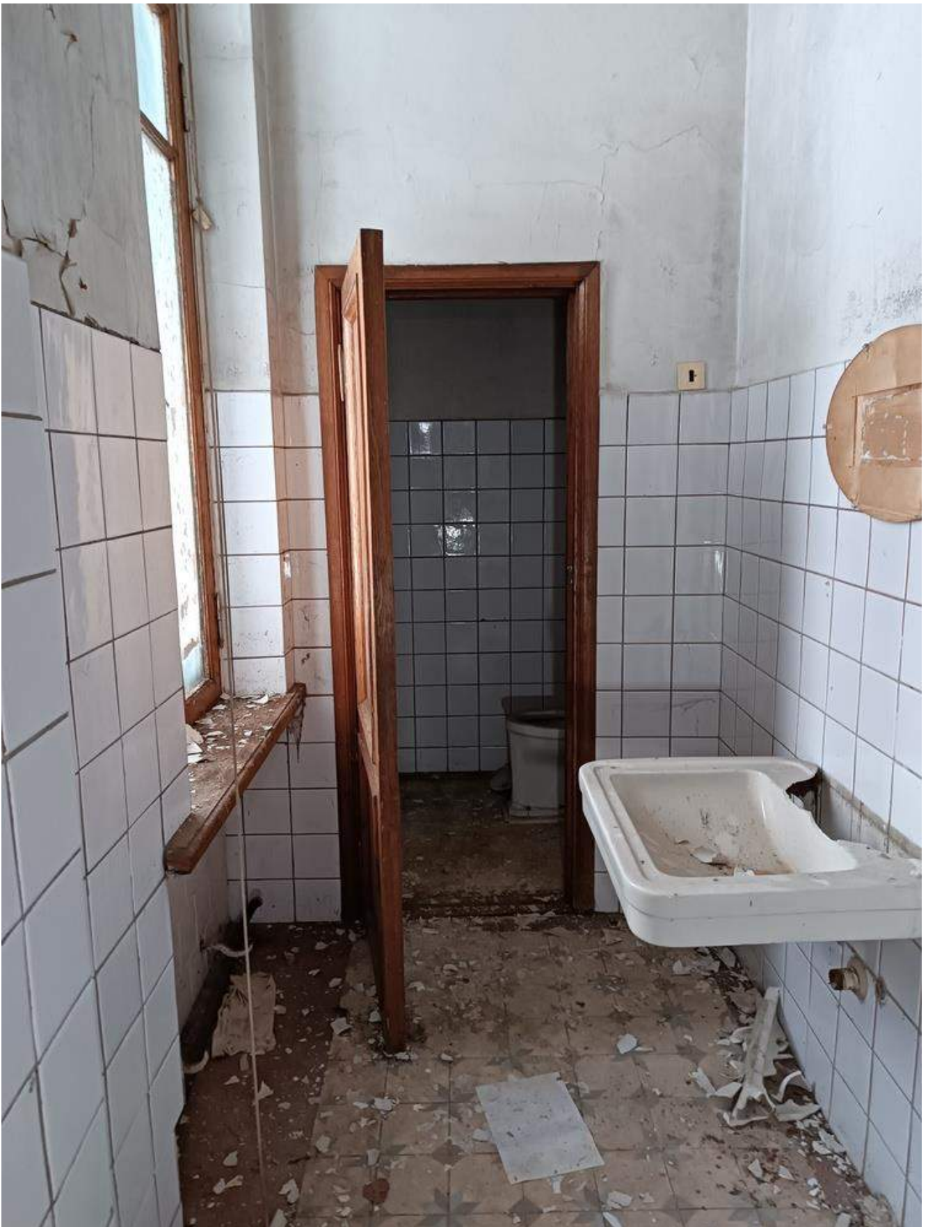
Фото 4.6 Состояние санитарно-технического узла. Демонтаж. Административный корпус
