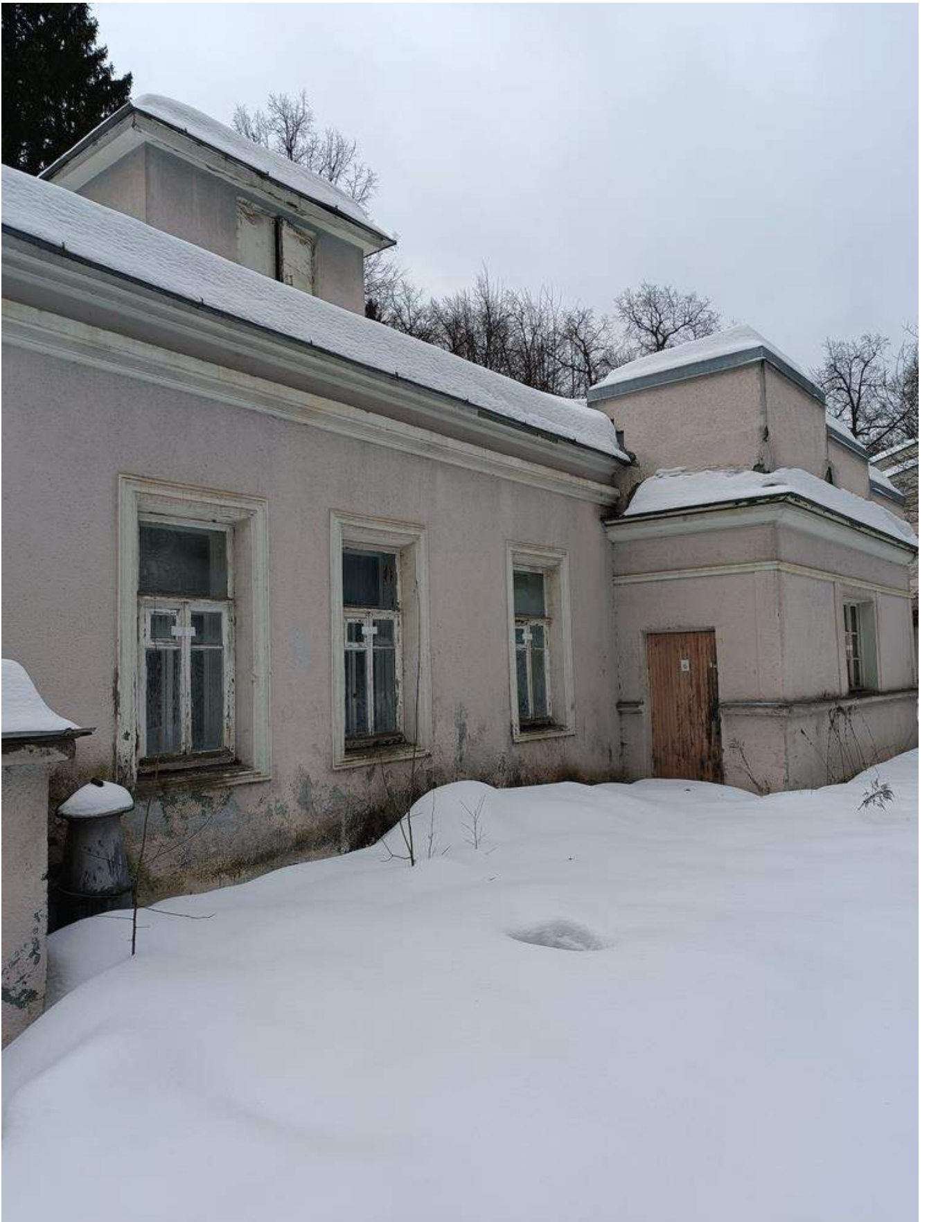
Фото 1.17 Общий вид. Административный корпус
