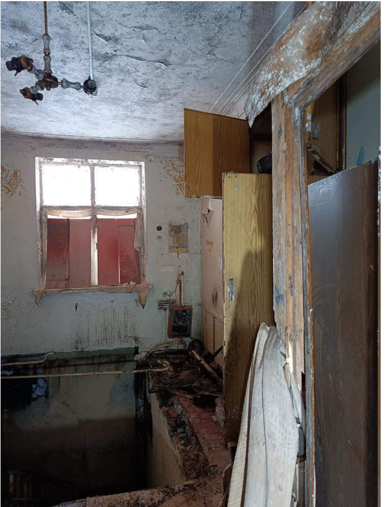
Фото 1.37 Внутренняя часть здания. Административный корпус
