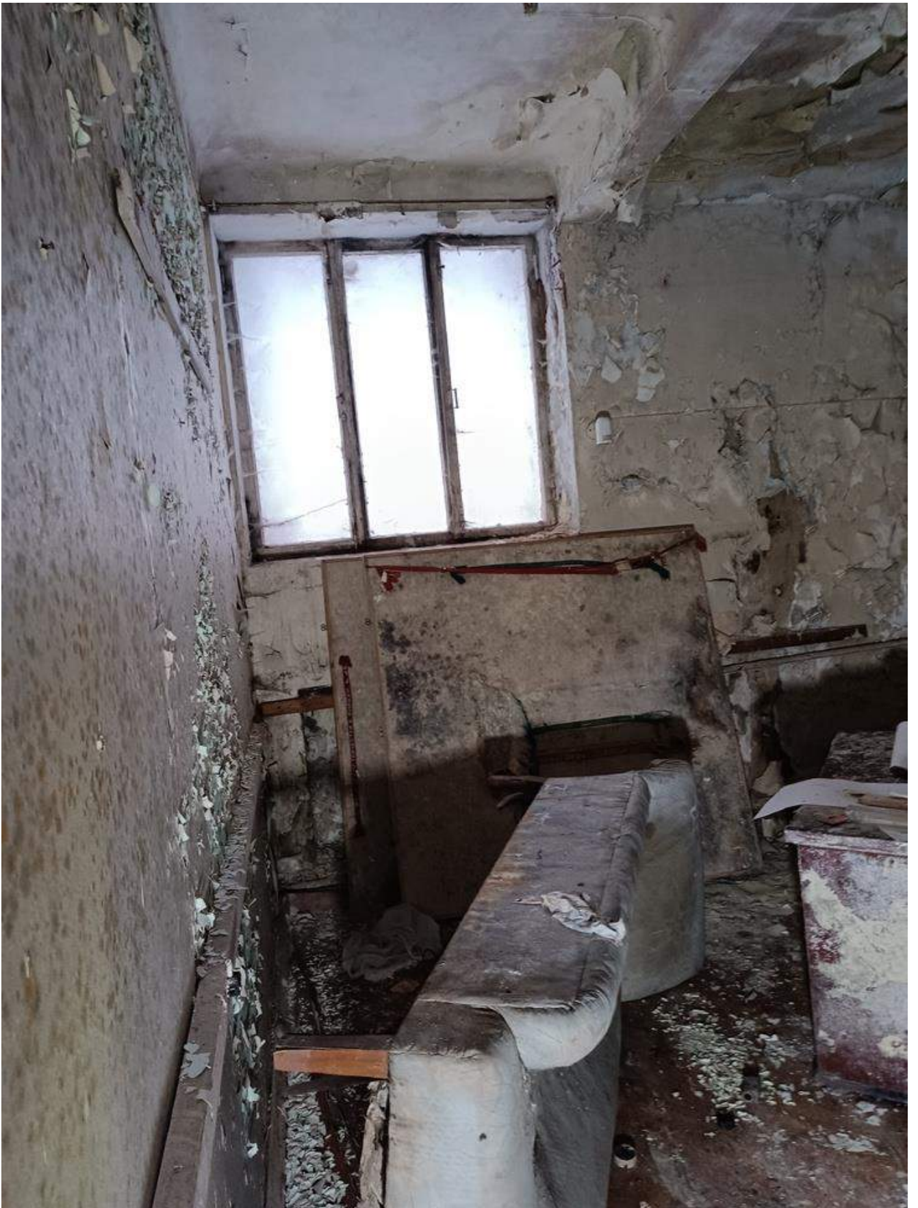
Фото 1.55 Внутренняя часть здания. Основное здание
