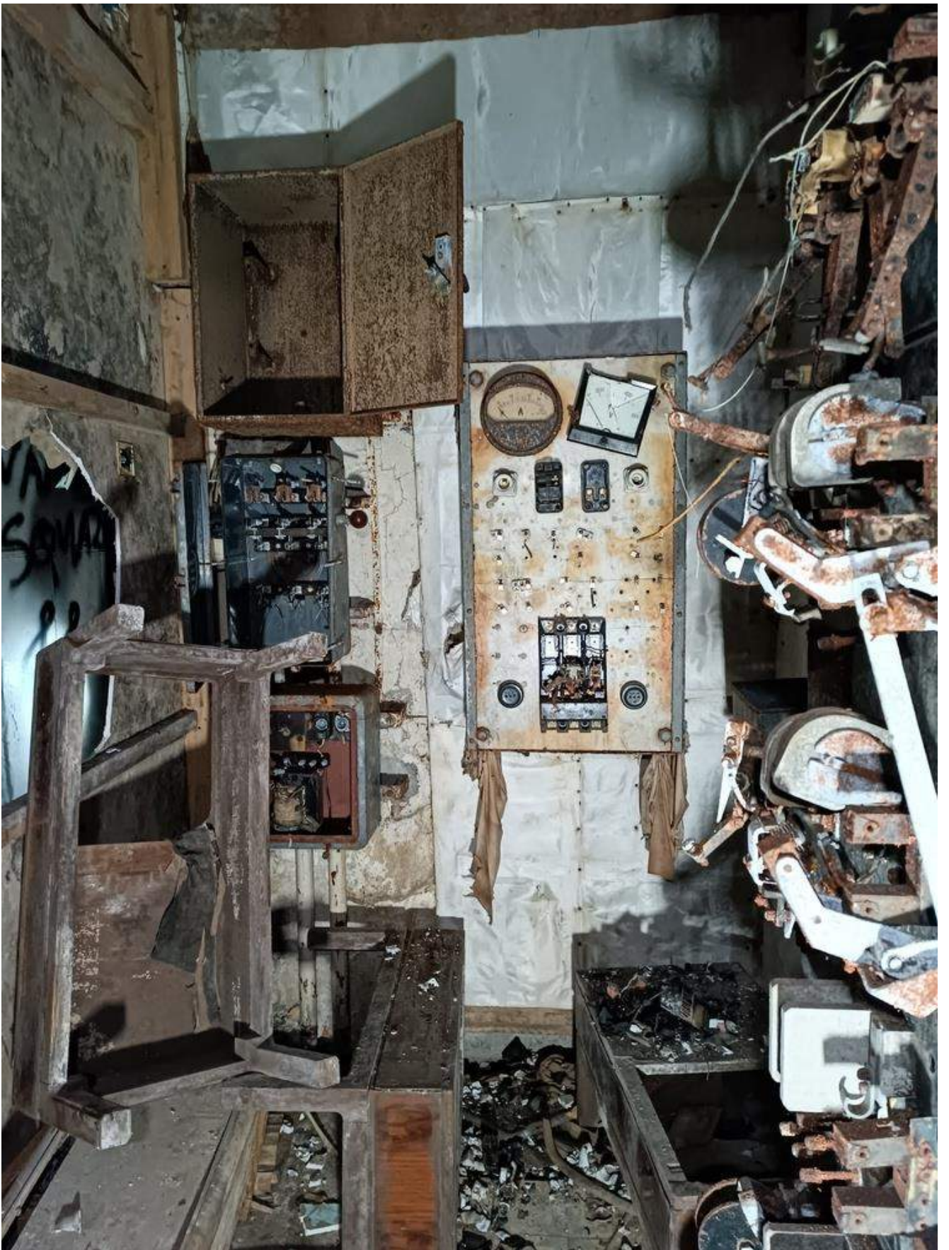
Фото 2.16 Электроцит. Демонтаж. Основное здание
