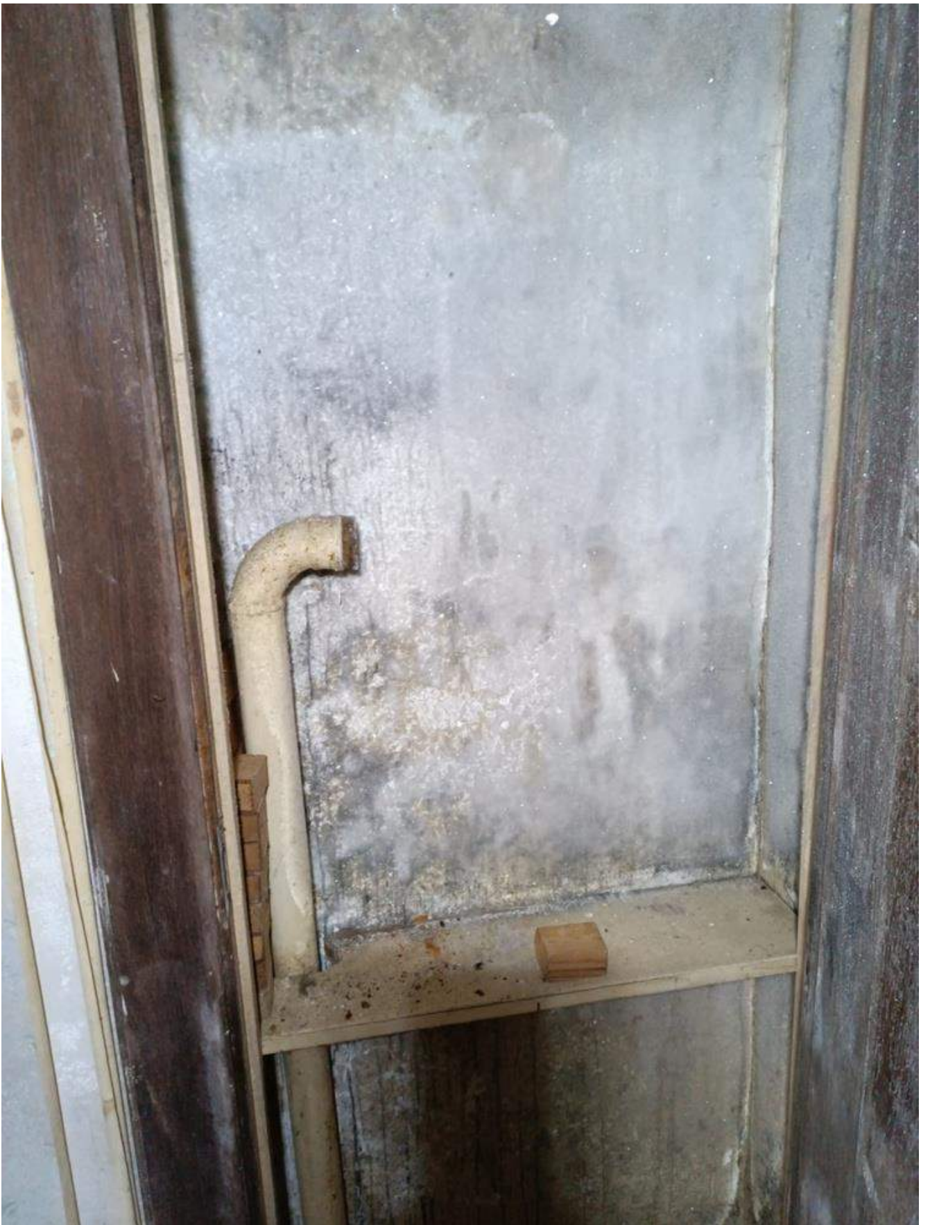
Фото 4.5 Пожарный водопровод. Административный корпус
