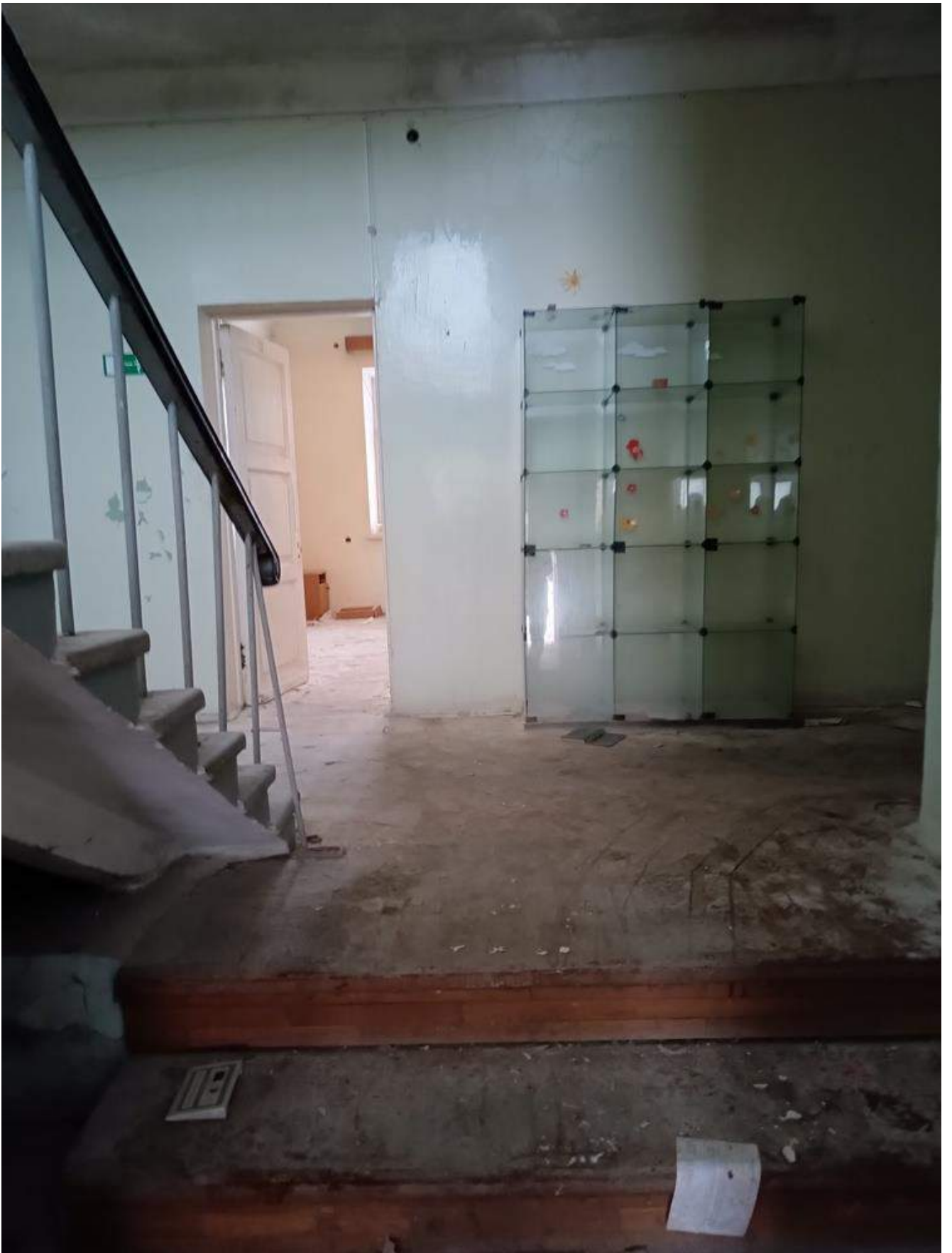
Фото 1.24 Внутренняя часть здания. Административный корпус
