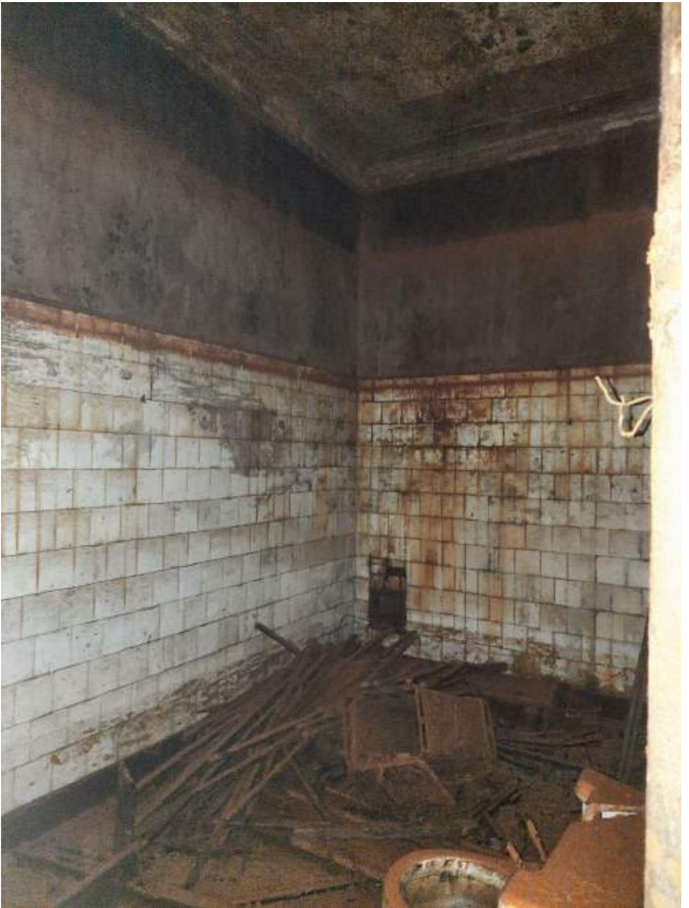
Фото 1.94 Внутренняя часть здания. Бомбоубежище
